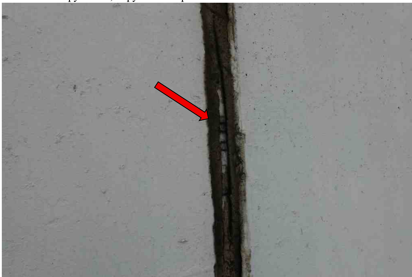
Фото 189. Разрушение, нарушение герметичности шва.
