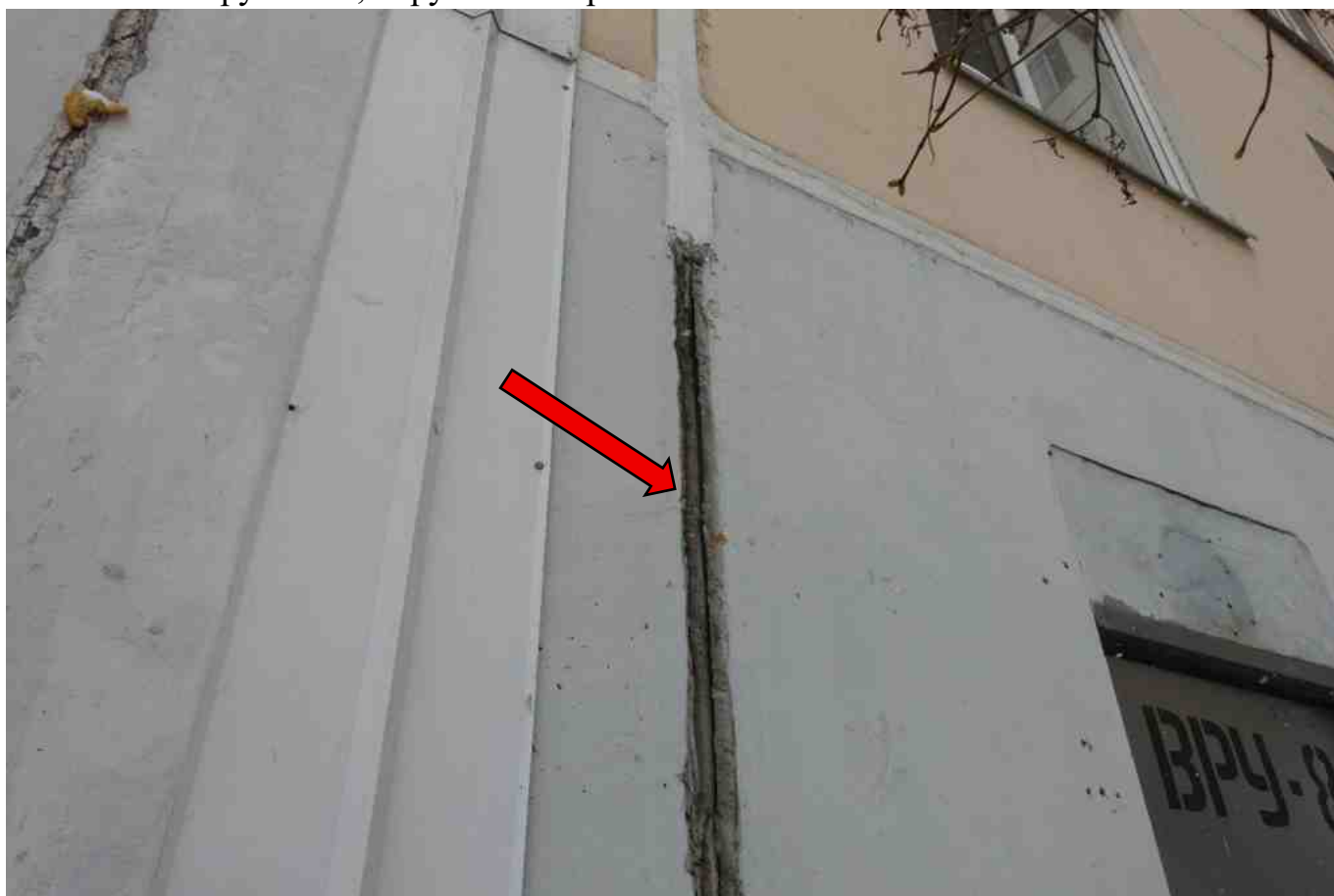
Фото 150. Разрушение, нарушение герметичности шва.
