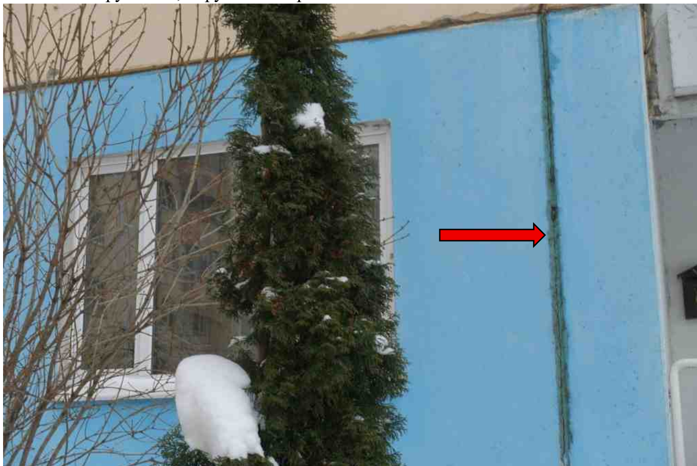
Фото 56. Разрушение, нарушение герметичности шва.
