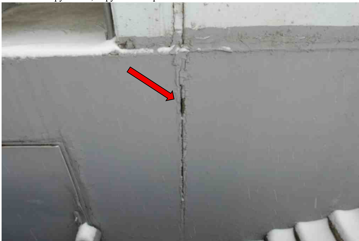
Фото 62. Разрушение, нарушение герметичности шва.
