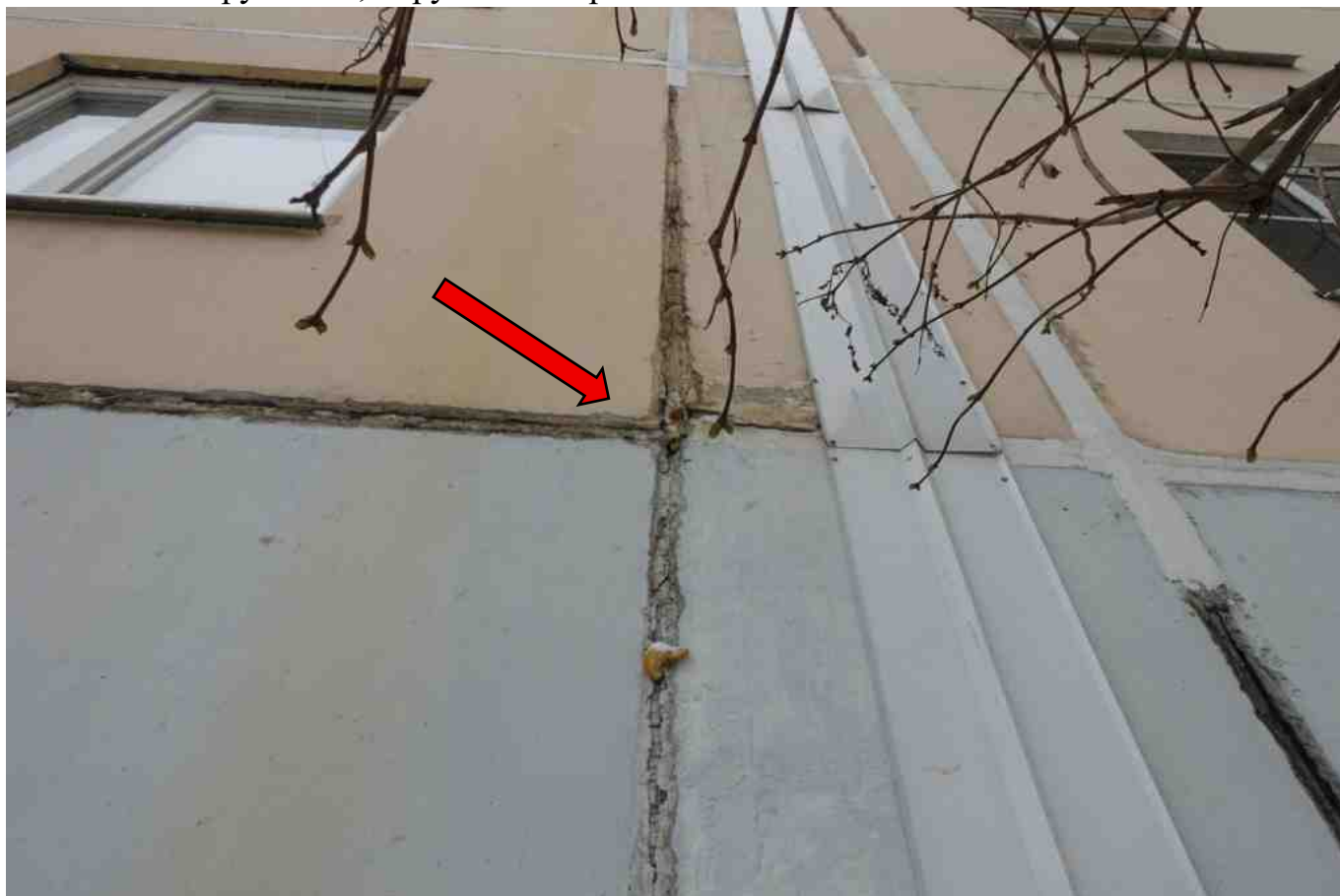
Фото 150. Разрушение, нарушение герметичности шва.
