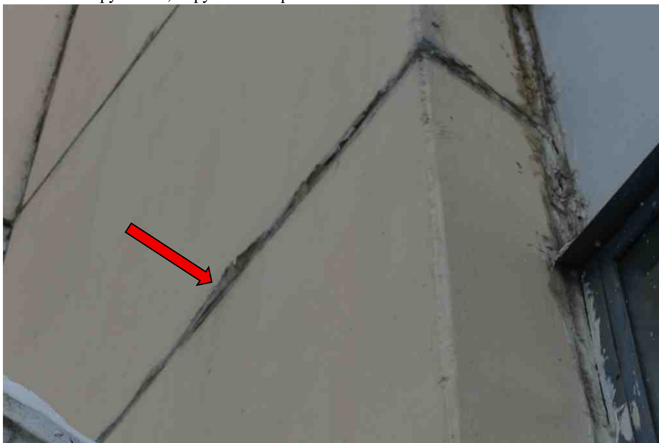
Фото 66. Разрушение, нарушение герметичности шва.
