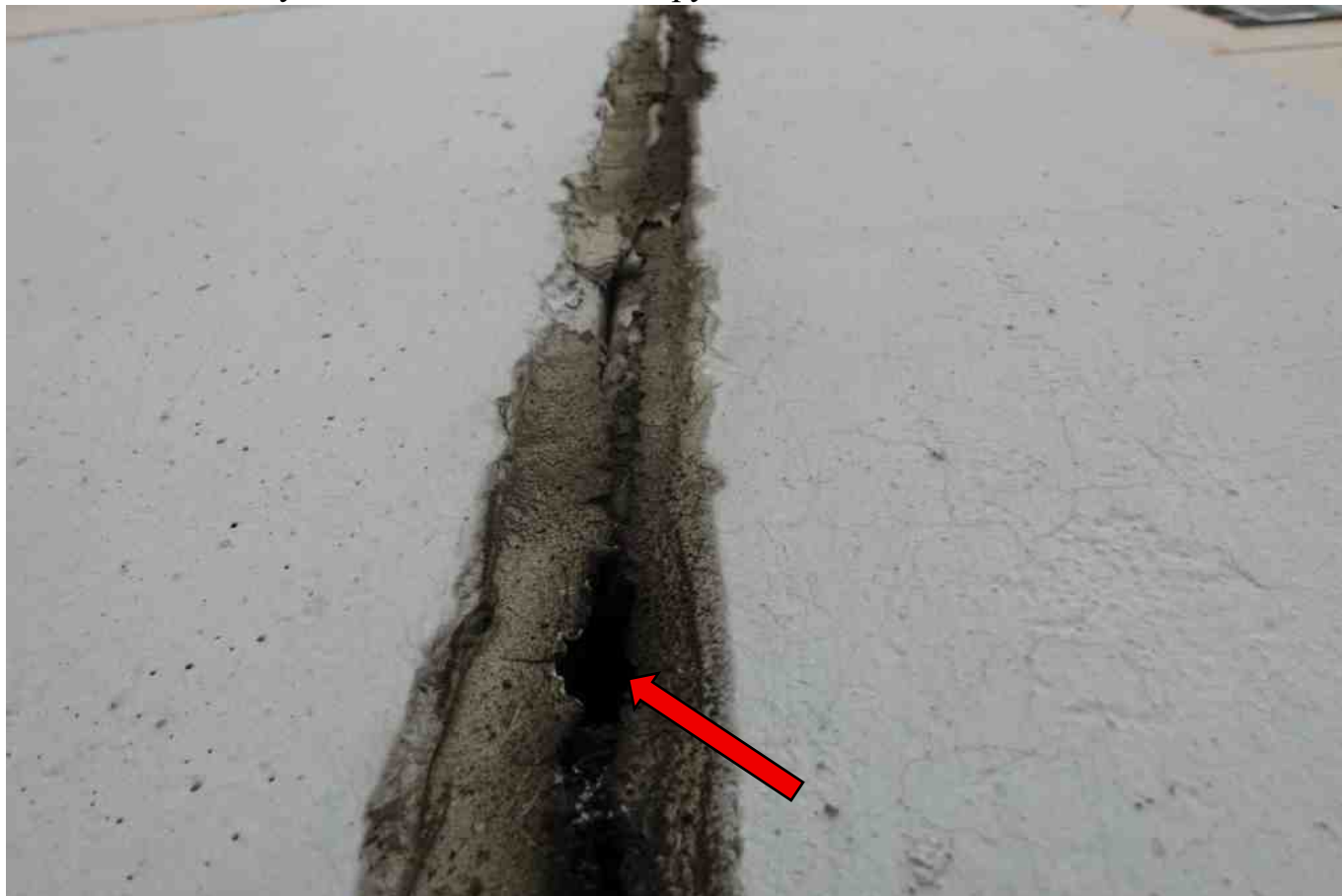
Фото 132. Разрушение вилатерма, герметика, нарушение герметичности шва.
