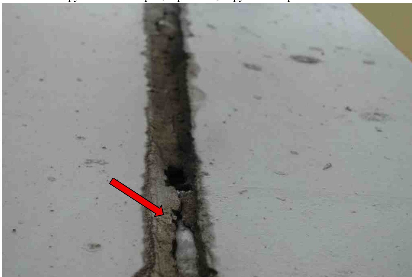
Фото 102. Разрушение вилатерма, герметика, нарушение герметичности шва.
