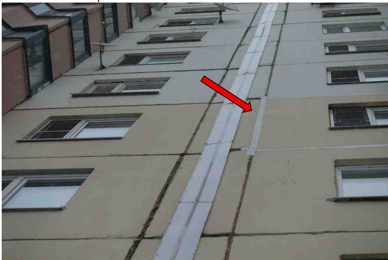
Фото 96. Локальный ремонт межпанельных швов.
