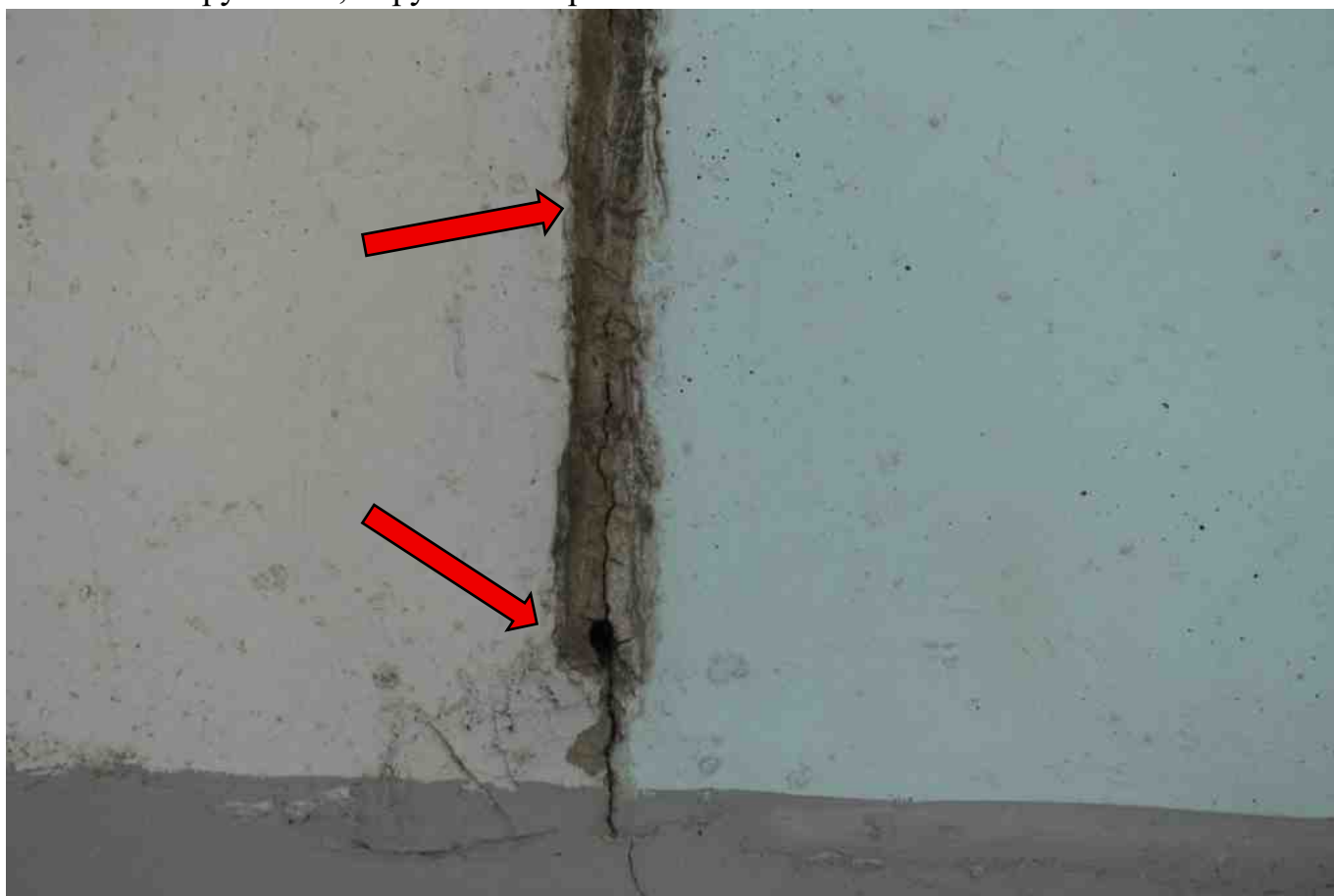
Фото 98. Разрушение, нарушение герметичности шва.
