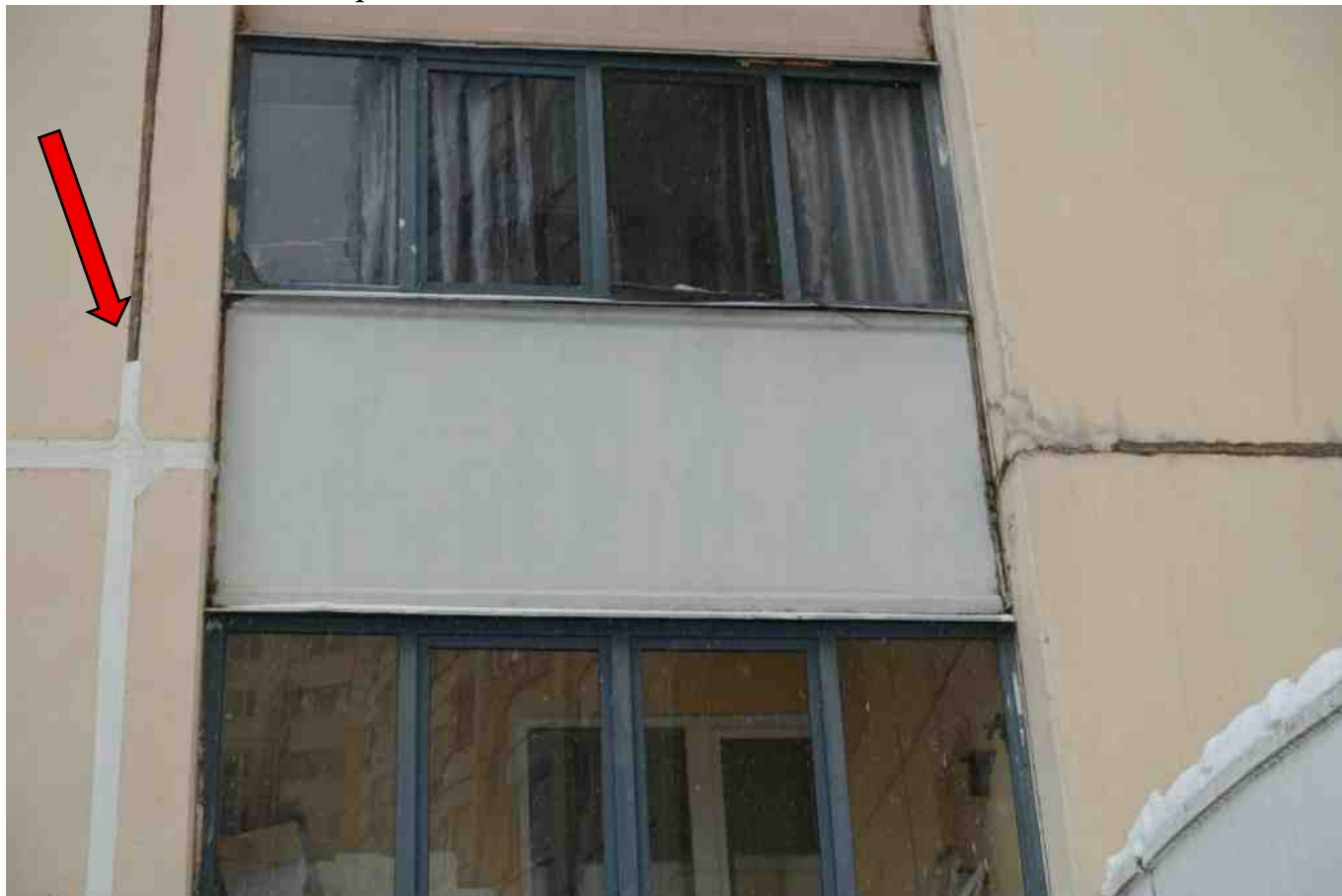
Фото 144. Разрушение, нарушение герметичности шва.
