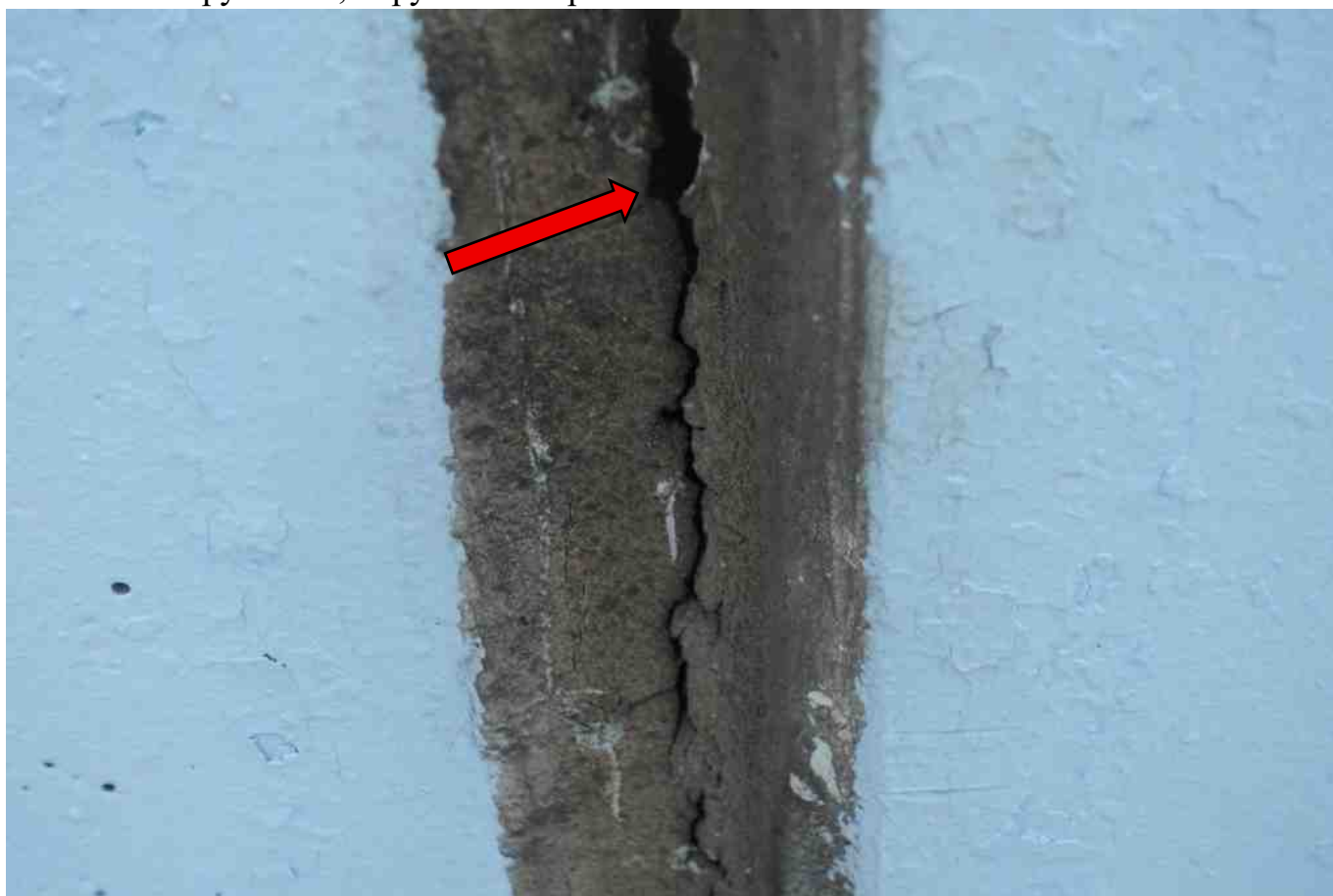
Фото 38. Разрушение, нарушение герметичности шва.
