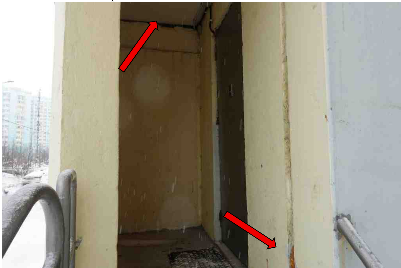
Фото 253. Разрушение, нарушение герметичности шва. Пена выгорела.
