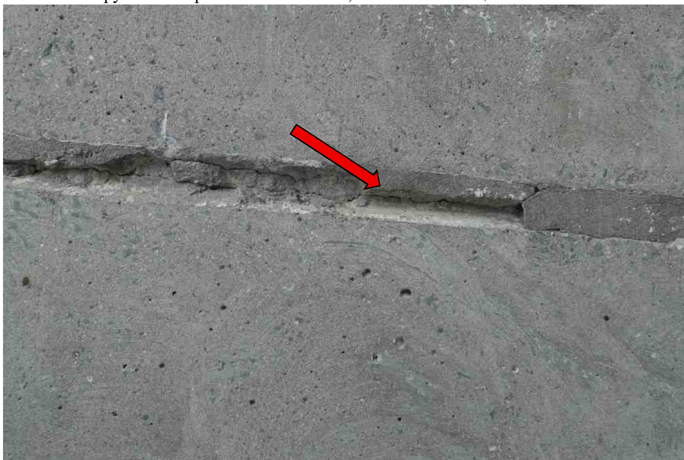
Фото 28. Разрушение горизонтального шва, заполнение на цементной основе.
