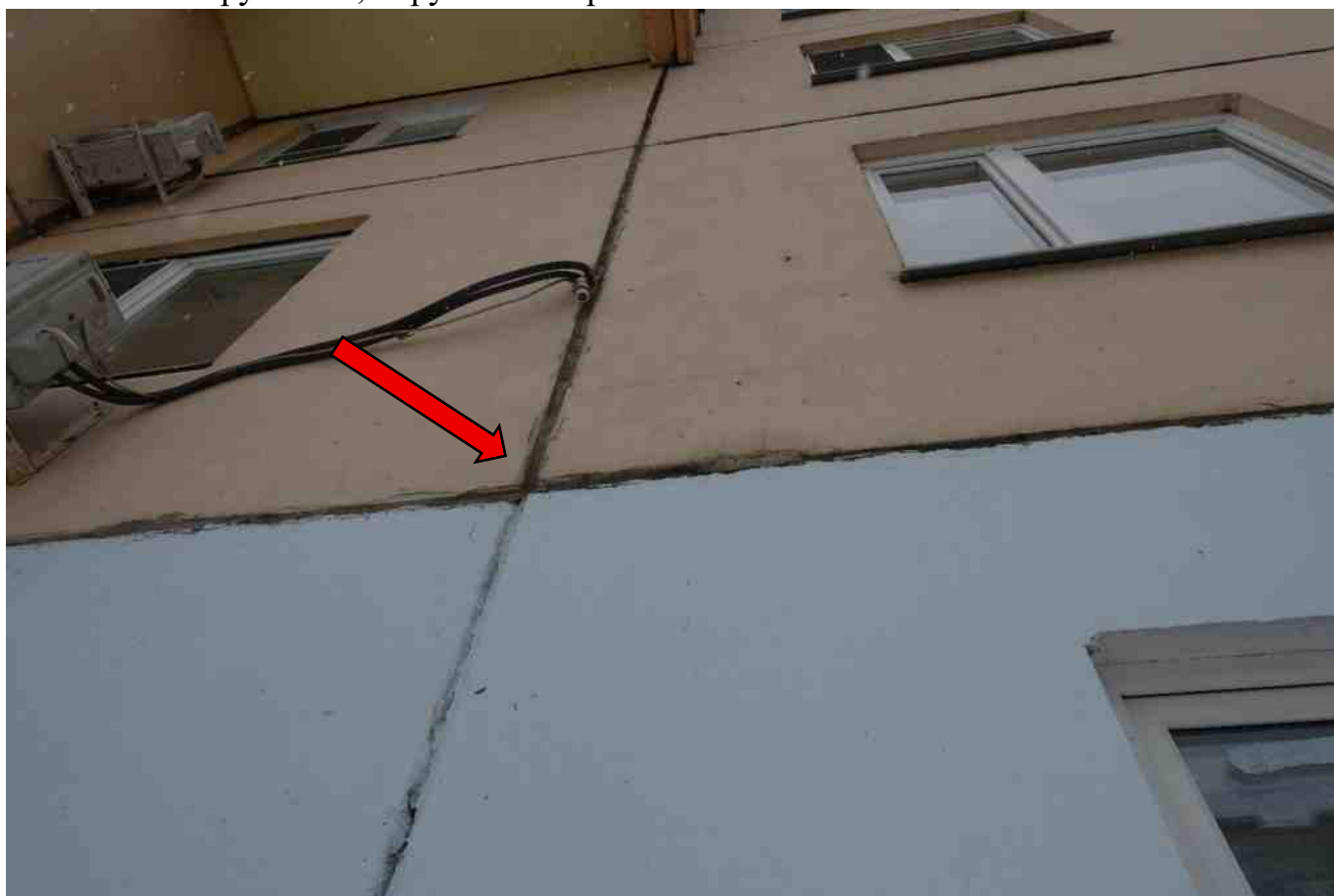
Фото 257. Разрушение, нарушение герметичности шва.
