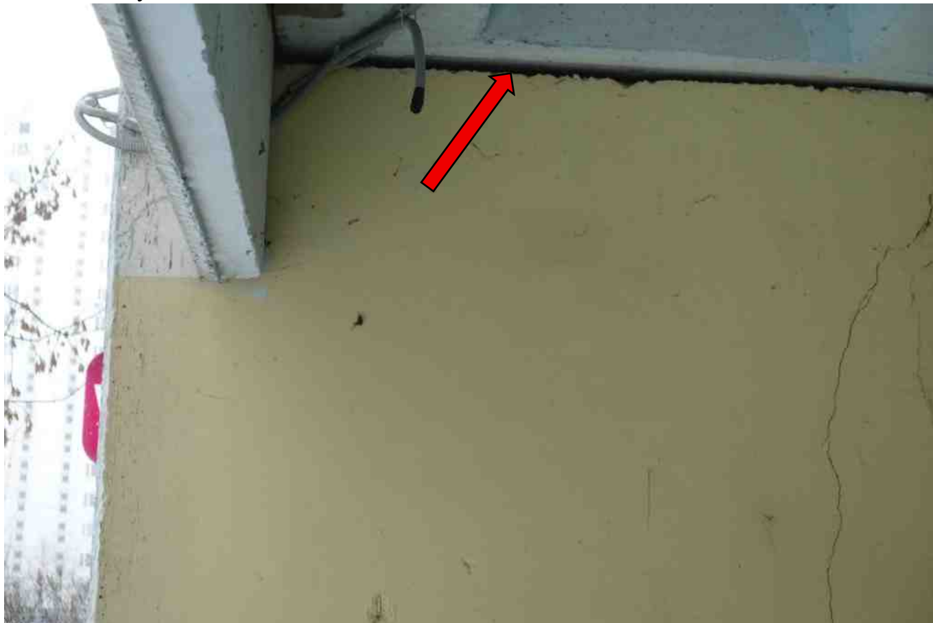
Фото 162. Разрушение, нарушение герметичности шва.
