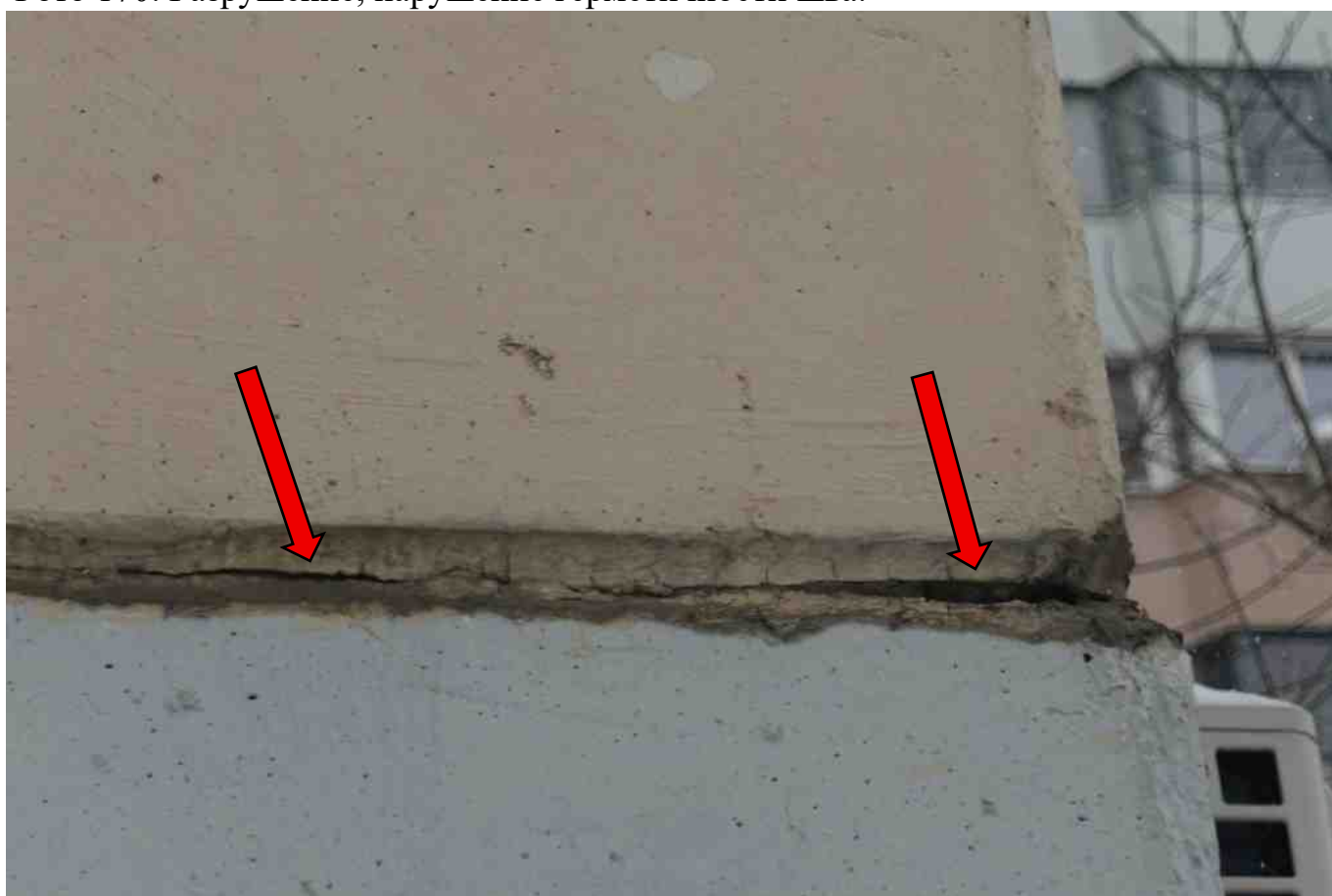
Фото 170. Разрушение, нарушение герметичности шва.
