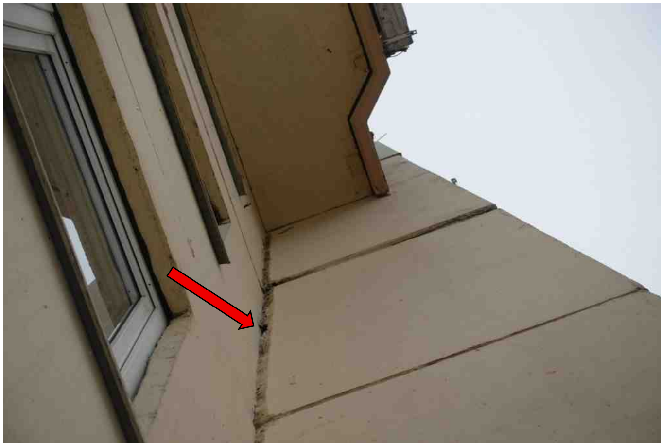
Фото 168. Разрушение, нарушение герметичности шва.
