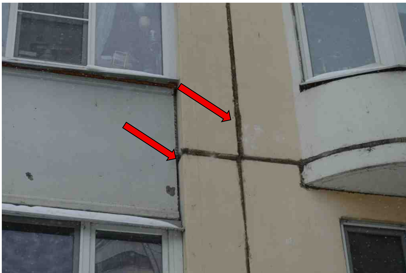
Фото 176. Разрушение, нарушение герметичности шва.
