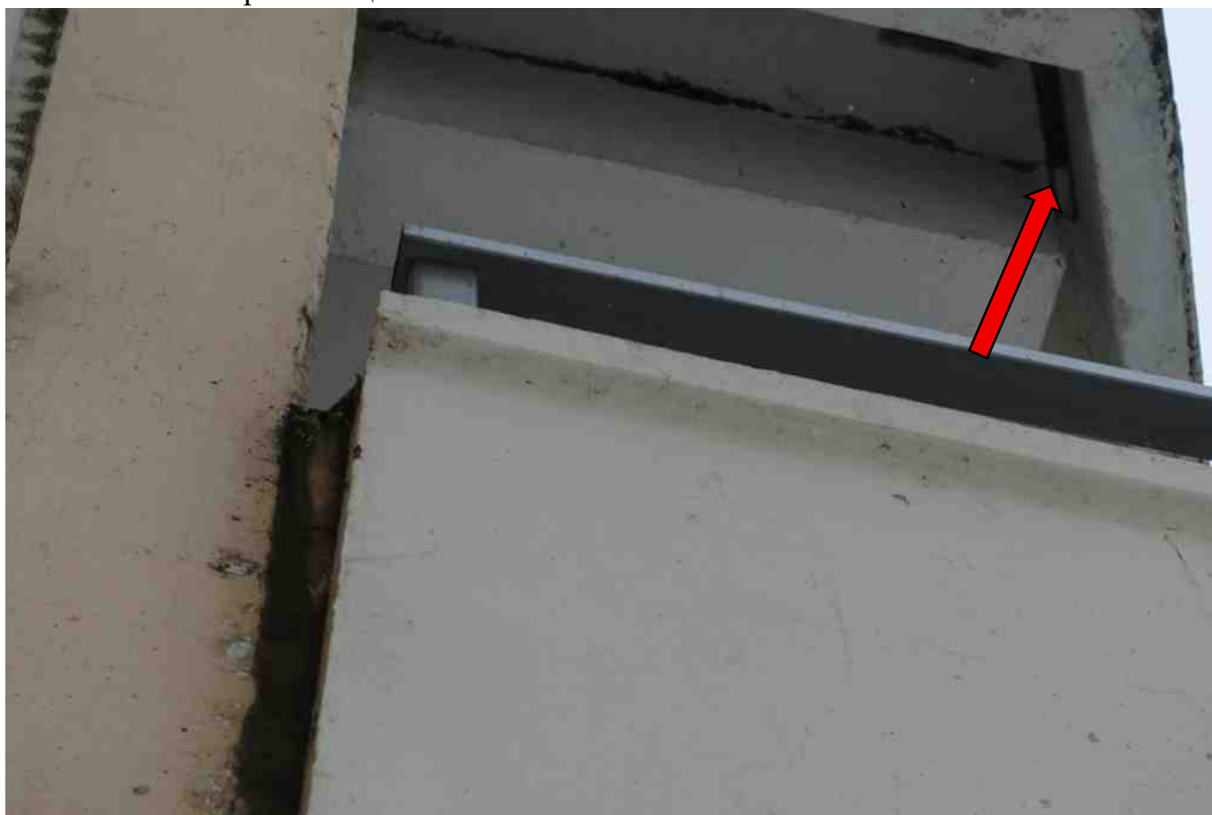
Фото 221. Нет герметизации шва.
