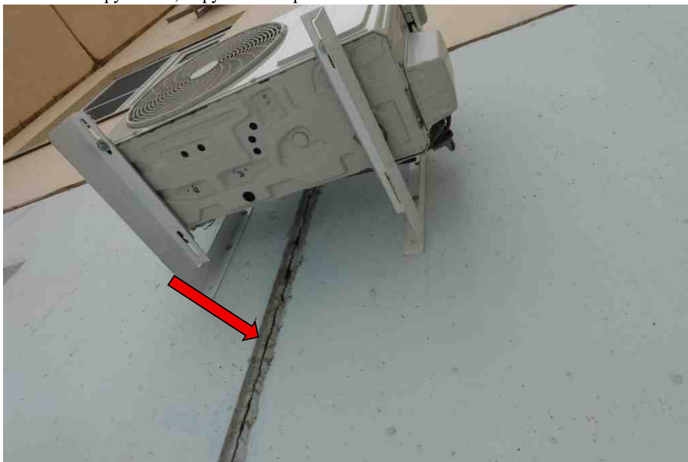
Фото 76. Разрушение, нарушение герметичности шва.
