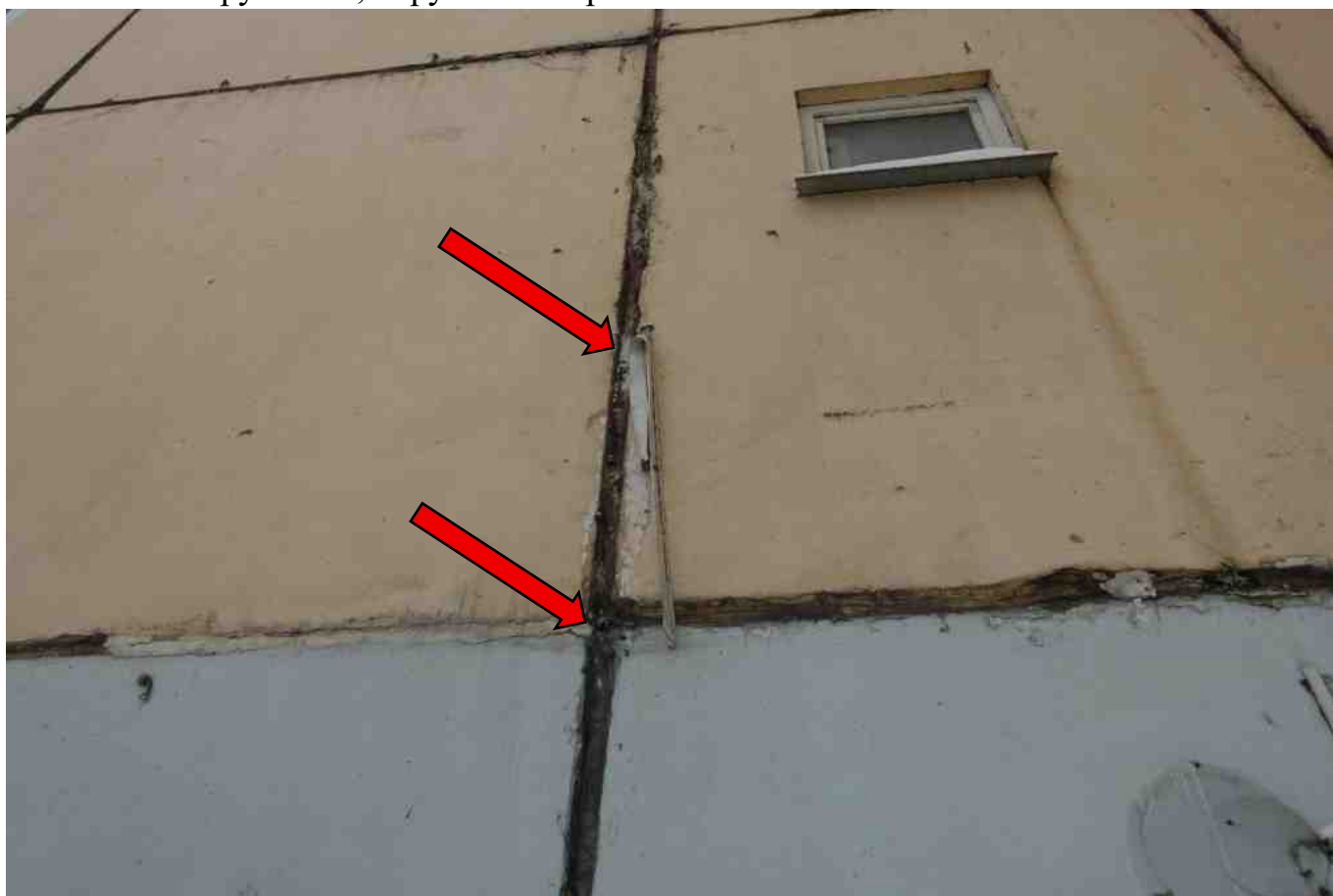
Фото 235. Разрушение, нарушение герметичности шва.
