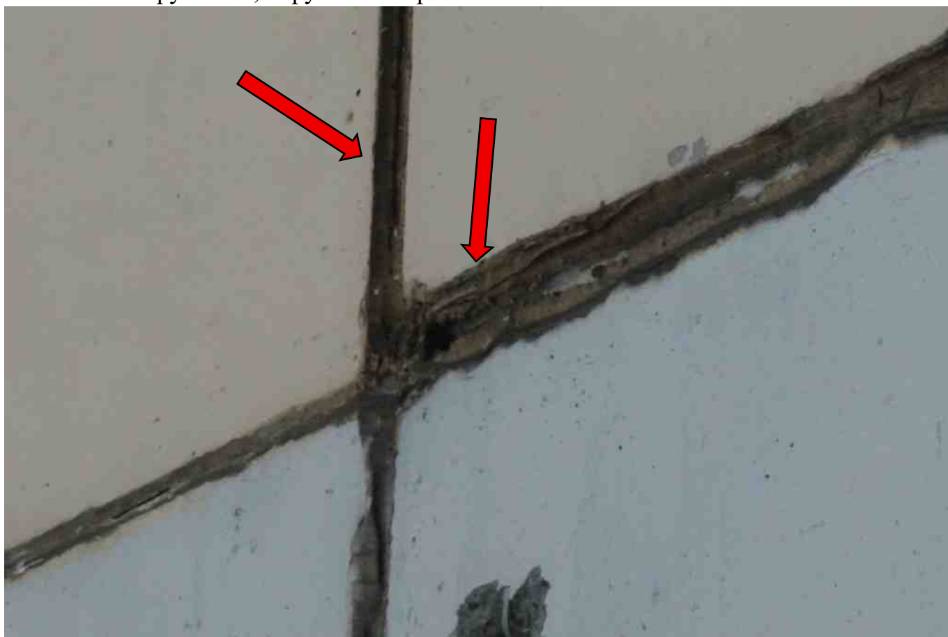
Фото 187. Разрушение, нарушение герметичности шва.
