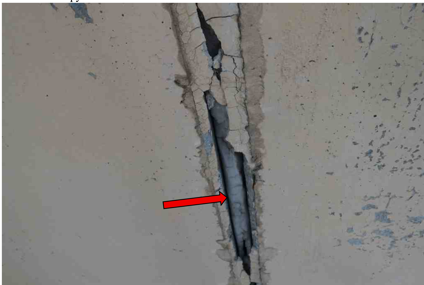
Фото 295. Разрушение монтажного межпанельного шва.
