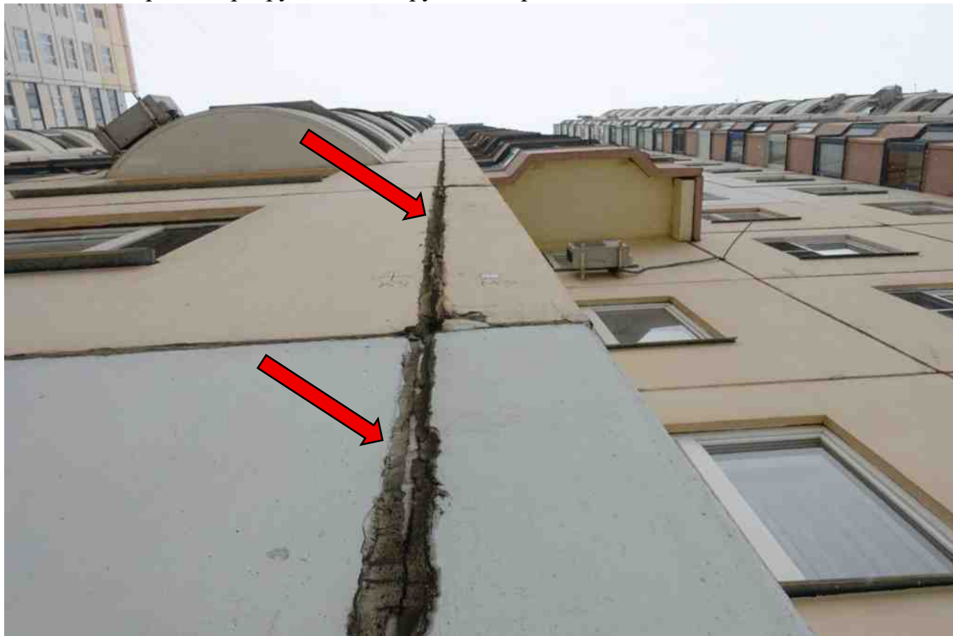
Фото 134. Разрушение, нарушение герметичности шва.
