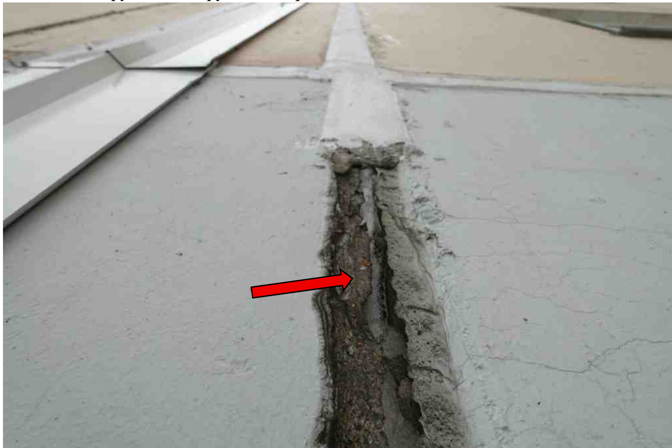
Фото 154. При нажатии на вилатерм он рассыпается, не работает как утеплитель.
