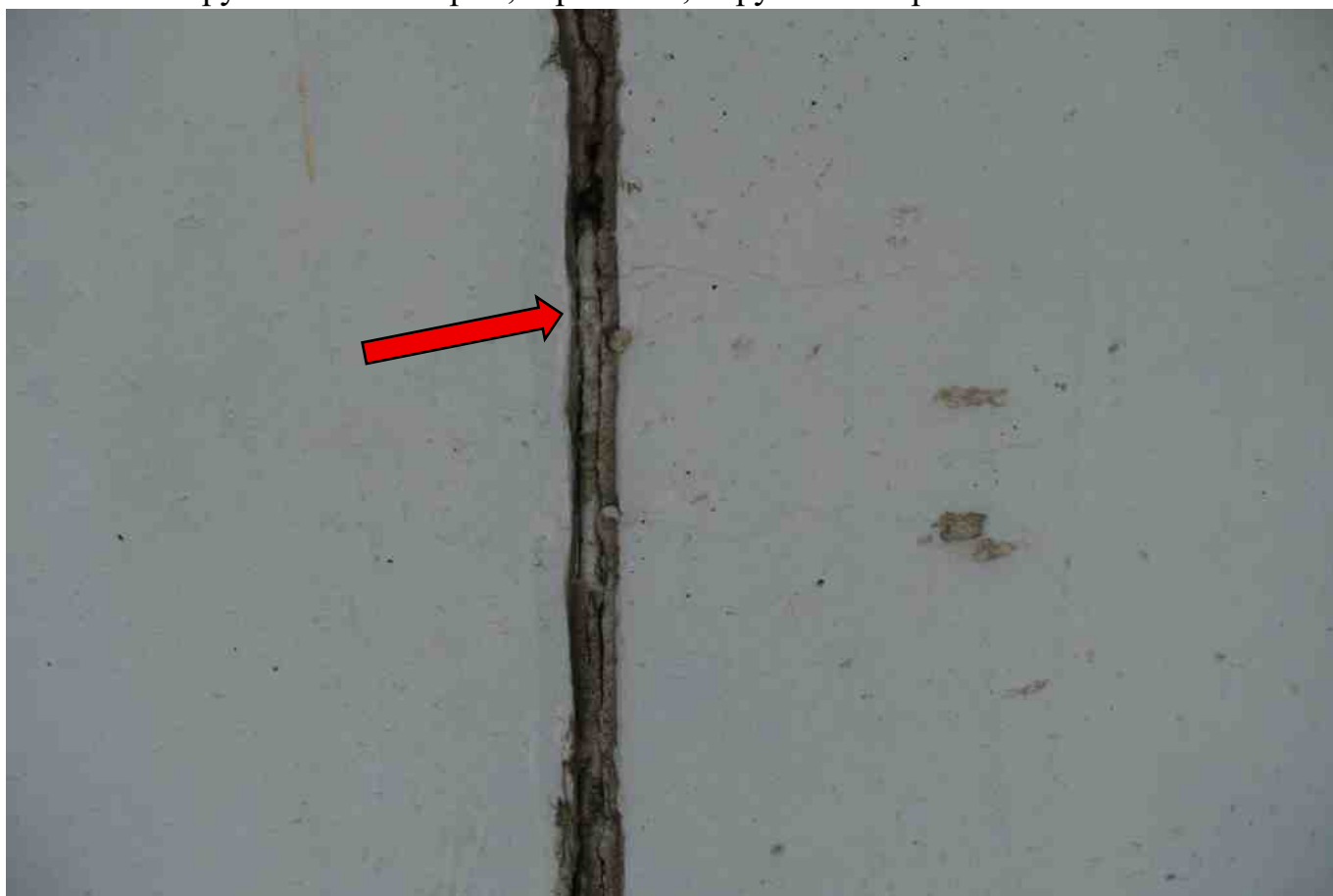
Фото 88. Разрушение вилатерма, герметика, нарушение герметичности шва.
