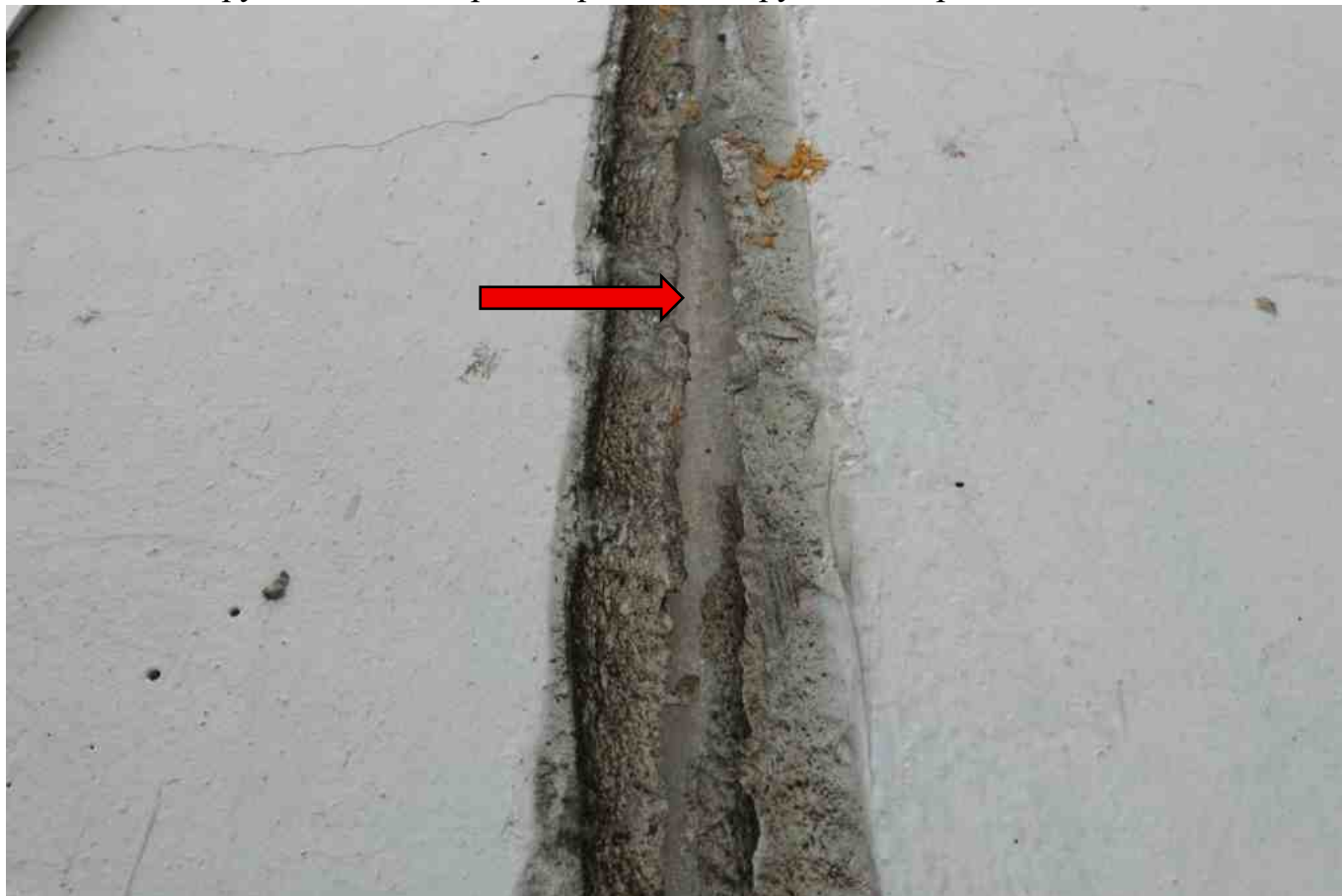
Фото 152. Не допустимое состояние шва.
