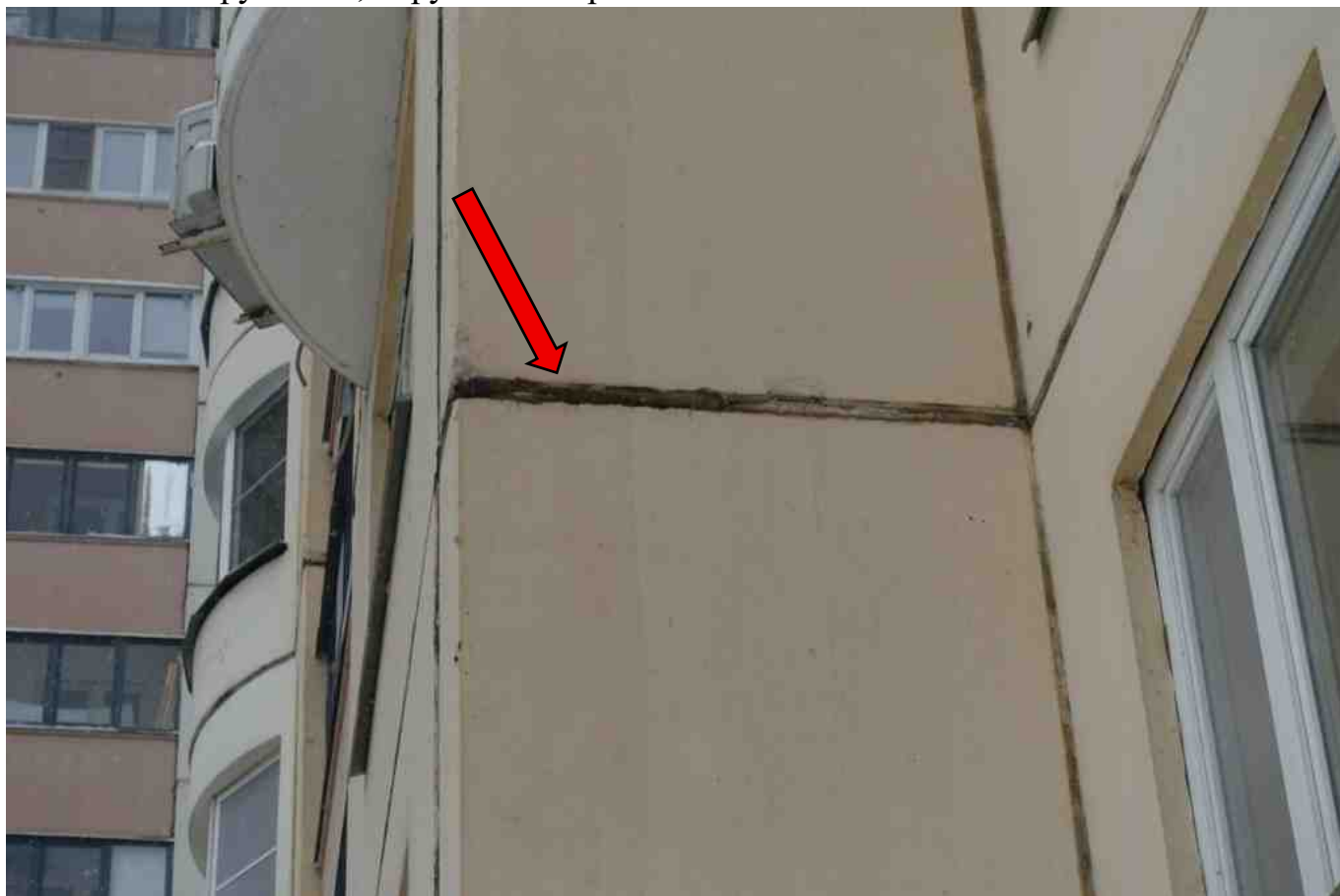
Фото 119. Разрушение, нарушение герметичности шва.
