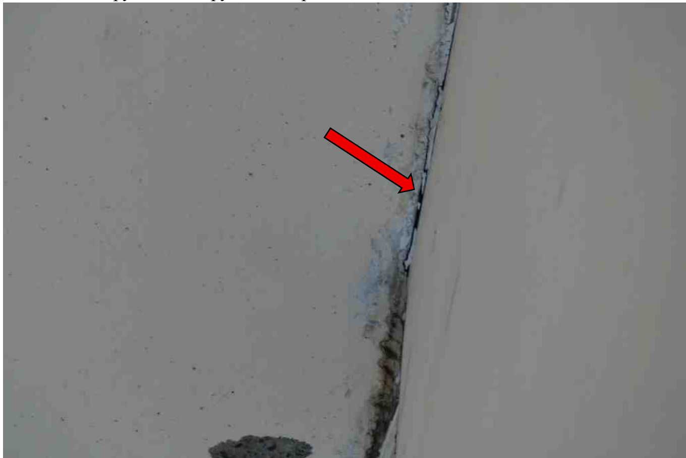
Фото 307. Разрушение, нарушение герметичности шва.
