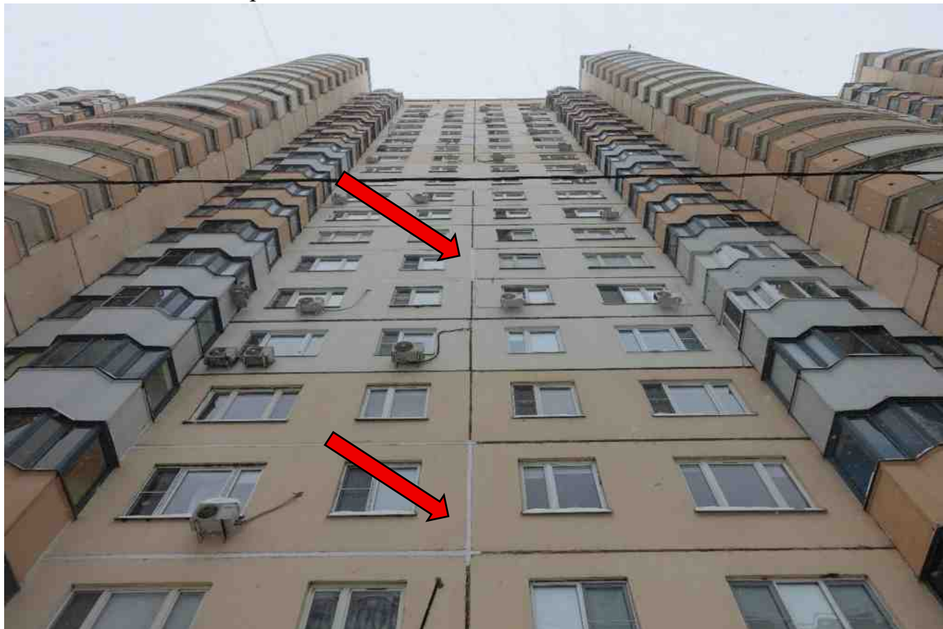
Фото 217. Разрушение, нарушение герметичности шва.
