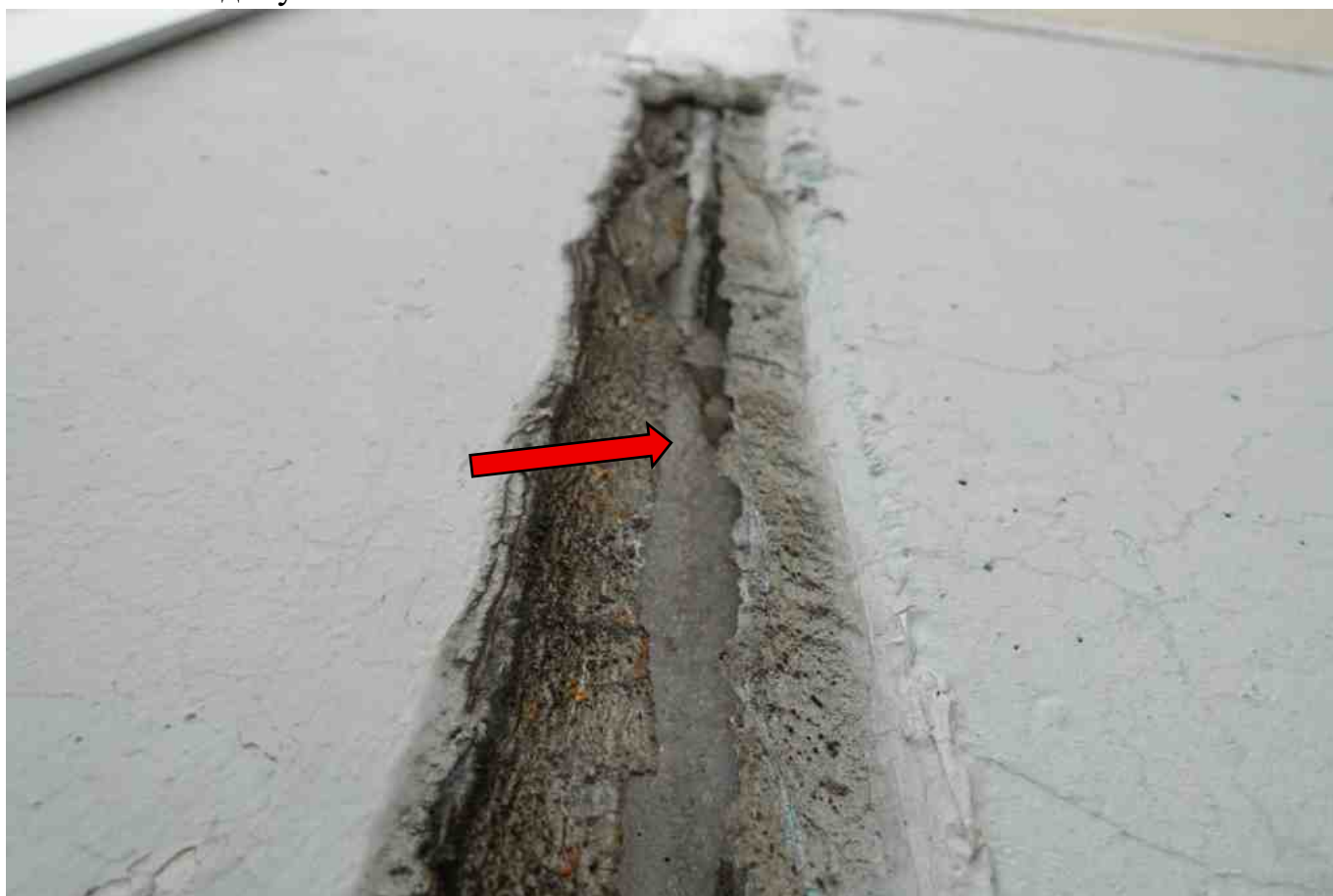
Фото 152. Не допустимое состояние шва.
