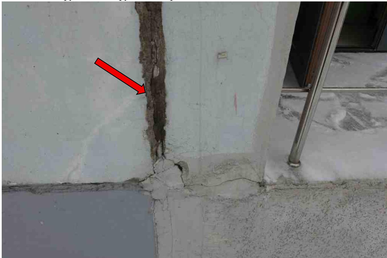
Фото 227. Разрушение, нарушение герметичности шва.
