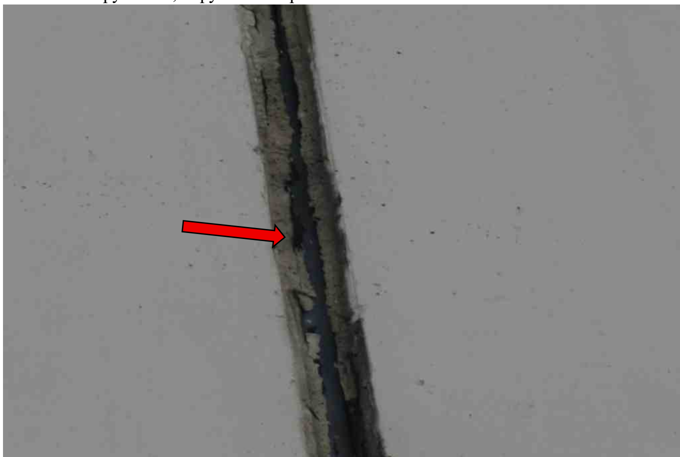
Фото 92. Разрушение, нарушение герметичности шва.
