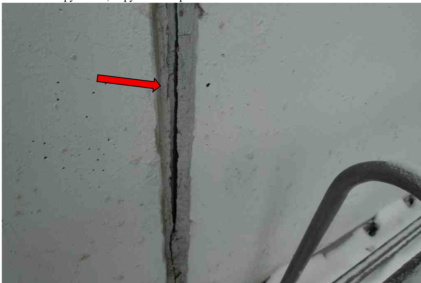
Фото 70. Разрушение, нарушение герметичности шва.
