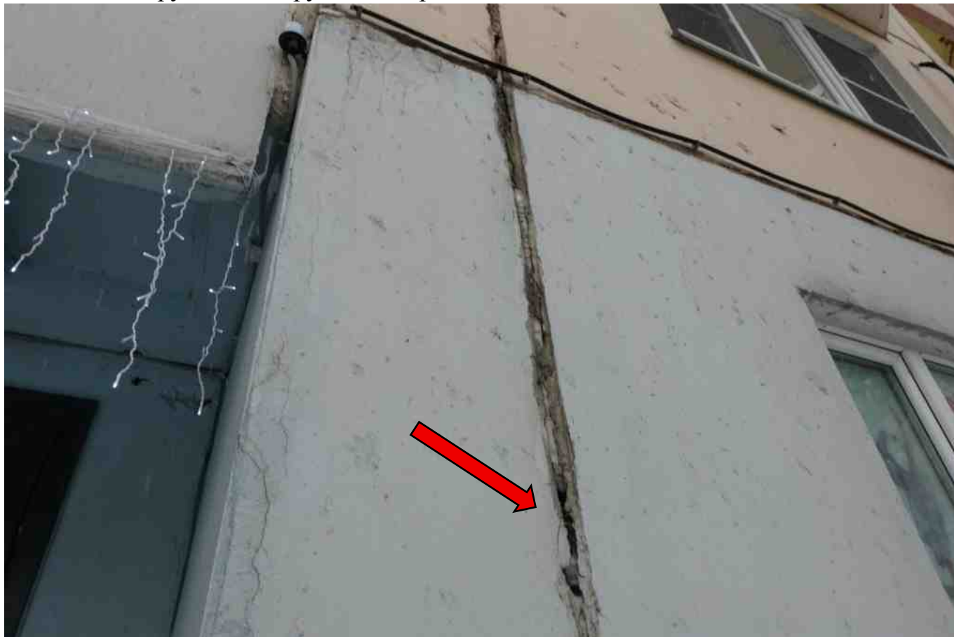
Фото 106. Разрушение вилатерма, герметика., нарушение герметичности шва.
