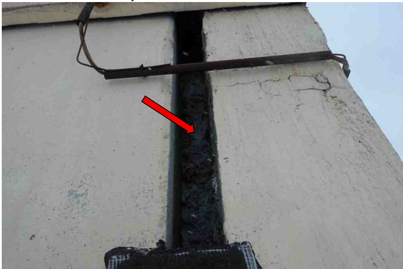
Фото 301. Разрушение монтажного межпанельного шва.
