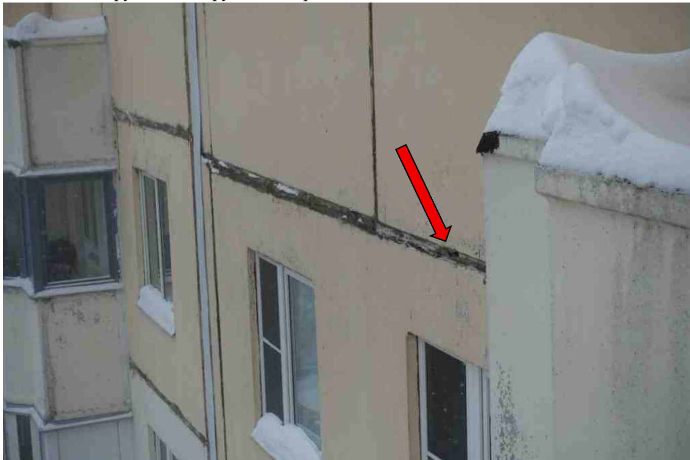
Фото 279. Разрушение, нарушение герметичности шва.
