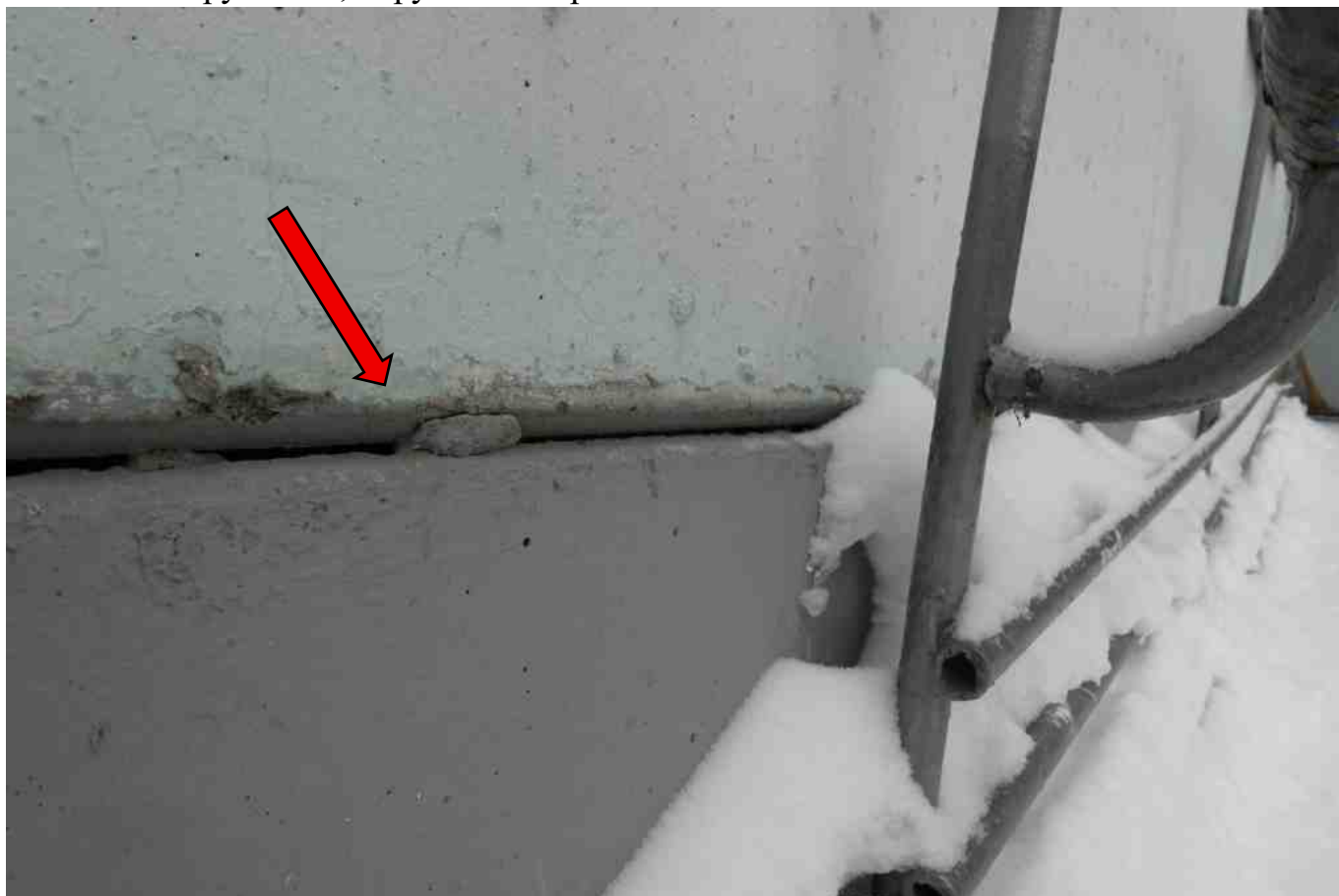
Фото 70. Разрушение, нарушение герметичности шва.
