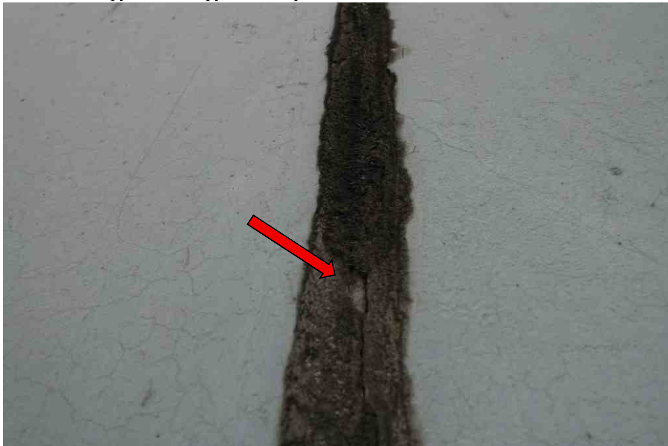
Фото 229. Разрушение, нарушение герметичности шва.
