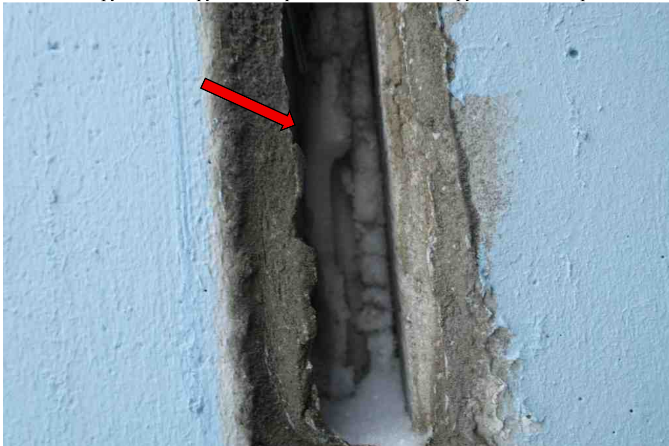
Фото 44. Заполнение шва из вилатерма находится в недопустимом состоянии.
