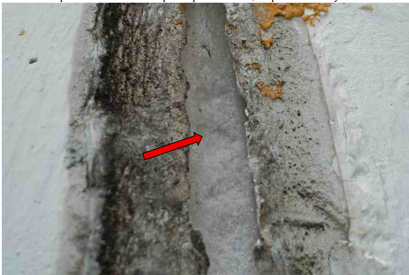
Фото 154. При нажатии на вилатерм он рассыпается, не работает как утеплитель.
