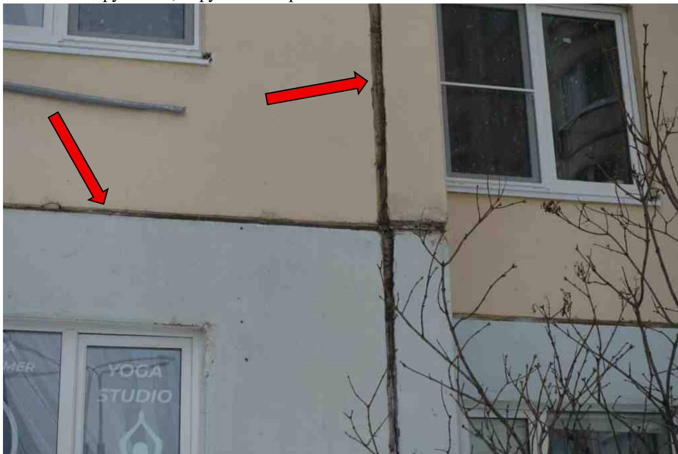
Фото 84. Разрушение, нарушение герметичности шва. Обнаженный вилатерм.
