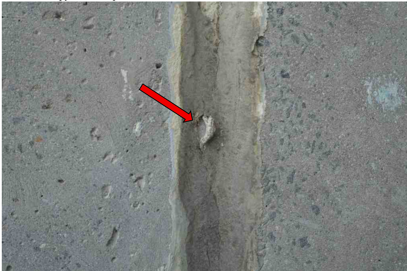
Фото 28. Разрушение горизонтального шва, заполнение на цементной основе.
