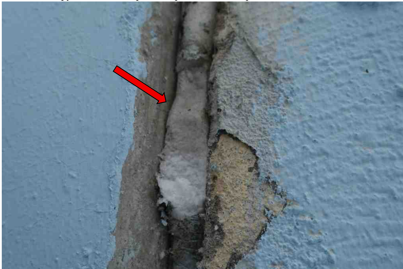
Фото 50. Разрушение, нарушение герметичности шва.
