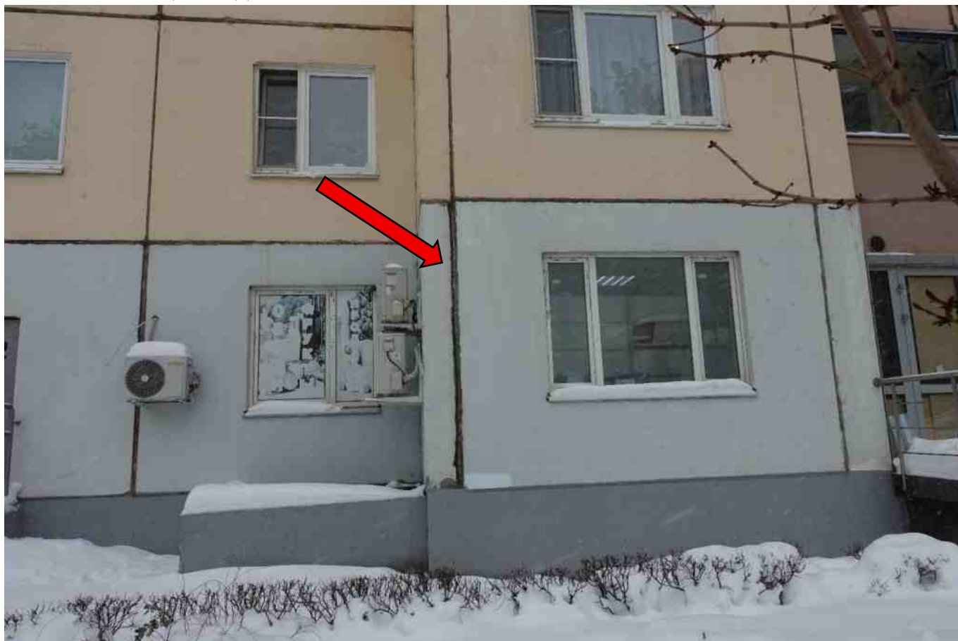
Фото 191. Разрушение, нарушение герметичности шва.
