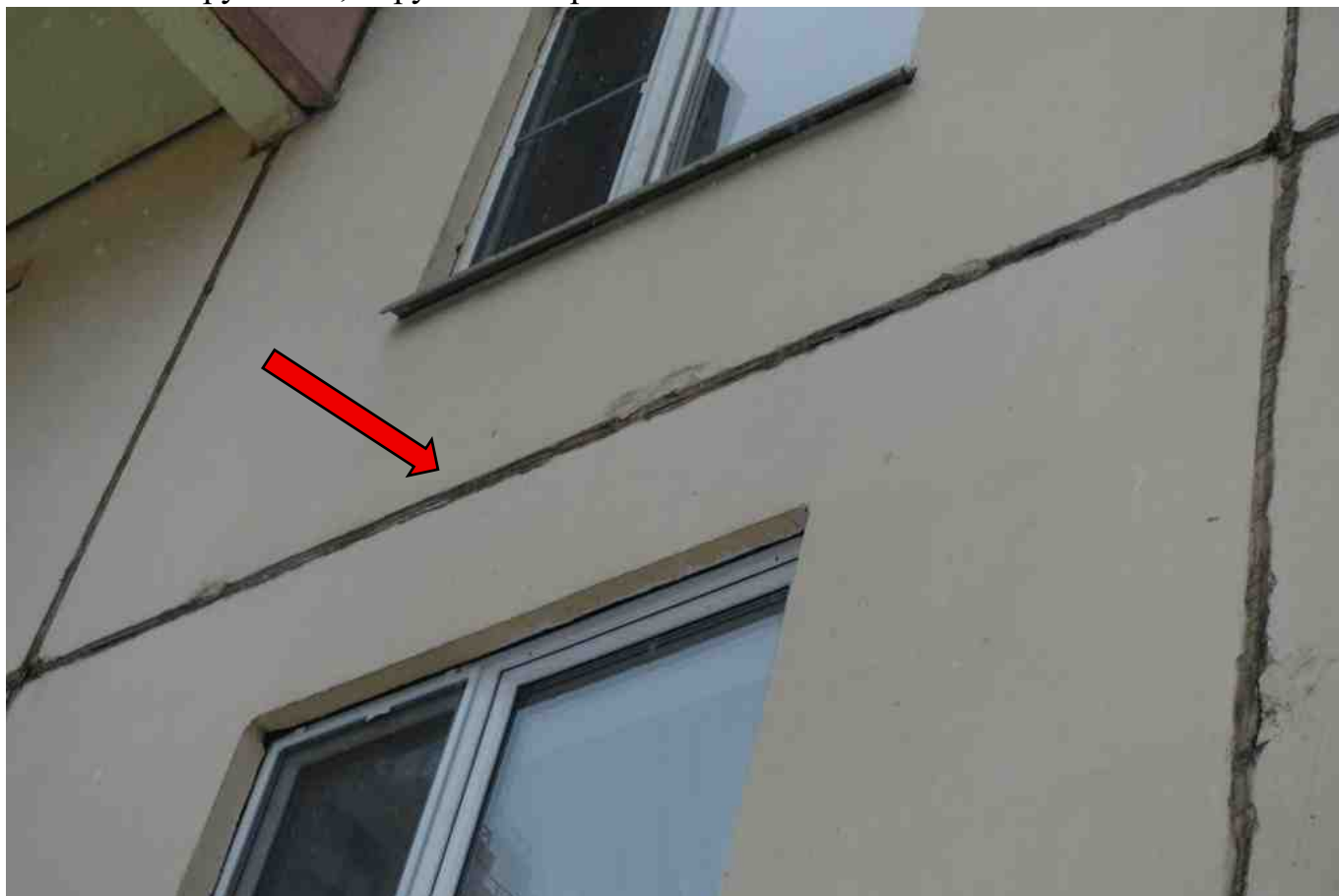
Фото 96. Локальный ремонт межпанельных швов.
