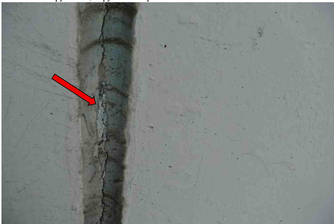
Фото 144. Разрушение, нарушение герметичности шва.
