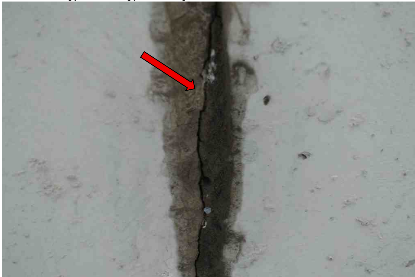
Фото 102. Разрушение вилатерма, герметика, нарушение герметичности шва.
