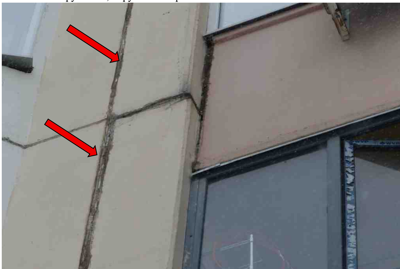
Фото 110. Разрушение, нарушение герметичности шва.
