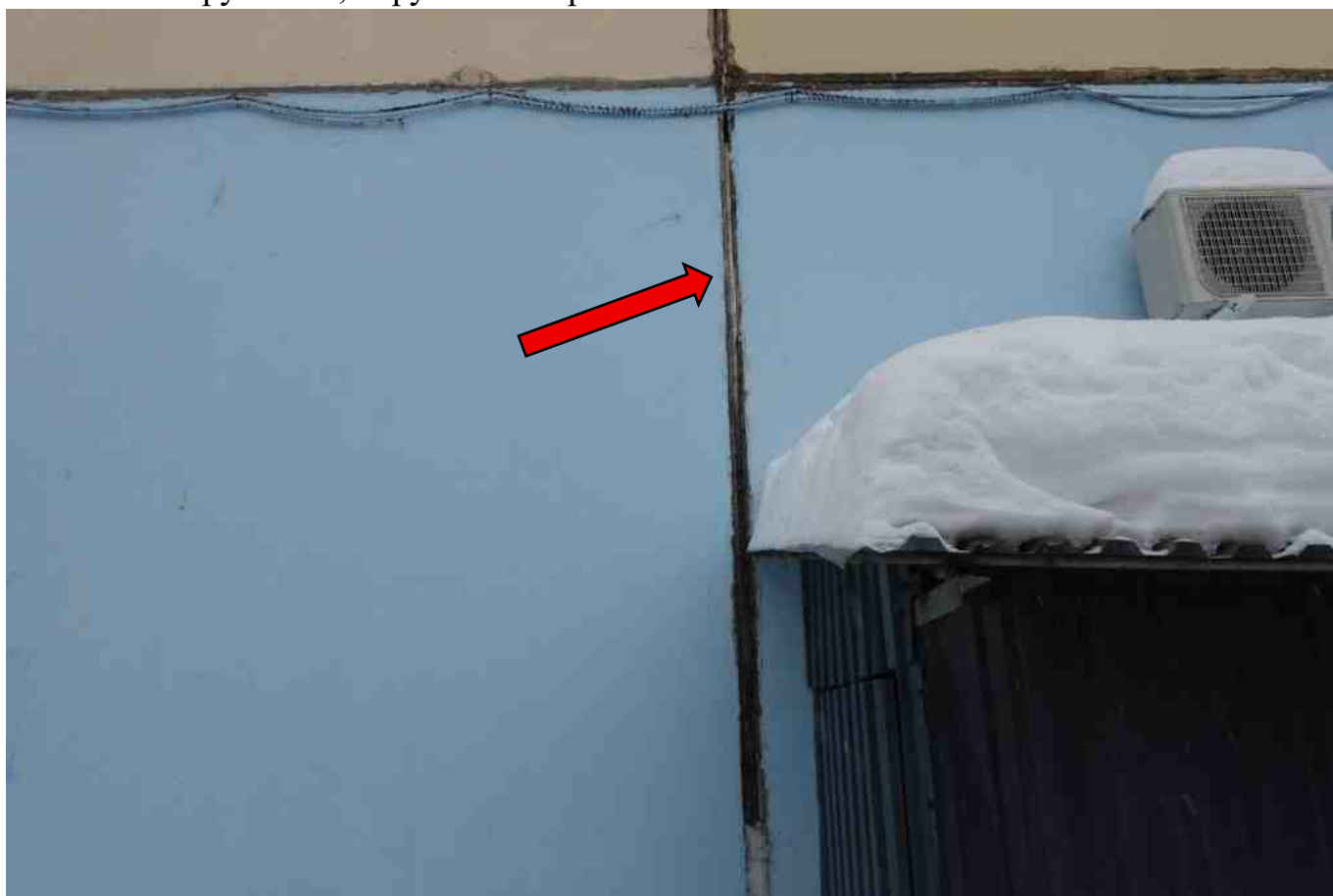
Фото 42. Разрушение, нарушение герметичности шва.
