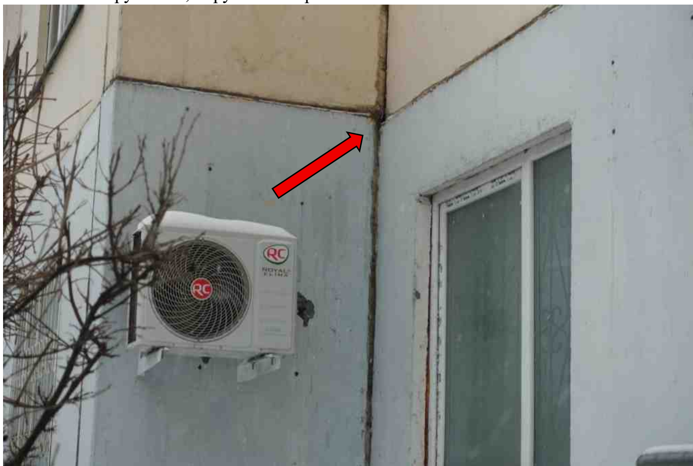
Фото 185. Разрушение, нарушение герметичности шва.
