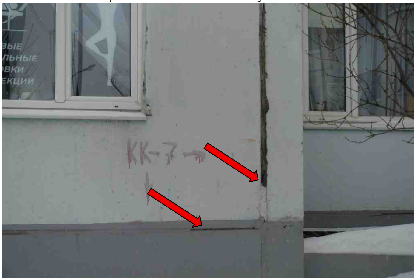
Фото 82. Место осмотра. Разное заполнение швов. Пустой шов.
