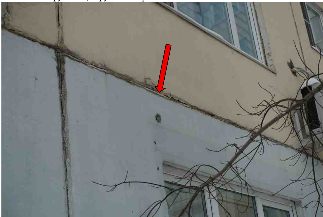
Фото 160. Разрушение, нарушение герметичности шва.
