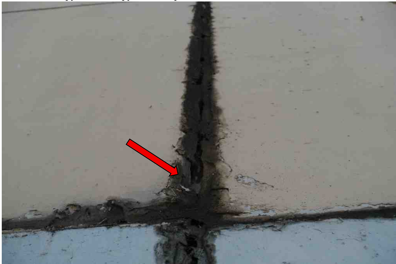
Фото 267. Разрушение, нарушение герметичности шва.
