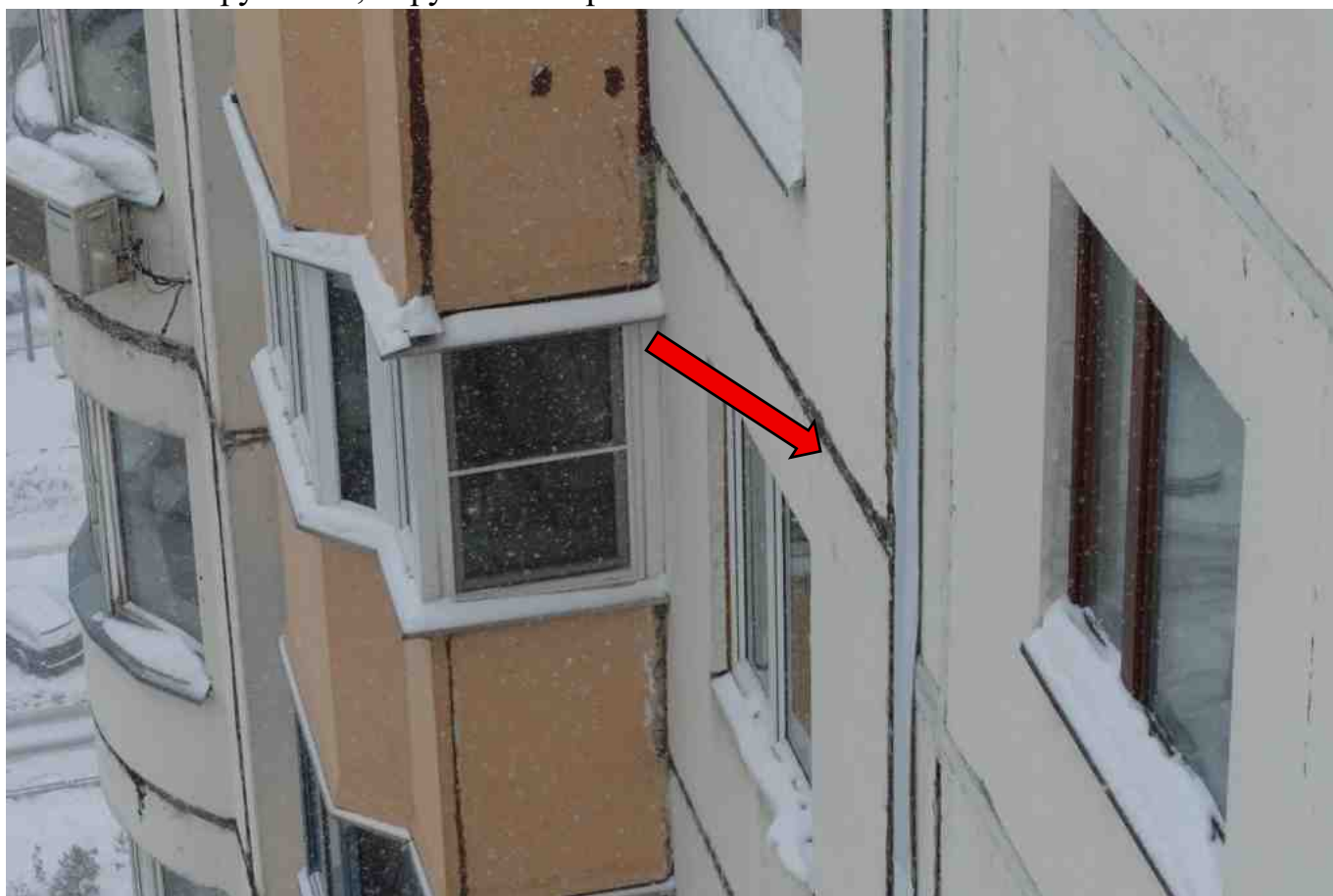
Фото 307. Разрушение, нарушение герметичности шва.
