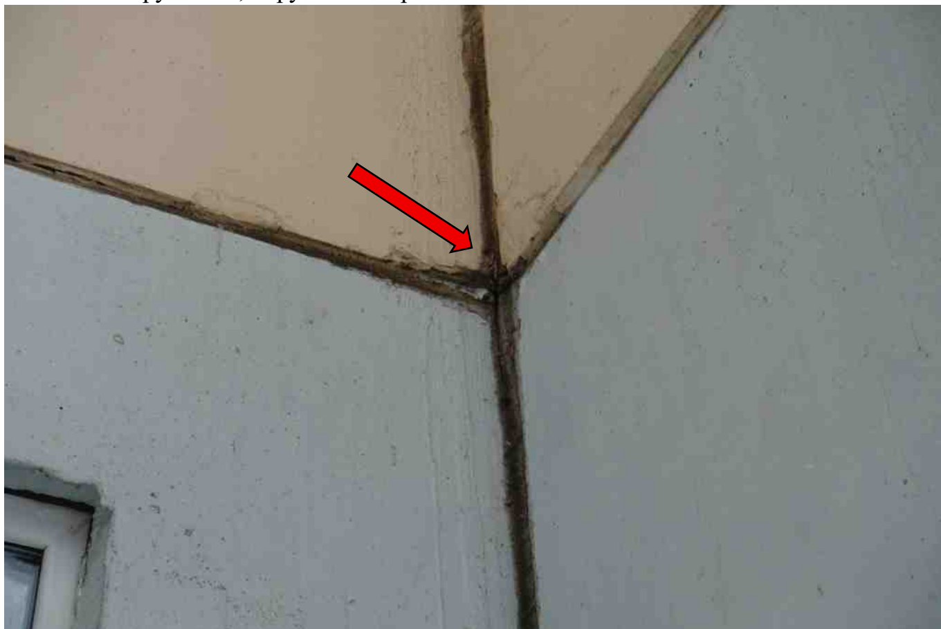
Фото 88. Разрушение вилатерма, герметика, нарушение герметичности шва.
