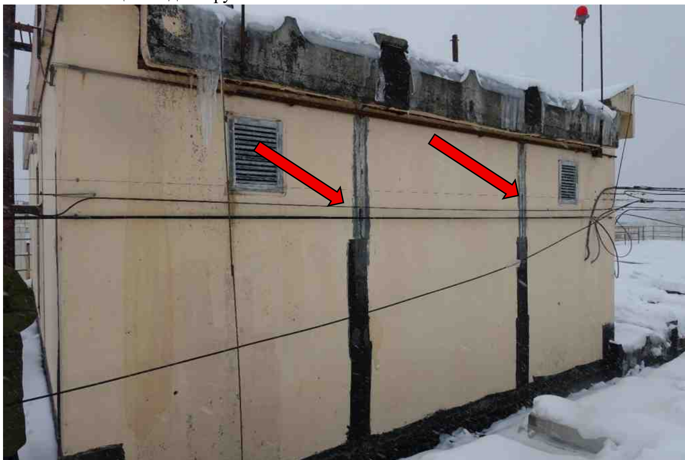
Фото 281. Общий вид. Разрушение швов.
