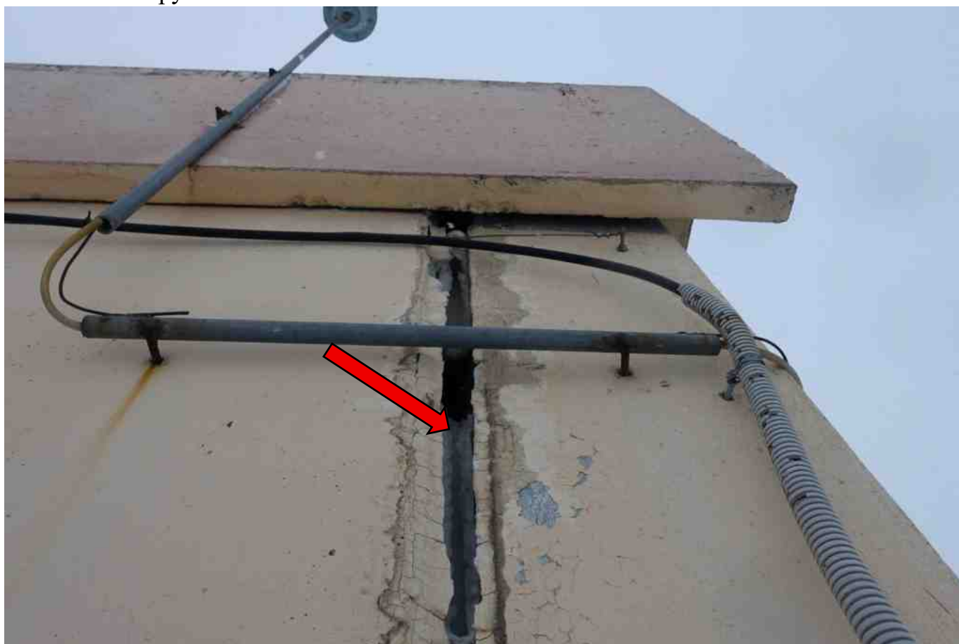
Фото 293. Разрушение монтажного межпанельного шва.
