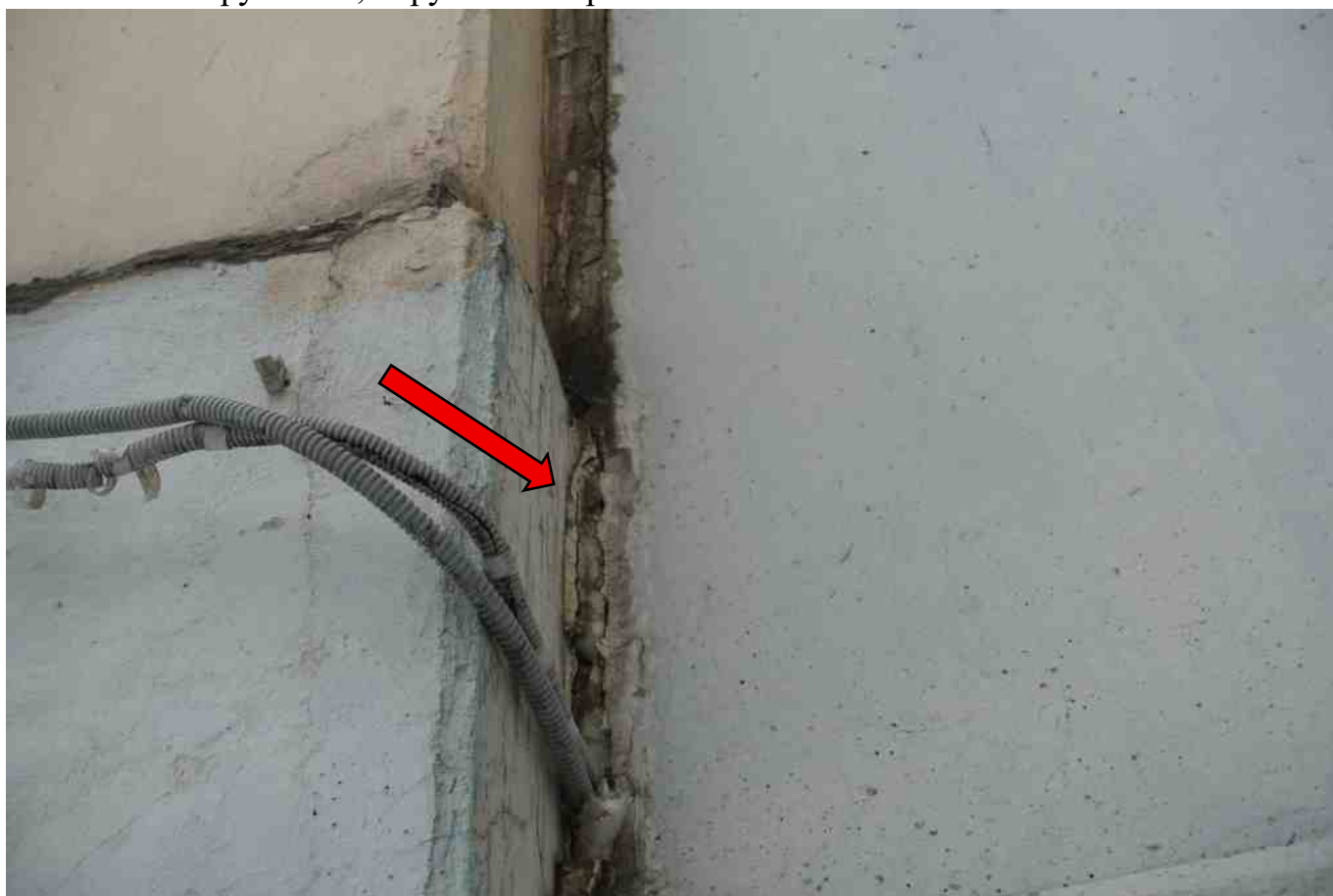
Фото 162. Разрушение, нарушение герметичности шва.
