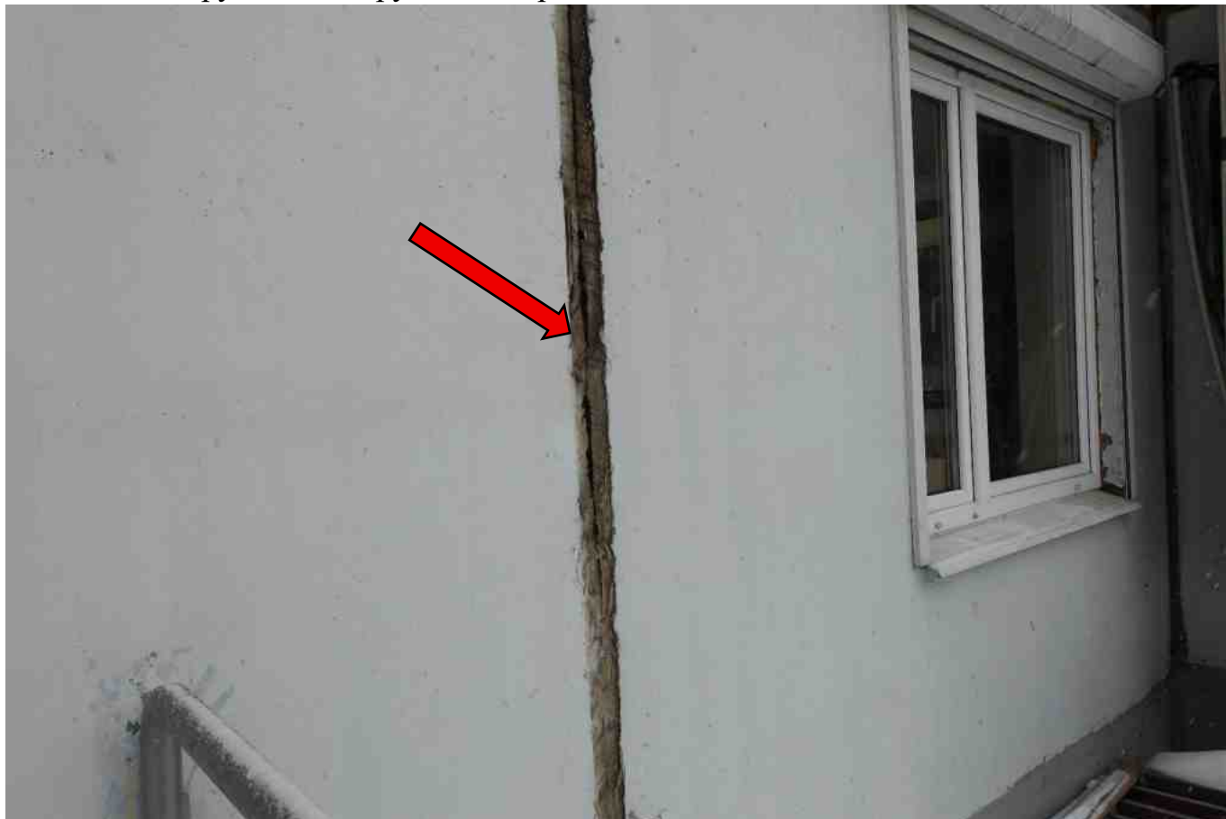
Фото 114. Разрушение, нарушение герметичности шва.
