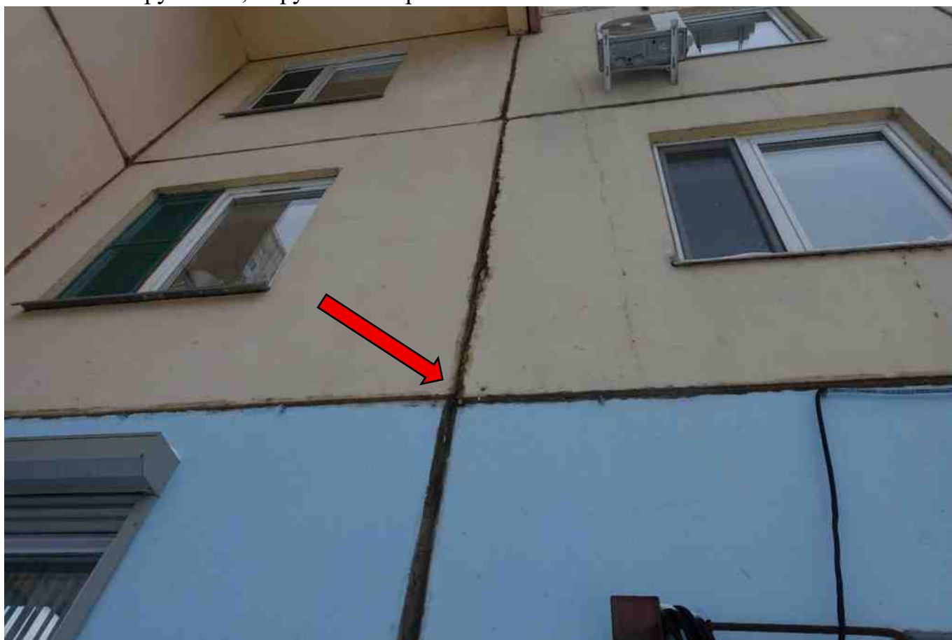
Фото 50. Разрушение, нарушение герметичности шва.
