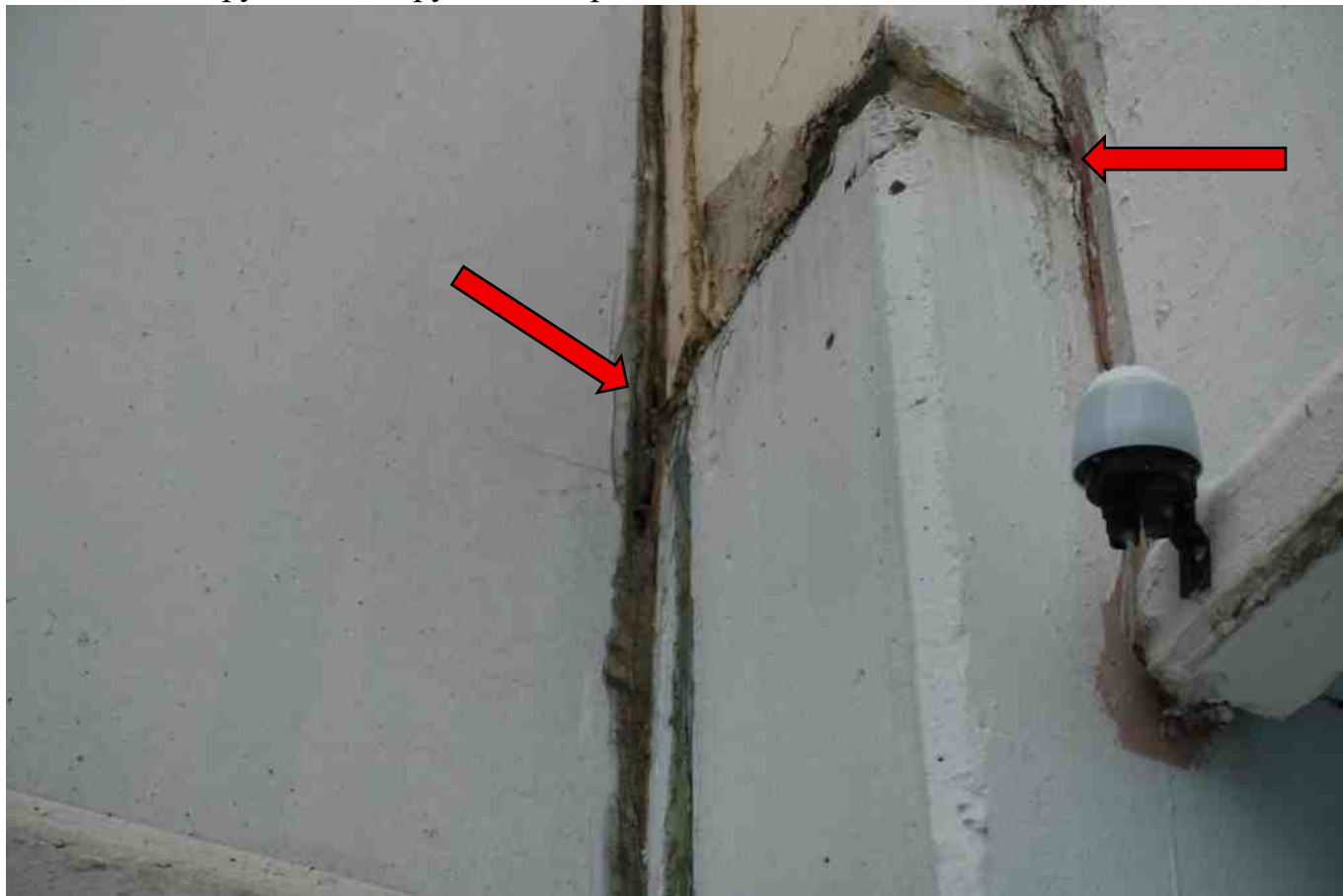
Фото 146. Разрушение, нарушение герметичности шва.
