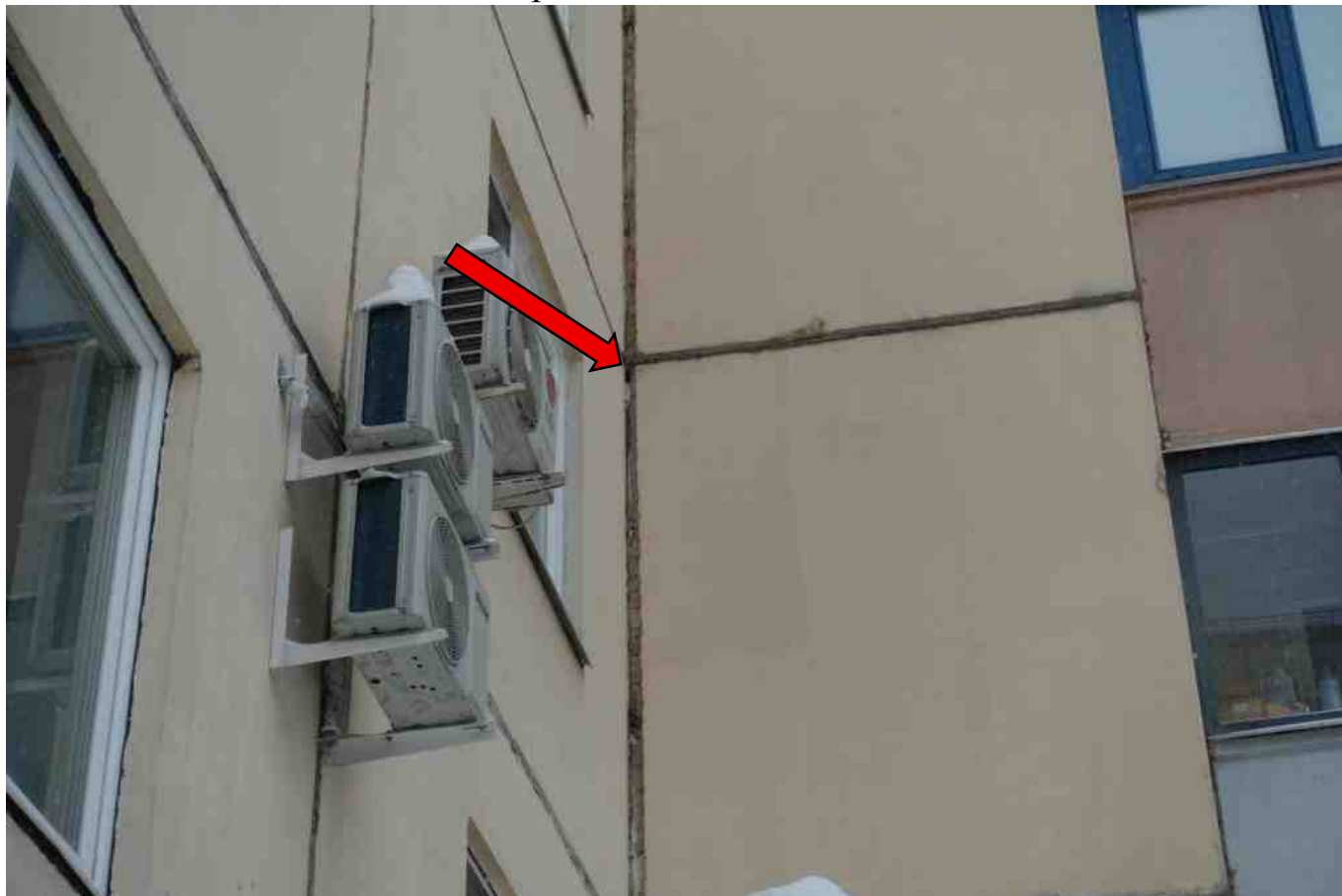
Фото 80. Разрушение герметика, вилатерма, нарушение герметичности шва.
