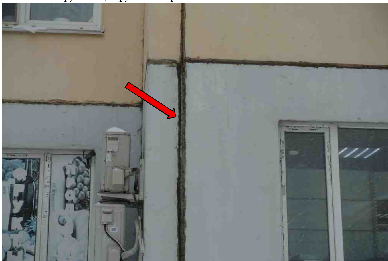
Фото 191. Разрушение, нарушение герметичности шва.
