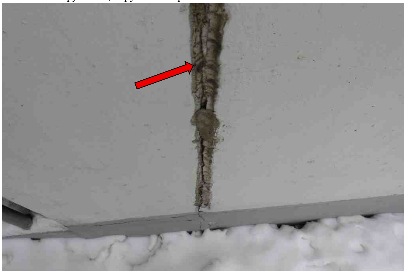
Фото 134. Разрушение, нарушение герметичности шва.
