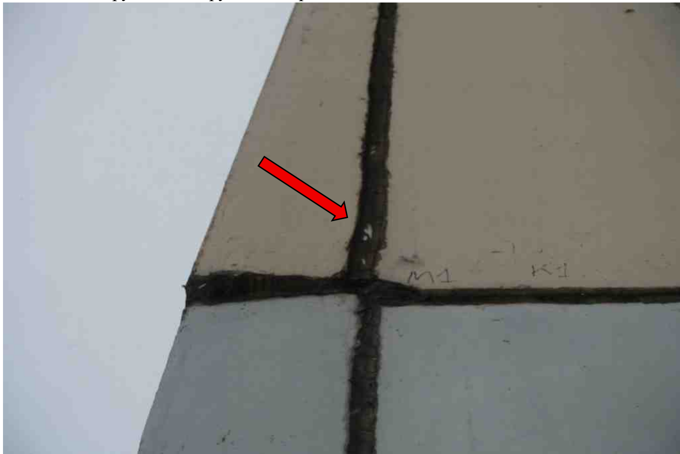
Фото 193. Разрушение, нарушение герметичности шва.
