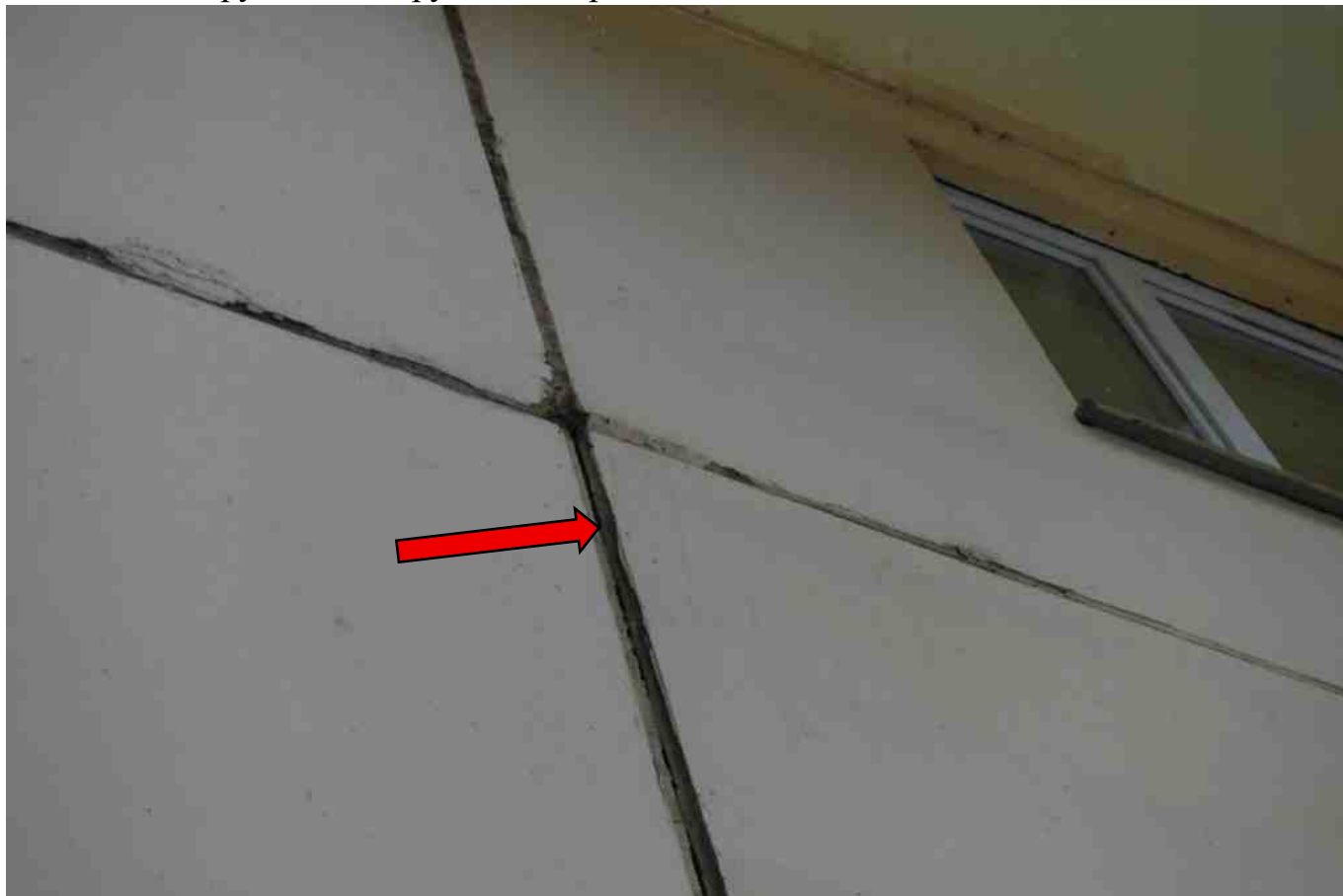
Фото 117. Разрушение, нарушение герметичности шва.
