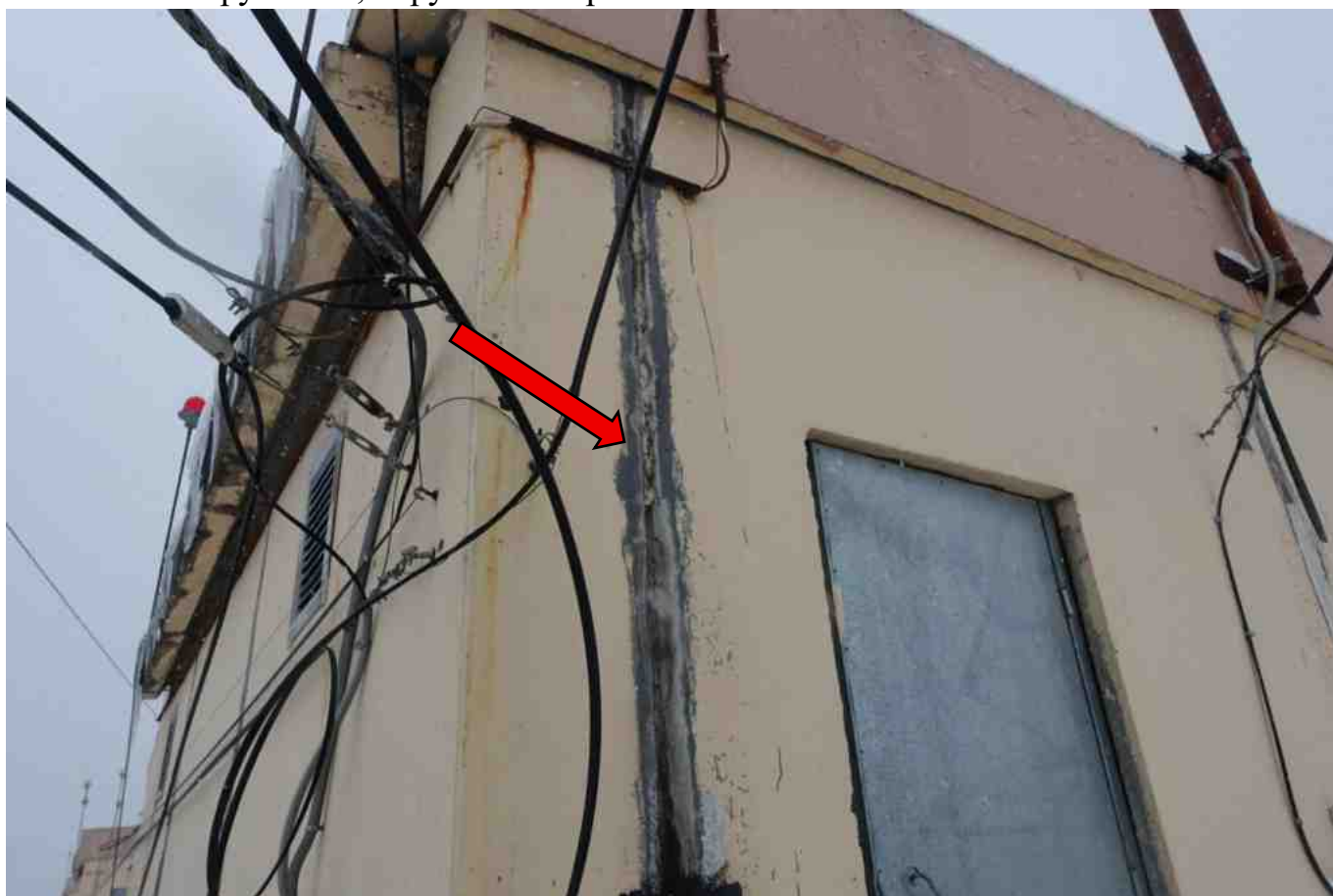
Фото 283. Разрушение, нарушение герметичности шва.
