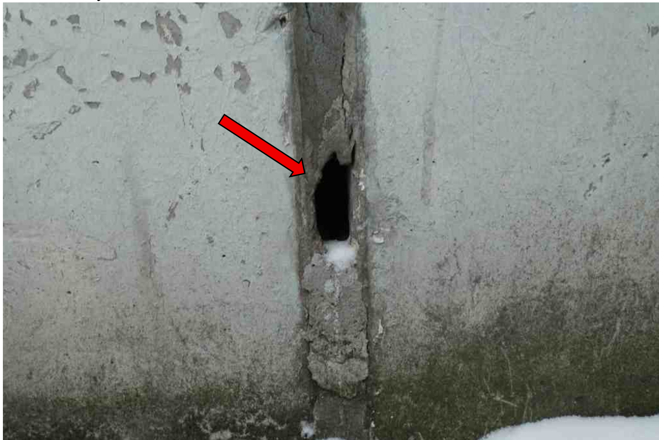
Фото 237. Разрушение, нарушение герметичности шва.
