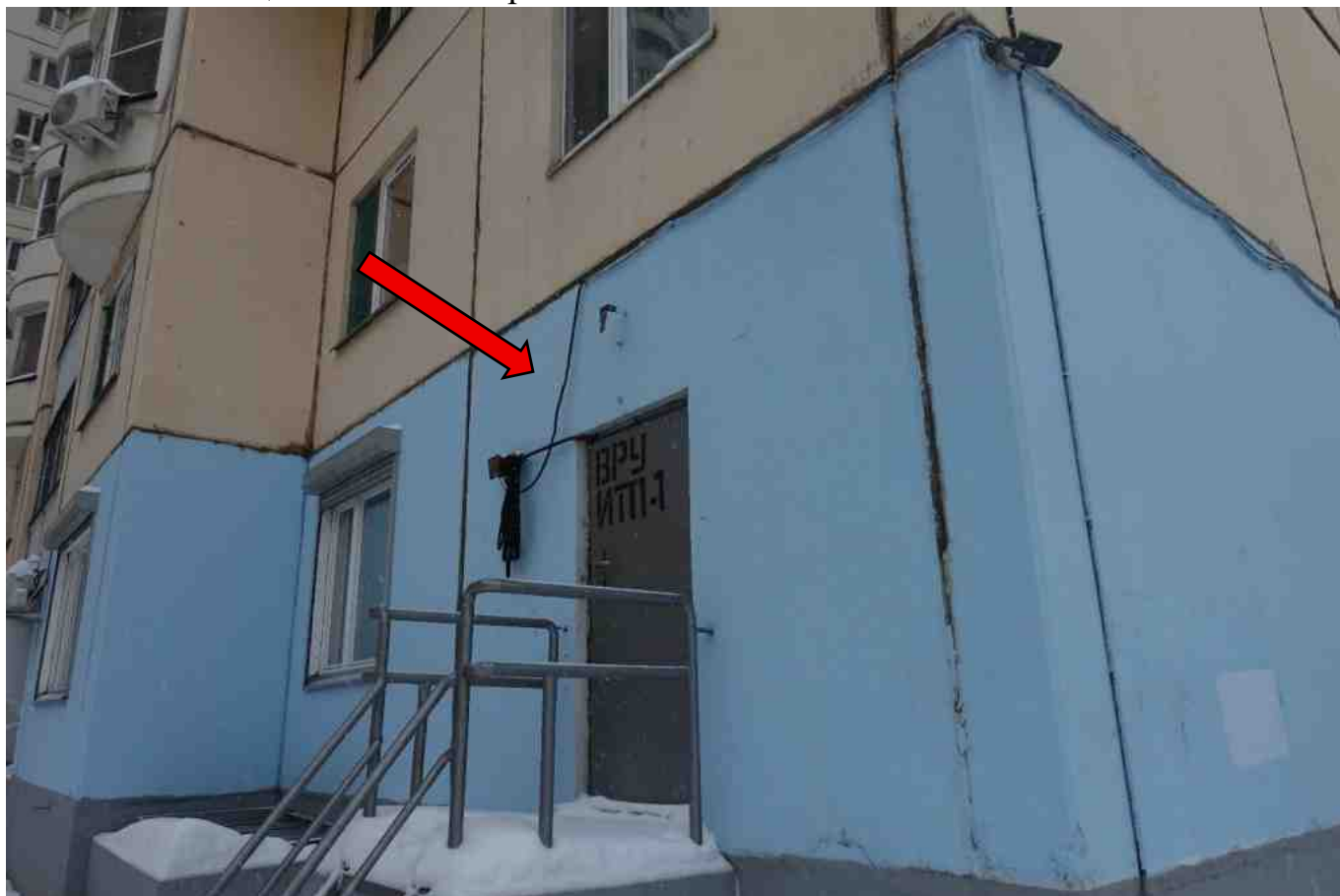
Фото 46. Разрушение, нарушение герметичности шва.
