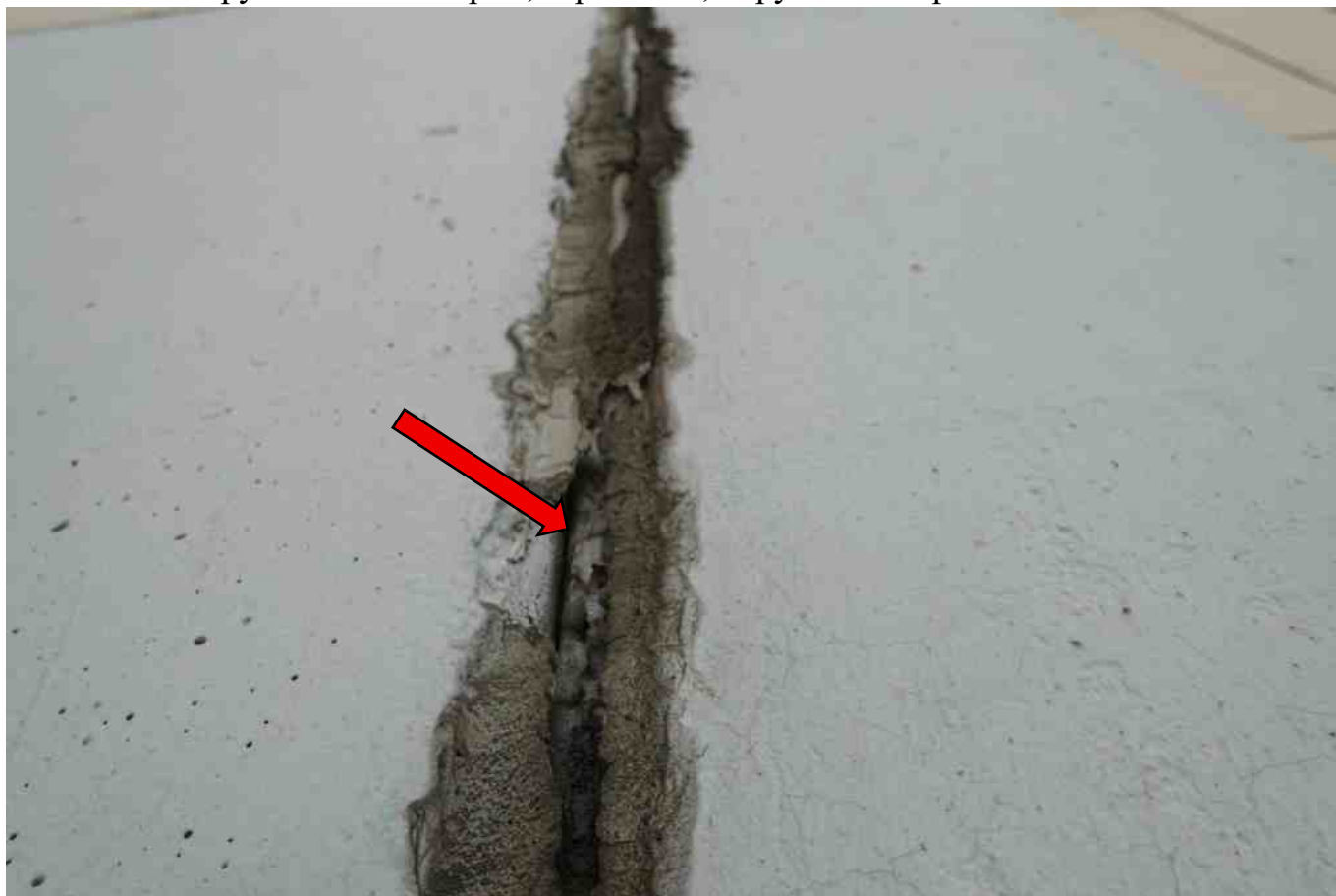
Фото 132. Разрушение вилатерма, герметика, нарушение герметичности шва.
