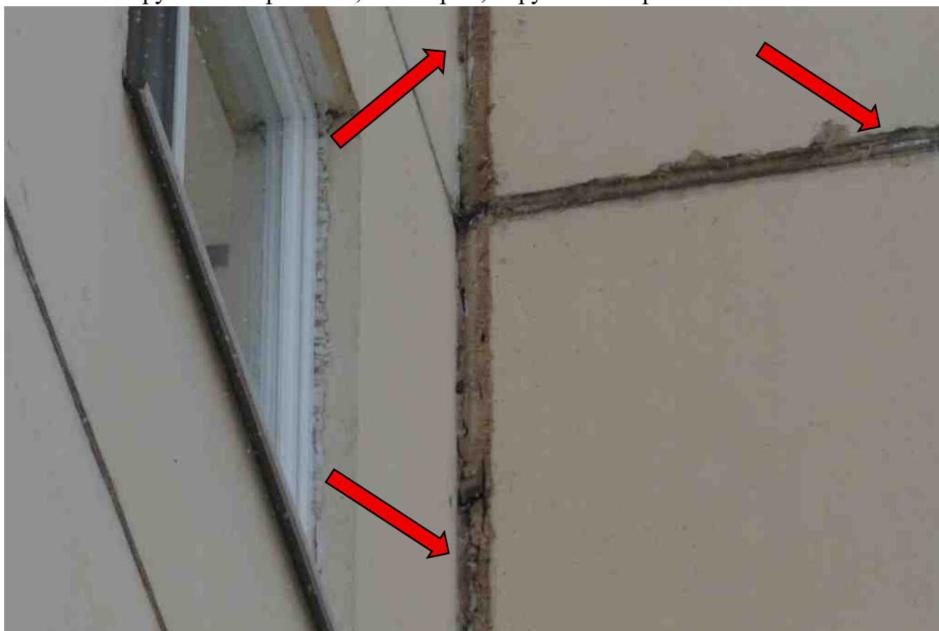
Фото 80. Разрушение герметика, вилатерма, нарушение герметичности шва.
