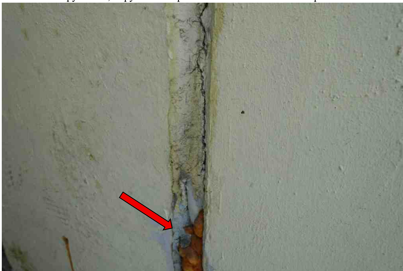
Фото 253. Разрушение, нарушение герметичности шва. Пена выгорела.
