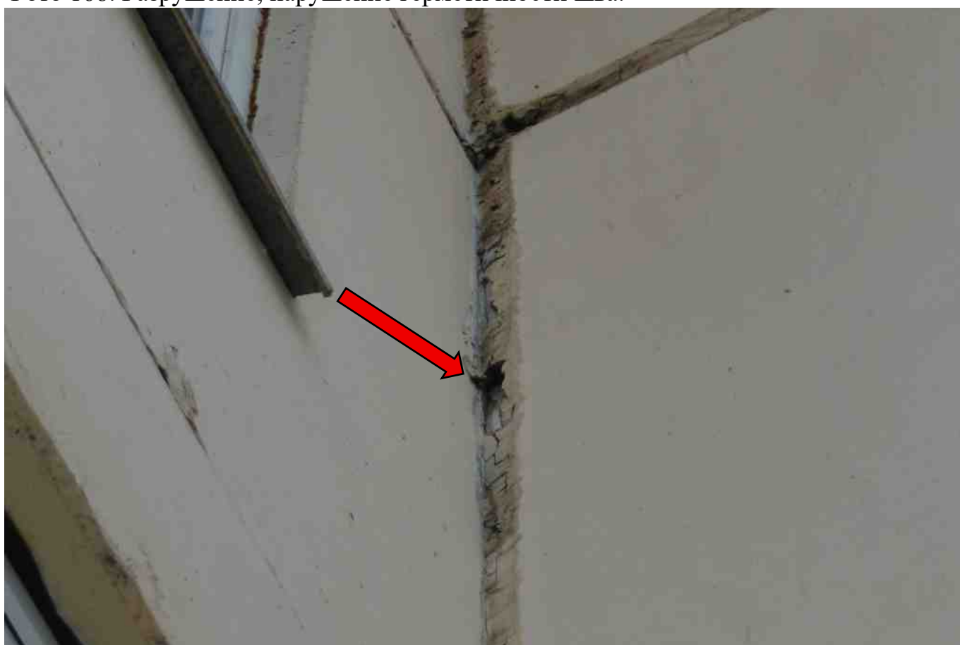
Фото 168. Разрушение, нарушение герметичности шва.
