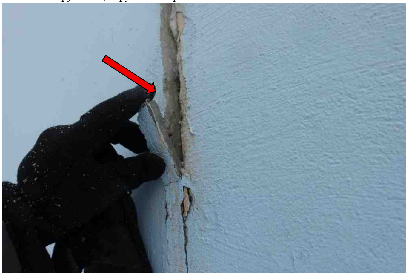
Фото 46. Разрушение, нарушение герметичности шва.
