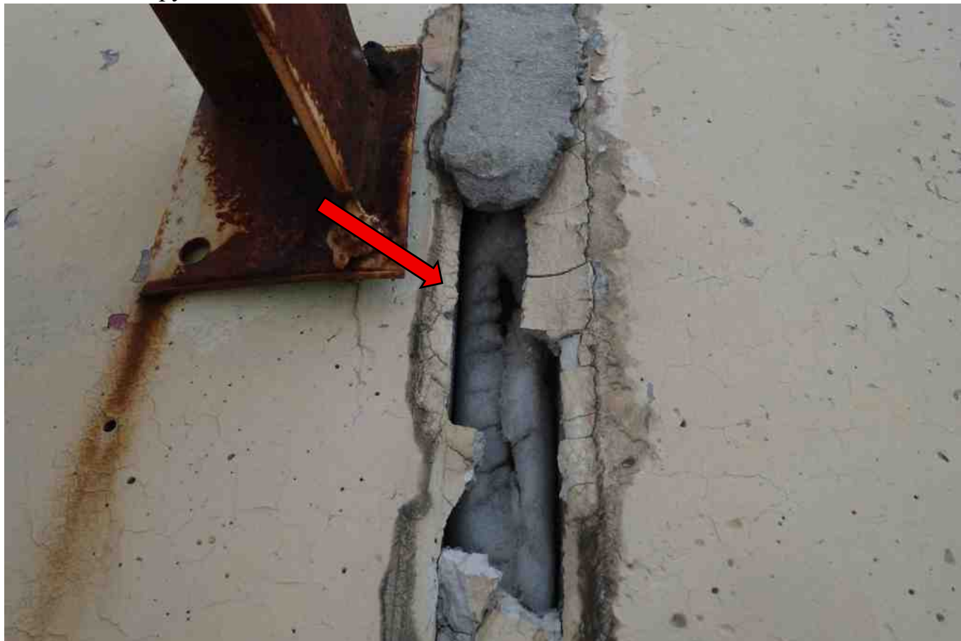
Фото 295. Разрушение монтажного межпанельного шва.
