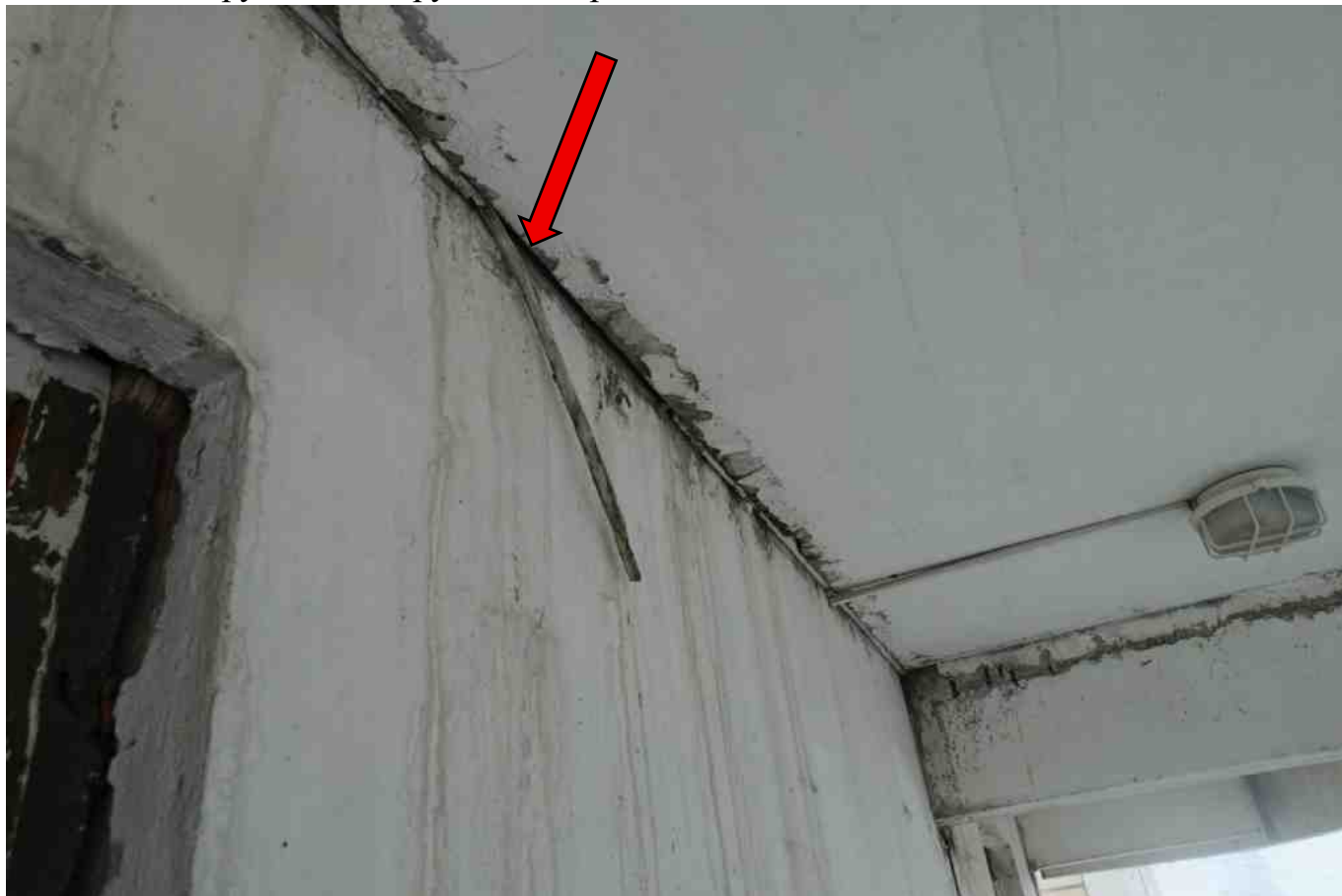
Фото 281. Общий вид. Разрушение швов.
