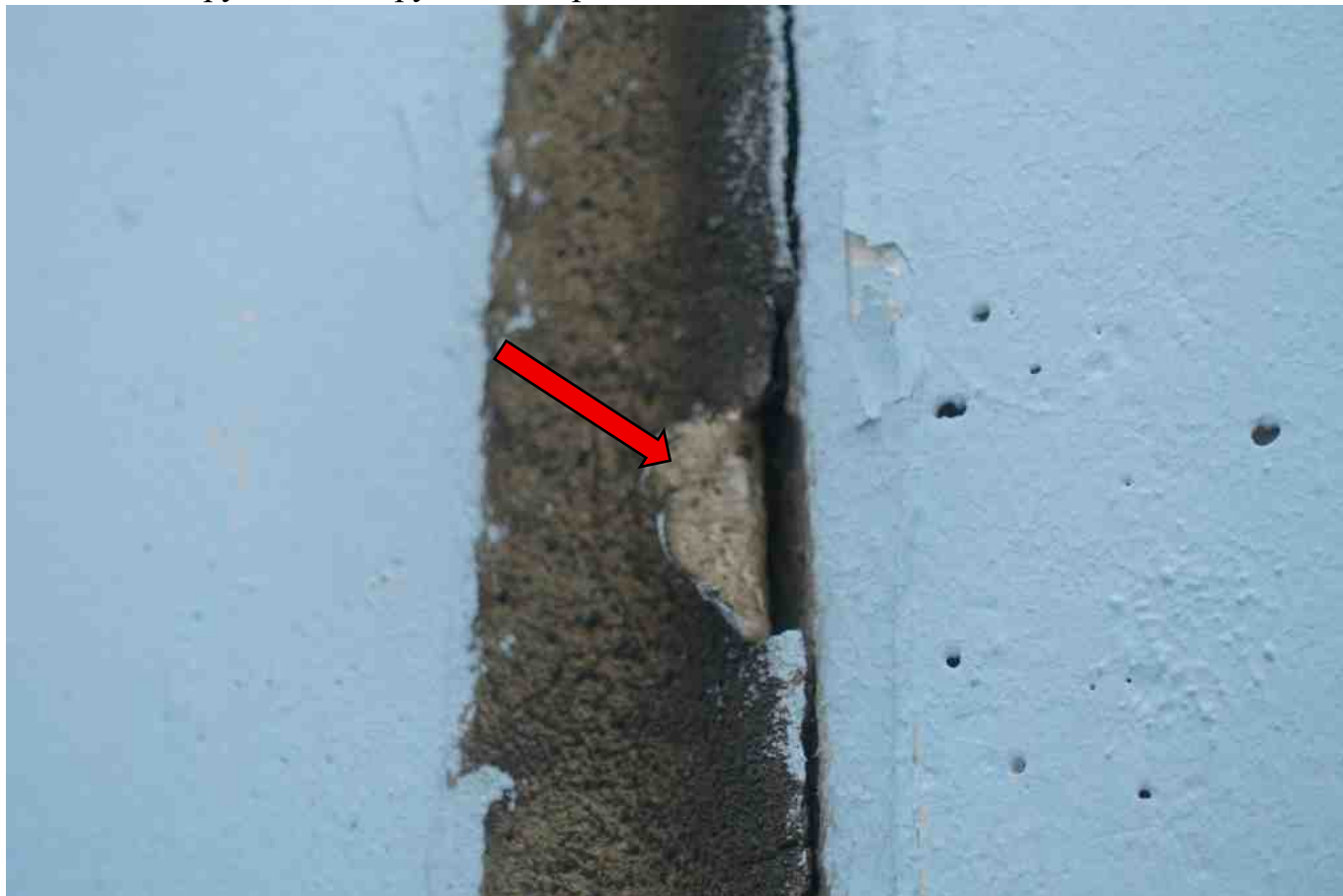
Фото 40. Разрушение, нарушение герметичности шва.
