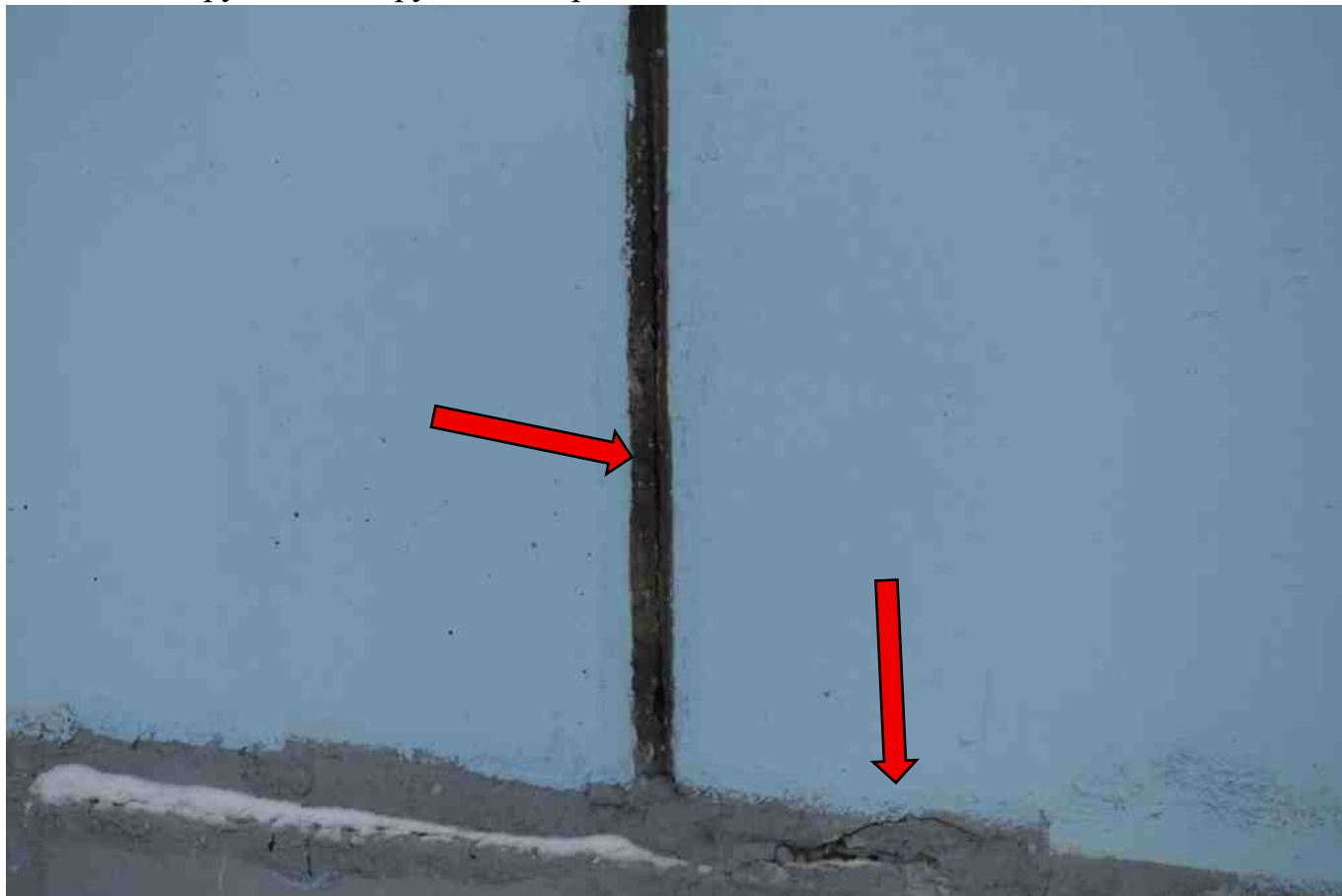
Фото 38. Разрушение, нарушение герметичности шва.
