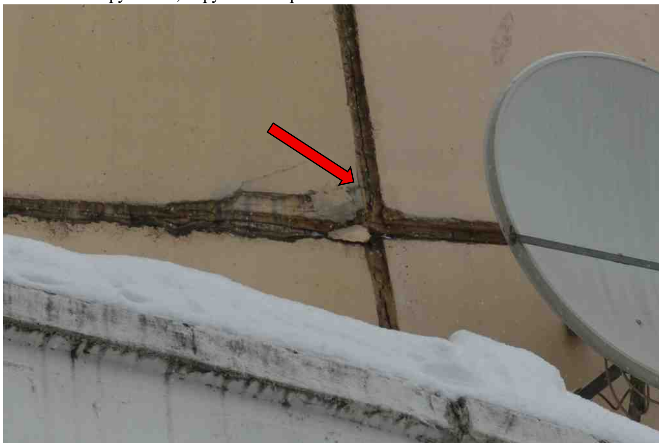
Фото 146. Разрушение, нарушение герметичности шва.
