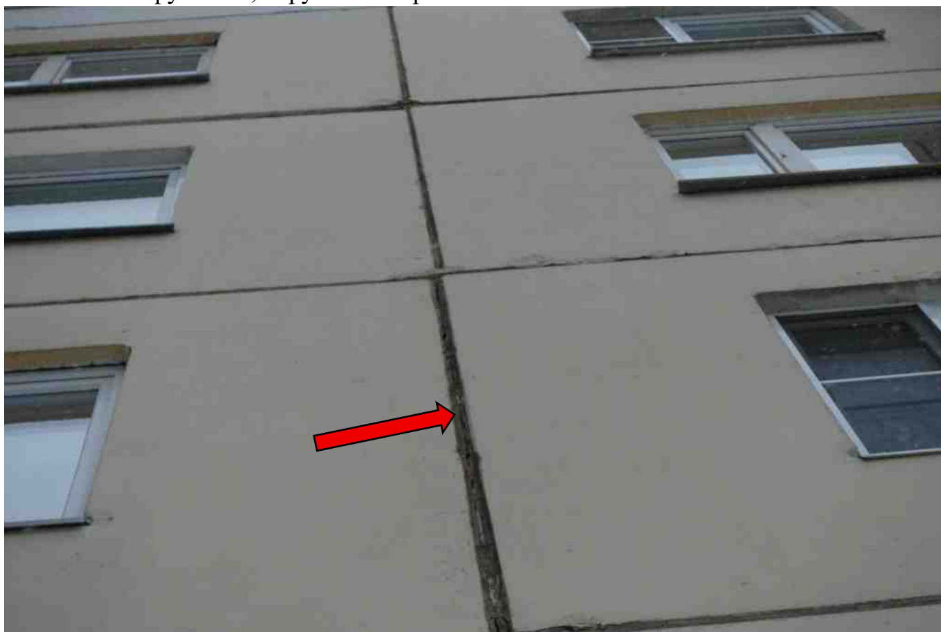
Фото 119. Разрушение, нарушение герметичности шва.
