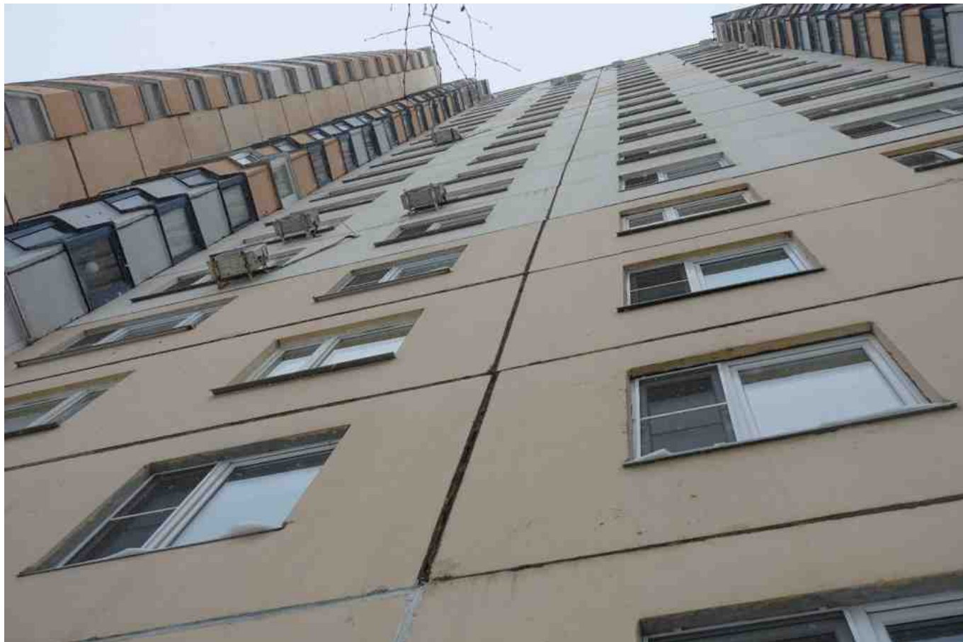
Фото 247. Разрушение, нарушение герметичности шва.
