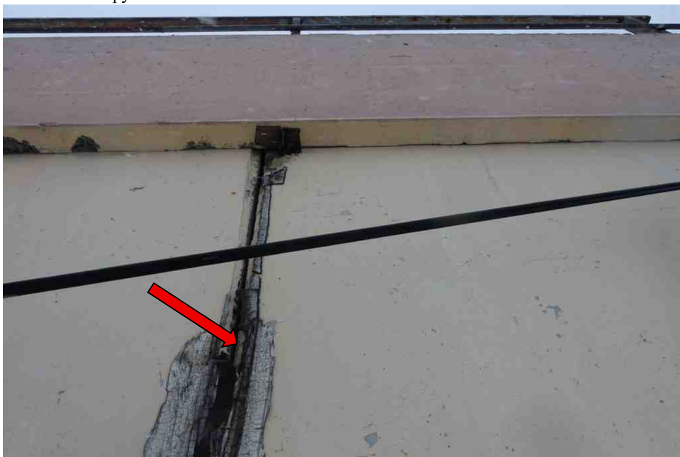
Фото 301. Разрушение монтажного межпанельного шва.
