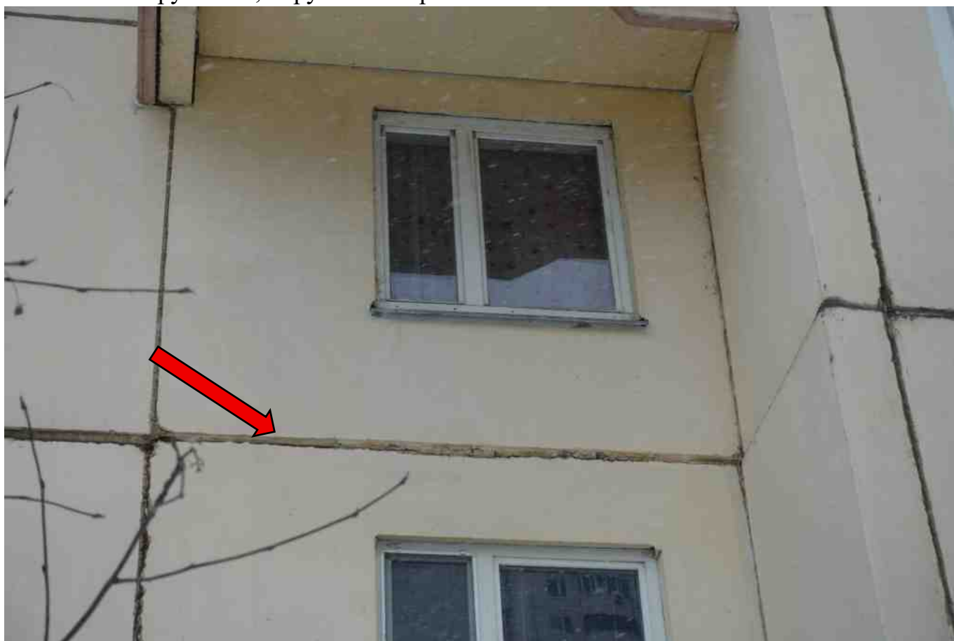
Фото 182. Разрушение, нарушение герметичности шва.
