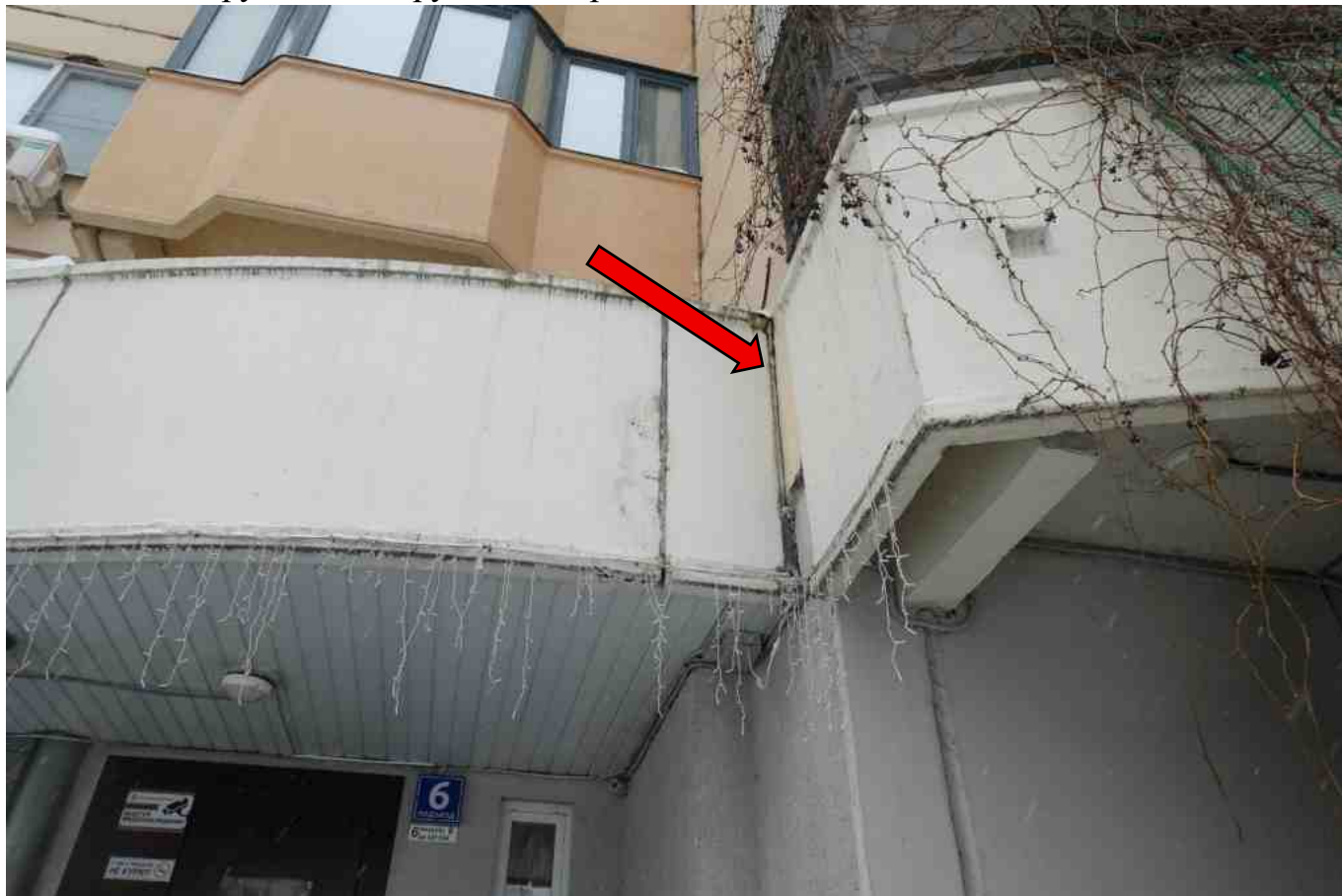
Фото 213. Разрушение, нарушение герметичности шва.
