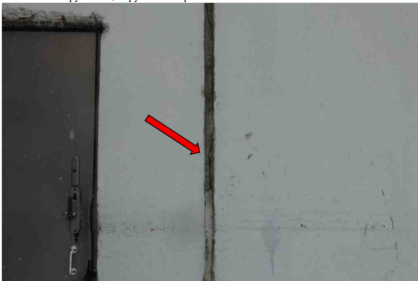
Фото 267. Разрушение, нарушение герметичности шва.
