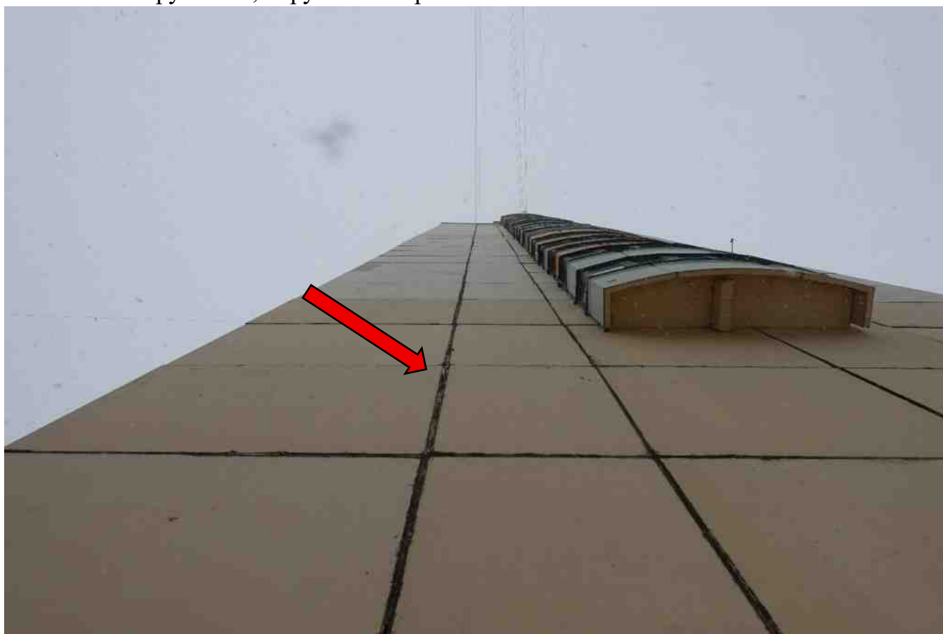
Фото 197. Разрушение, нарушение герметичности шва.
