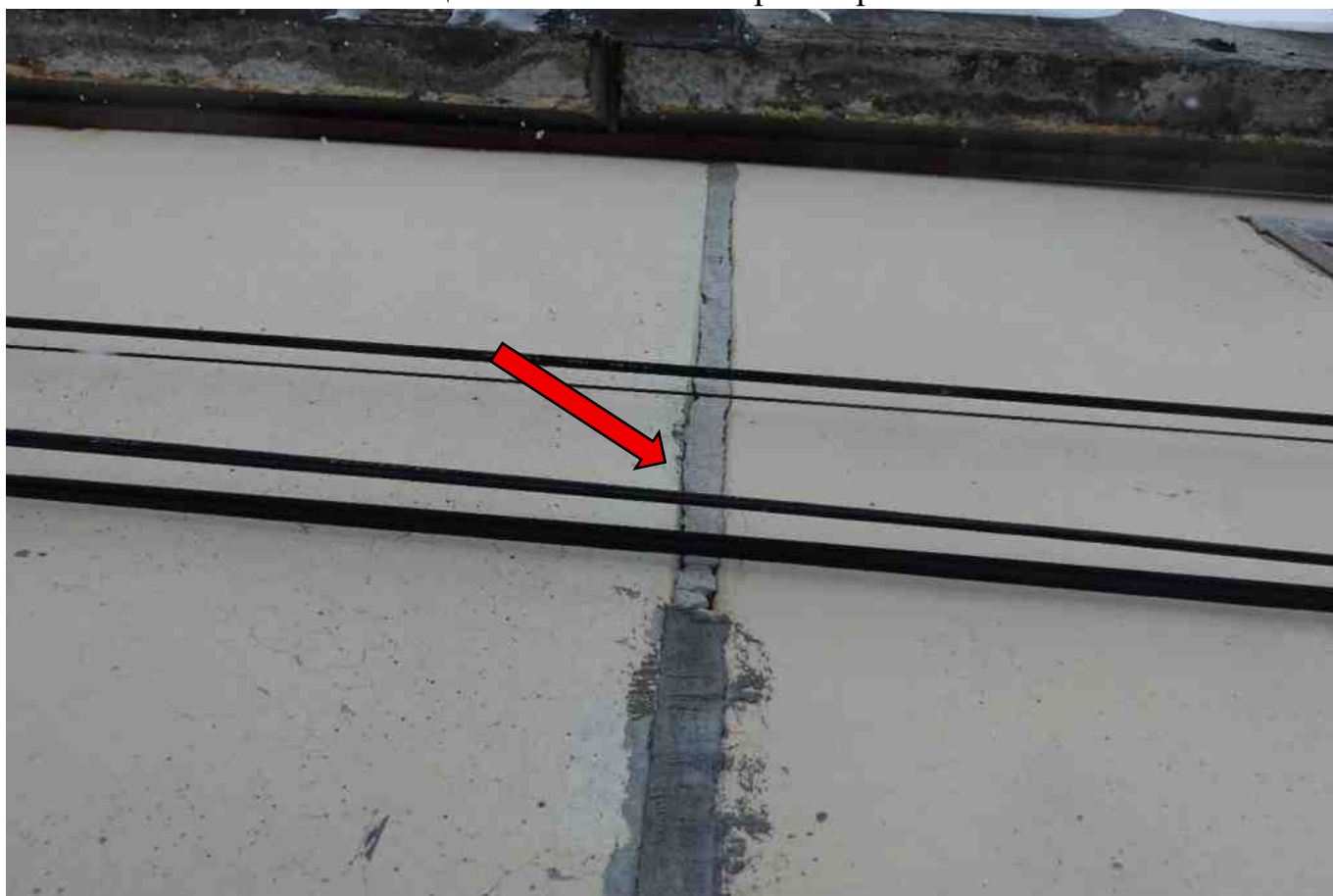
Фото 297. Заполнение шва цементно-песчаным раствором.
