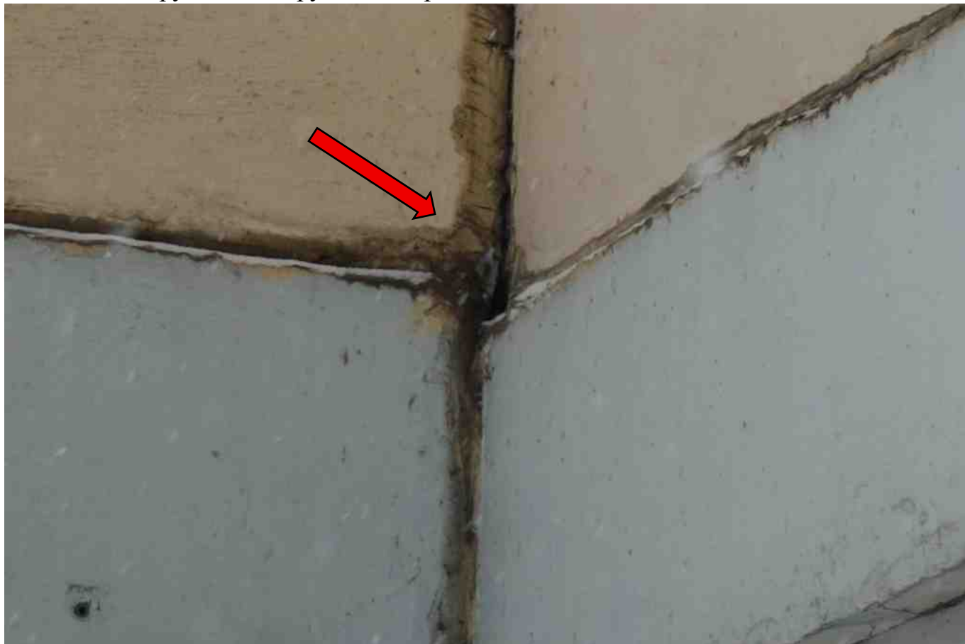
Фото 187. Разрушение, нарушение герметичности шва.
