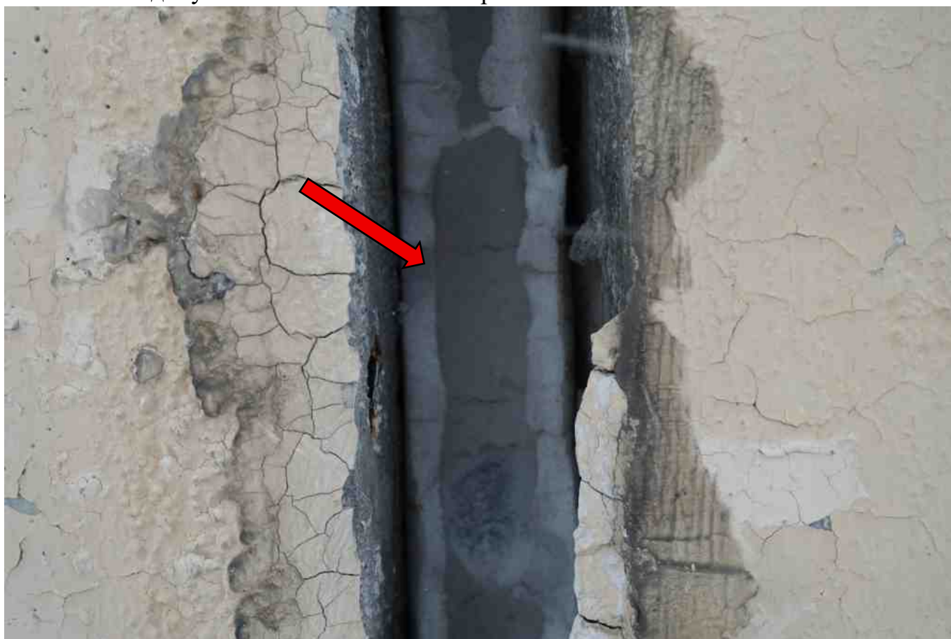
Фото 291. Недопустимое состояние вилатерма
