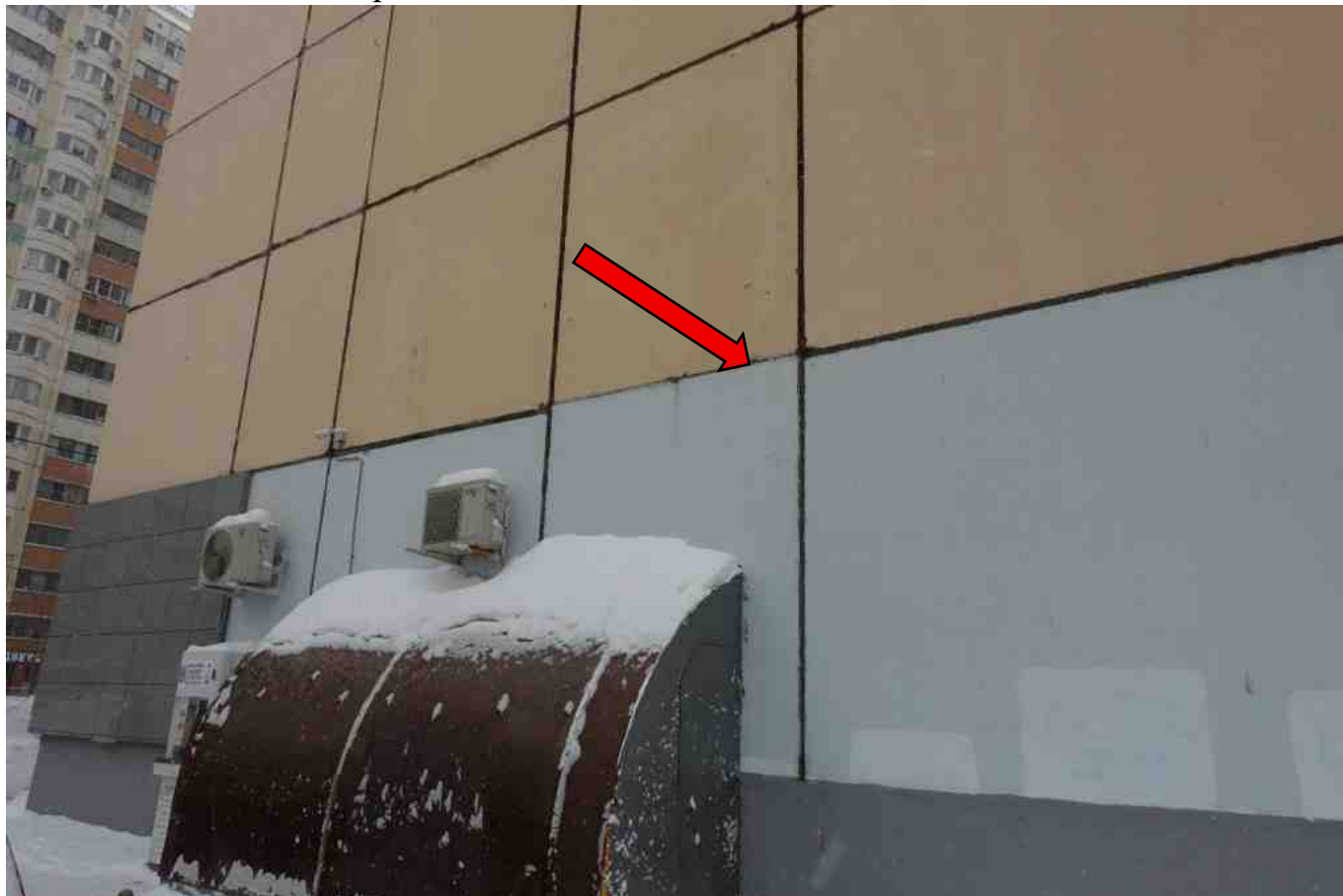
Фото 195. Разрушение, нарушение герметичности шва.
