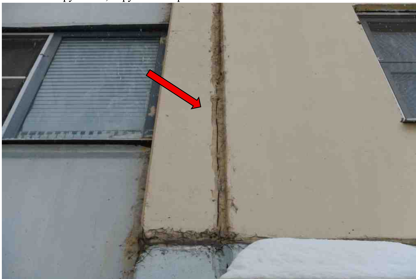
Фото 64. Разрушение, нарушение герметичности шва.
