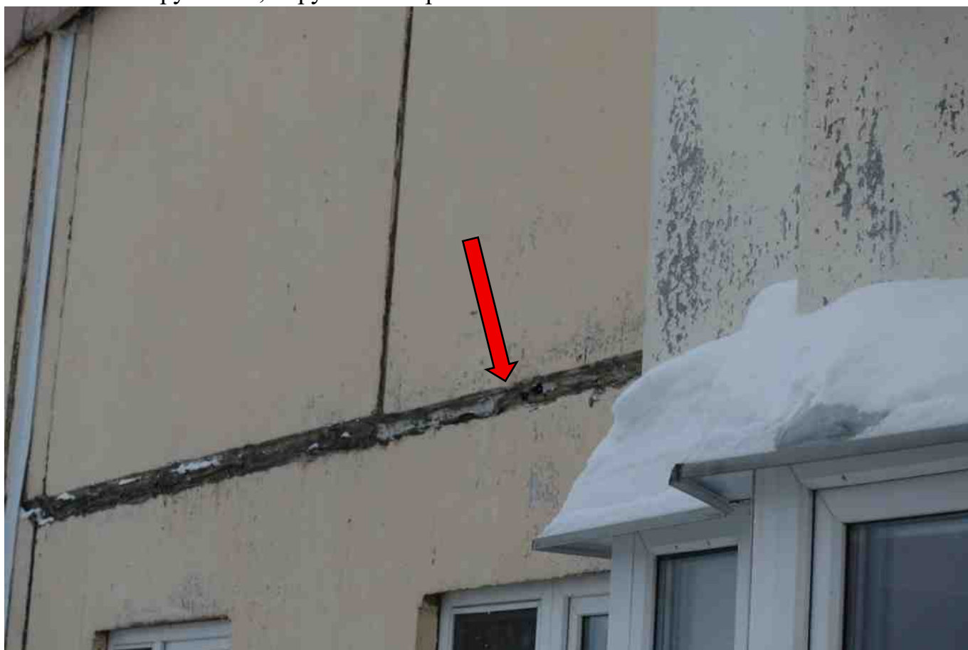
Фото 305. Разрушение, нарушение герметичности шва.
