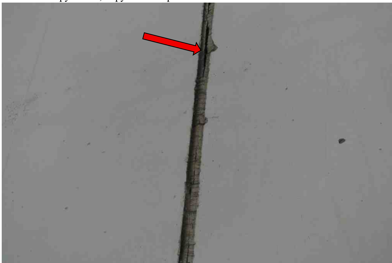
Фото 78. Разрушение, нарушение герметичности шва.
