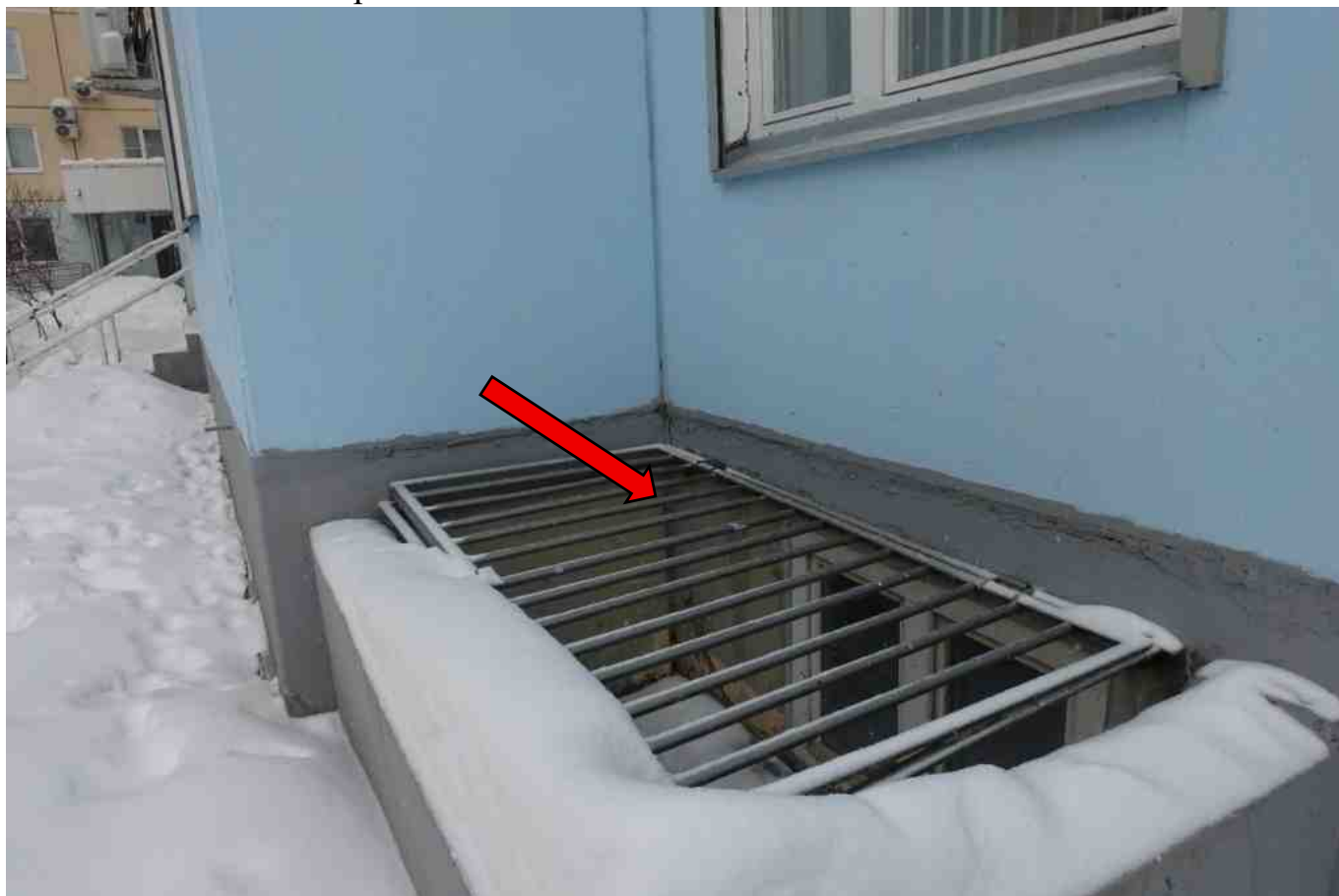
Фото 52. Разрушение, нарушение герметичности шва.
