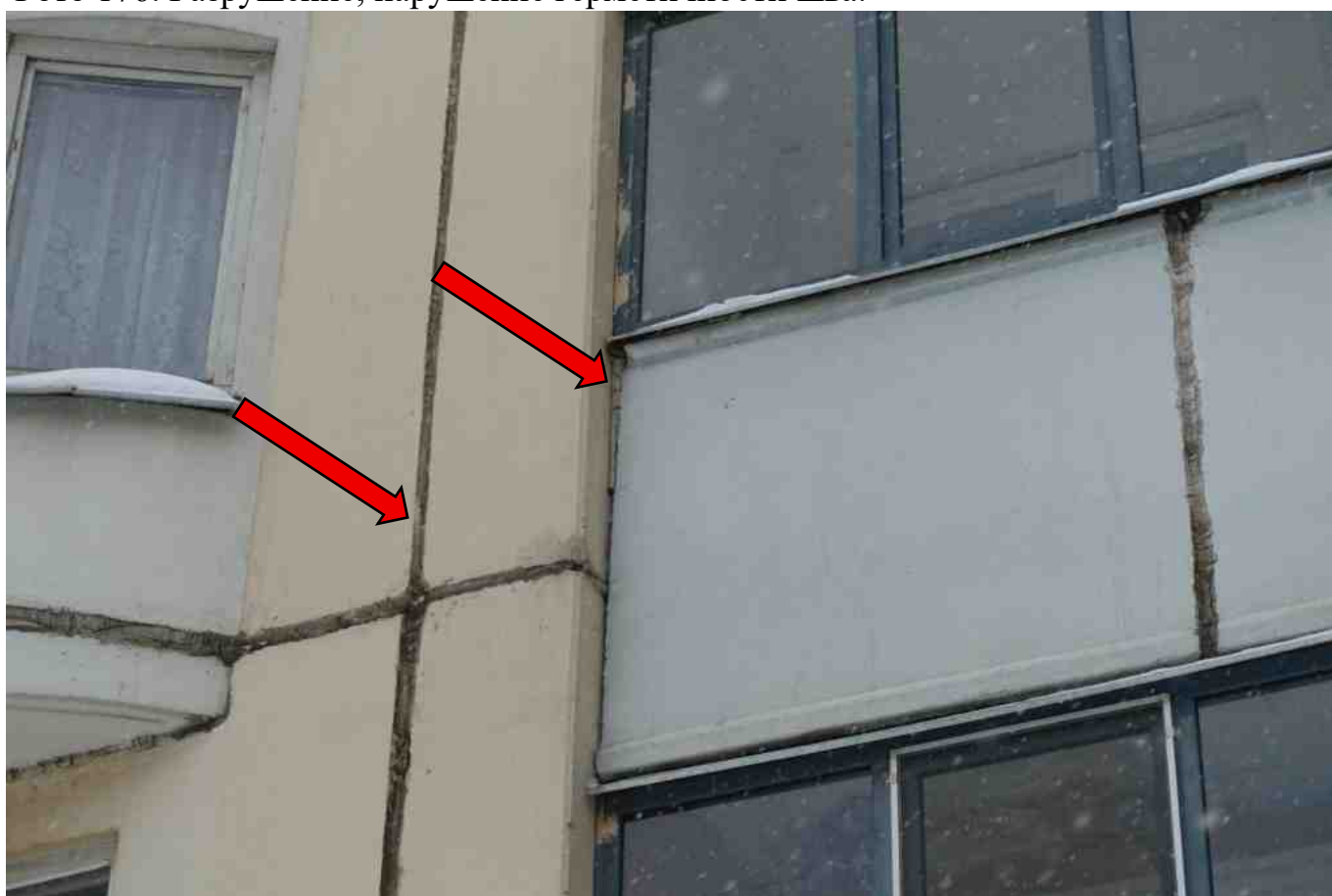
Фото 176. Разрушение, нарушение герметичности шва.
