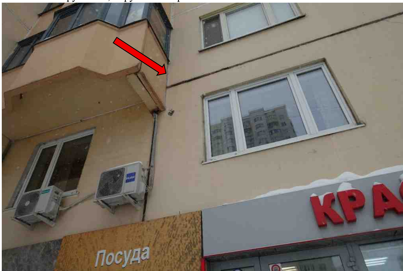
Фото 217. Разрушение, нарушение герметичности шва.
