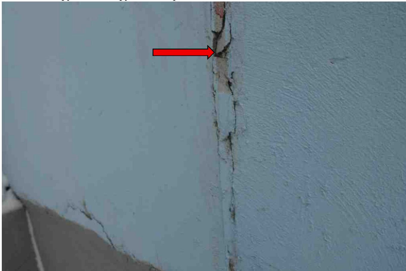
Фото 48. Разрушение целостности вилатерма, нарушение теплоизоляции шва.
