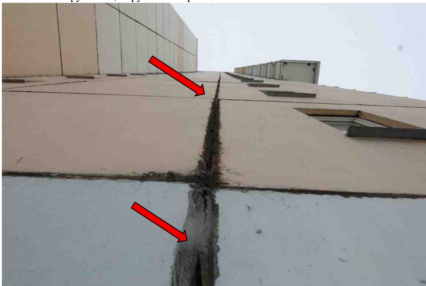
Фото 265. Разрушение, нарушение герметичности шва.
