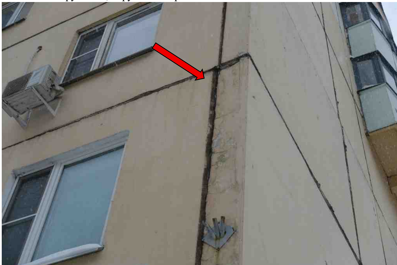
Фото 201. Разрушение, нарушение герметичности шва.
