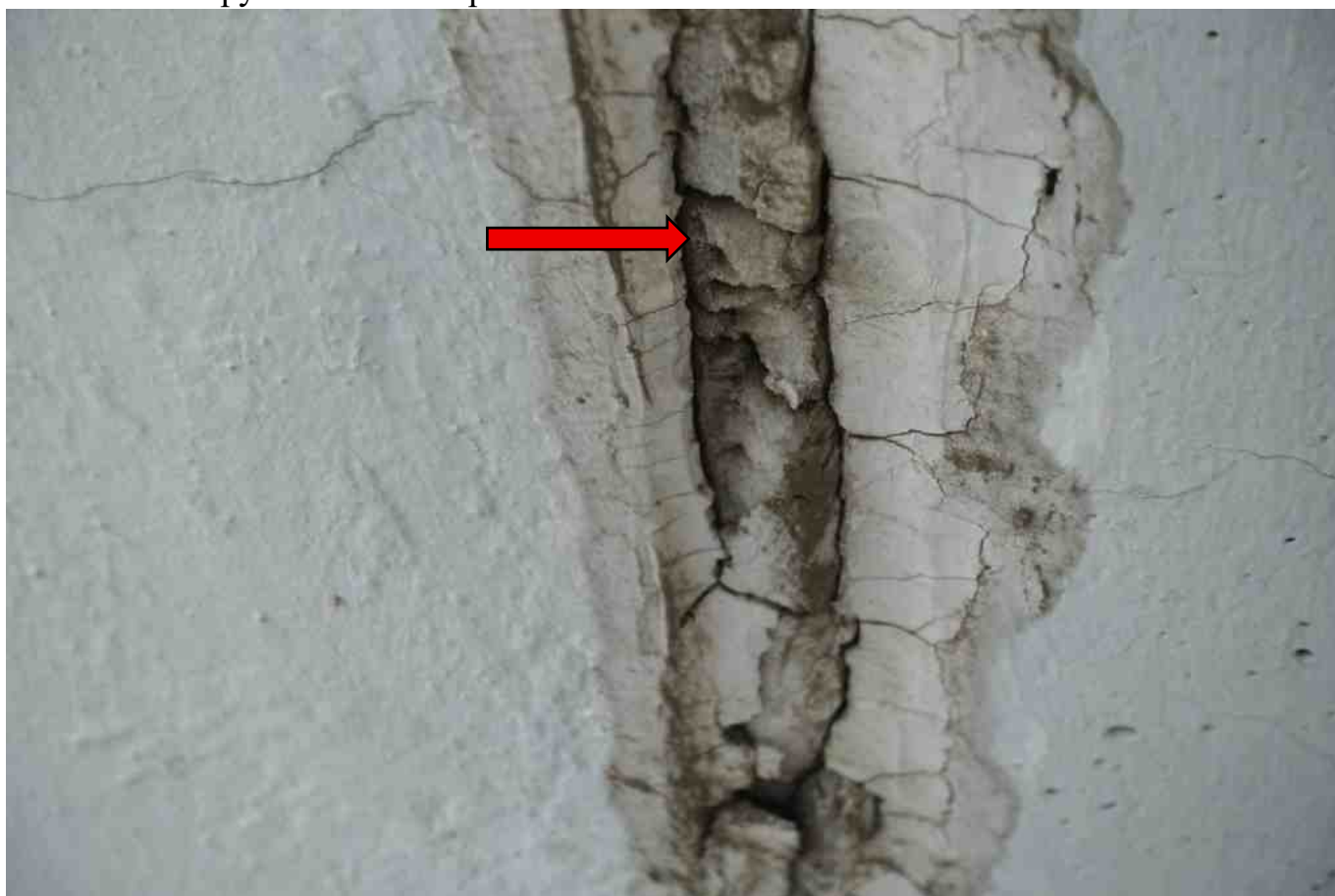
Фото 164. Разрушение вилатерма.
