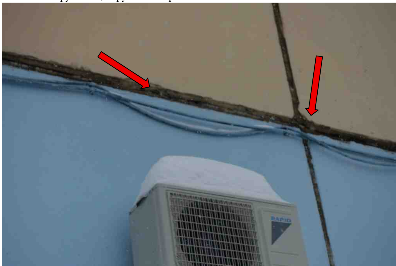
Фото 40. Разрушение, нарушение герметичности шва.
