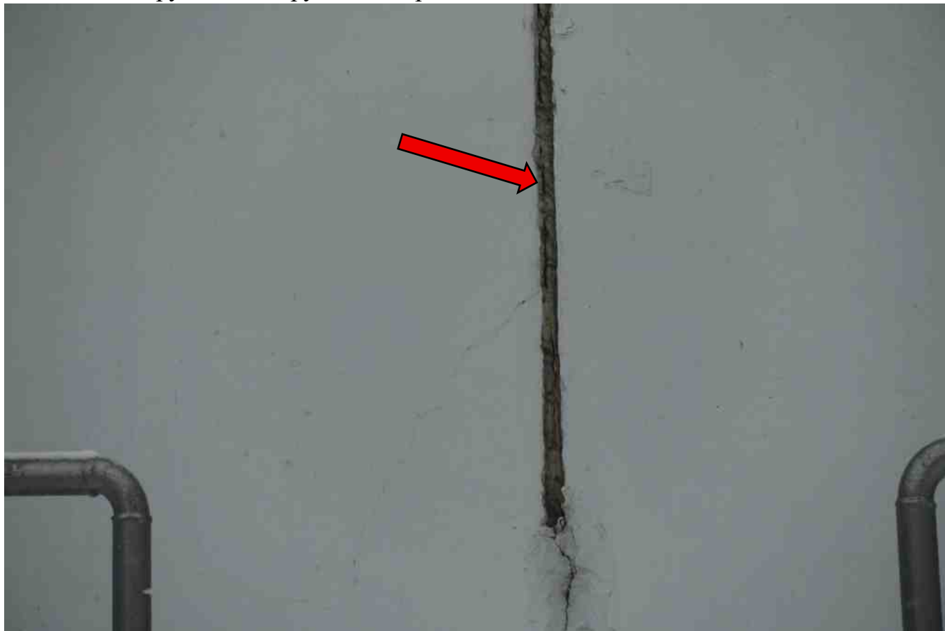
Фото 184. Разрушение, нарушение герметичности шва.
