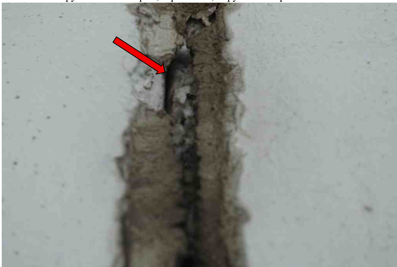
Фото 121. Разрушение вилатерма, герметика., нарушение герметичности шва.
