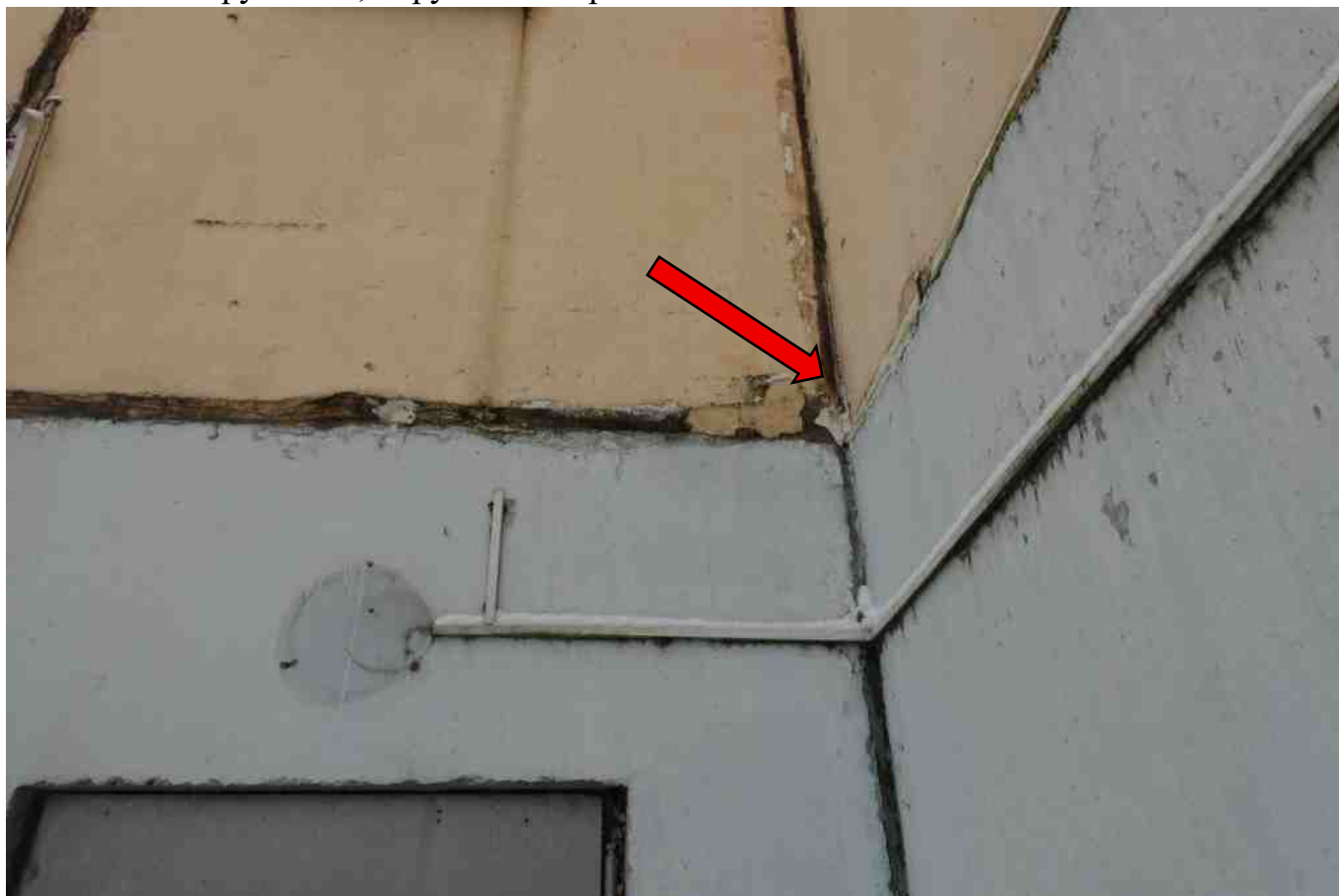
Фото 235. Разрушение, нарушение герметичности шва.
