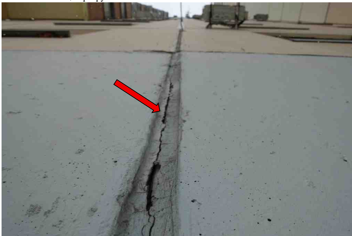
Фото 74. Фиксация разрушения шва.
