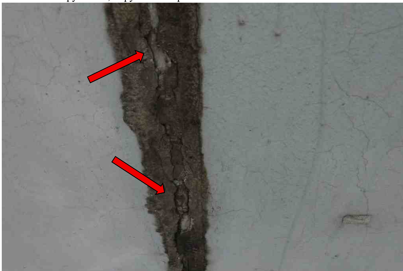
Фото 227. Разрушение, нарушение герметичности шва.
