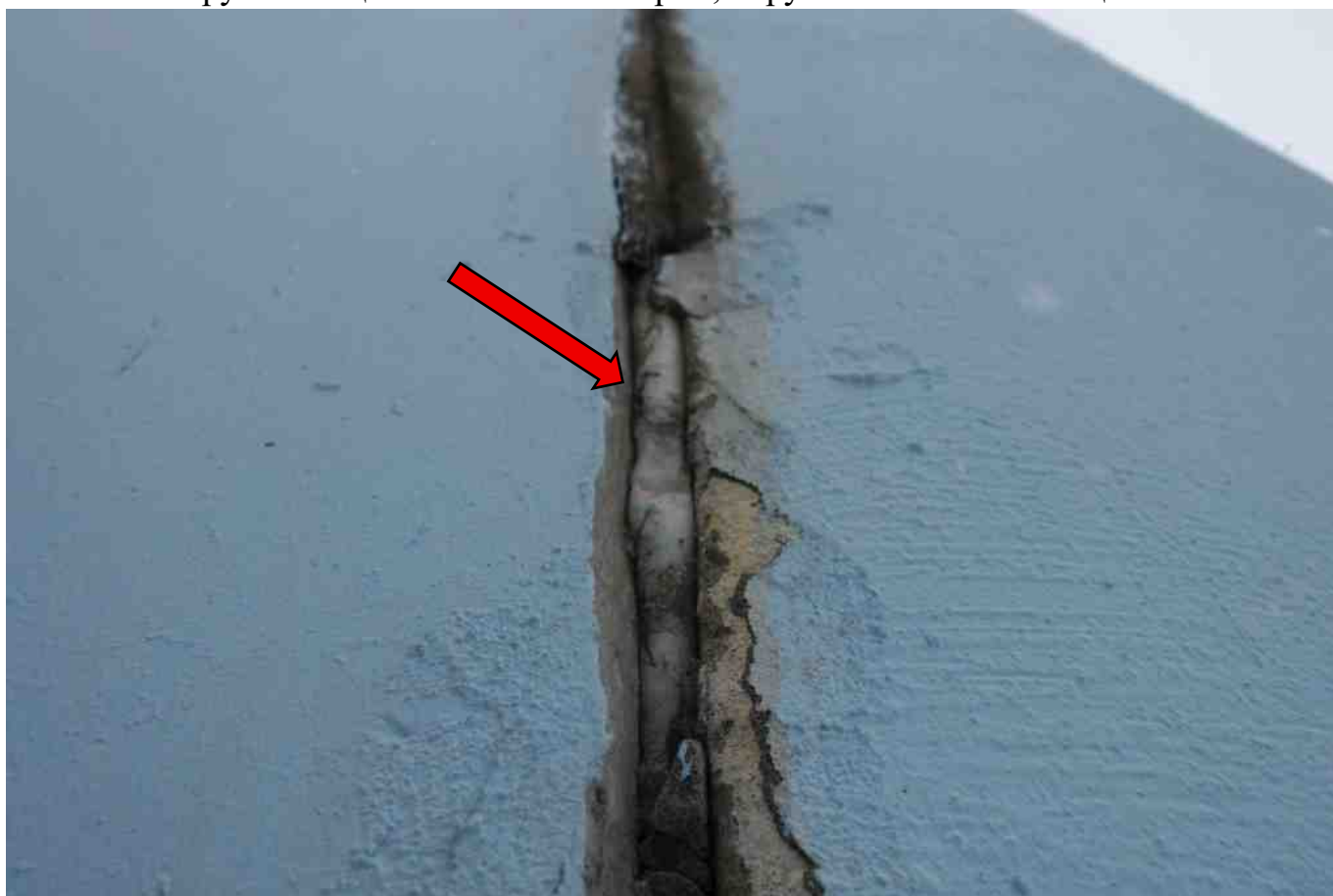
Фото 48. Разрушение целостности вилатерма, нарушение теплоизоляции шва.
