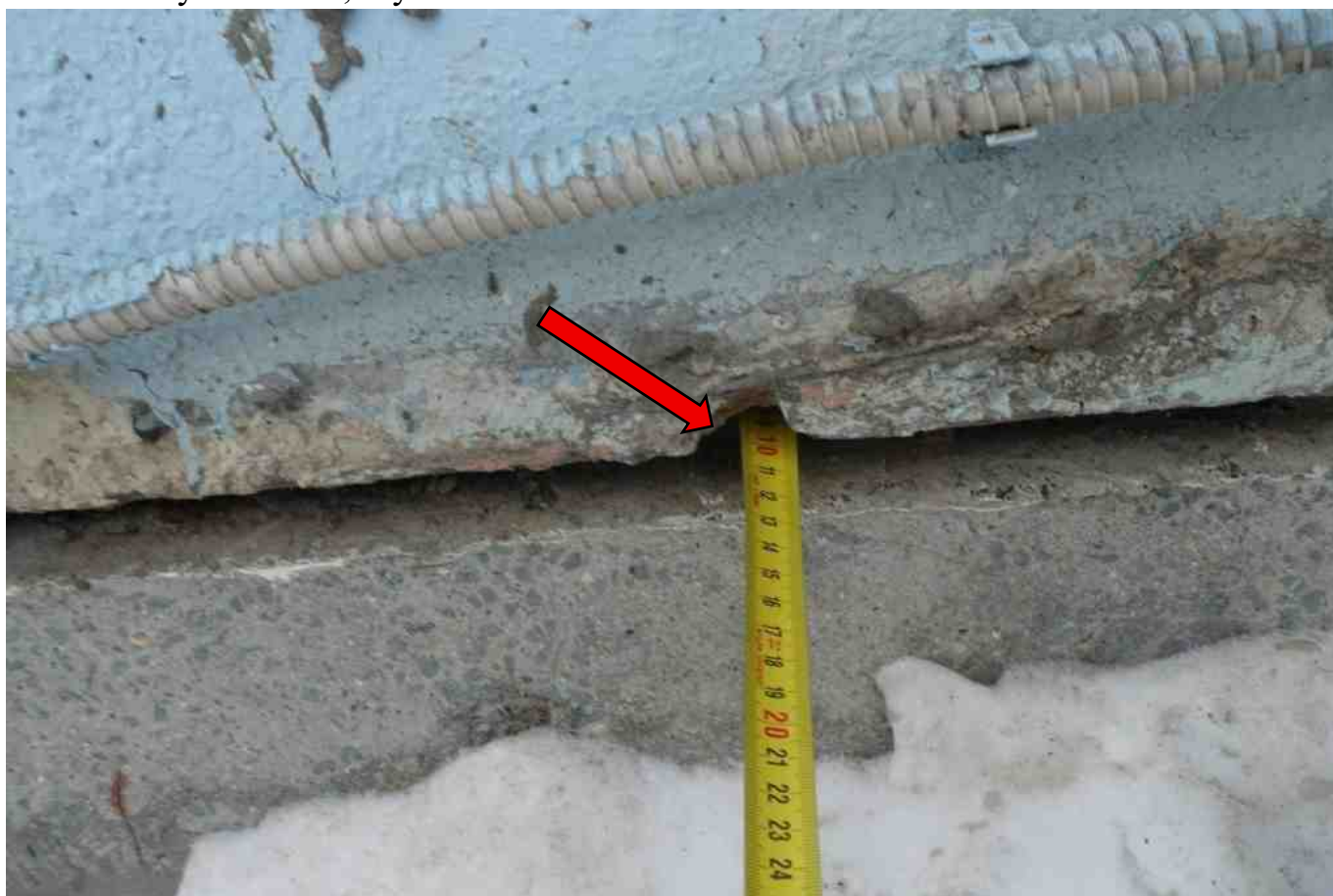
Фото 34. Пустошовка, глубина 100мм.
