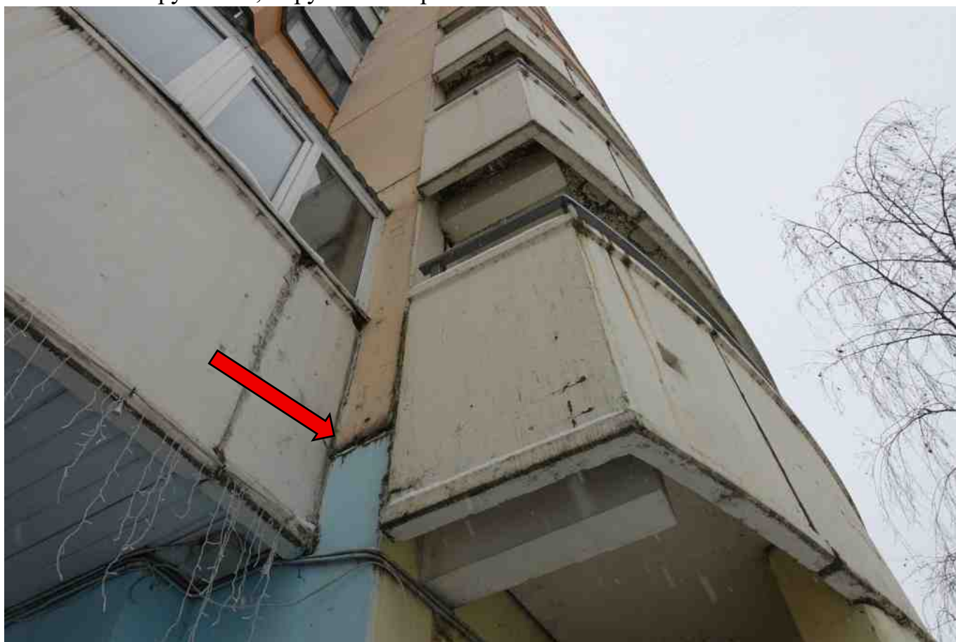
Фото 245. Разрушение, нарушение герметичности шва.
