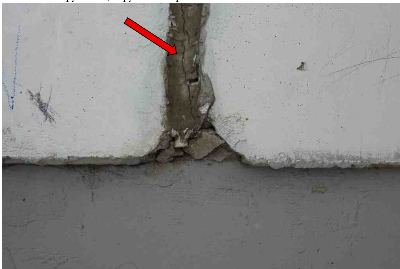
Фото 195. Разрушение, нарушение герметичности шва.
