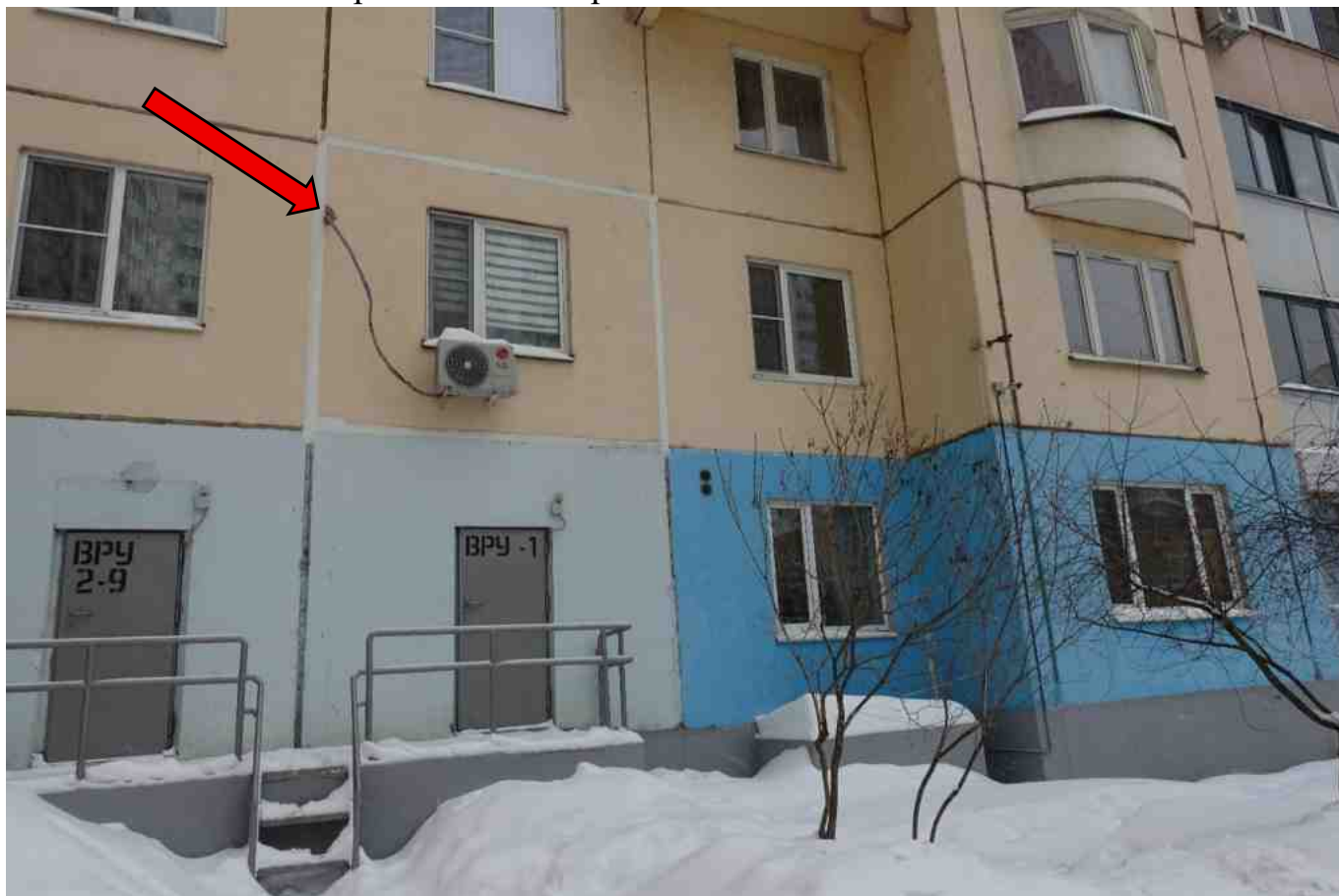
Фото 58. Разрушение, нарушение герметичности шва.
