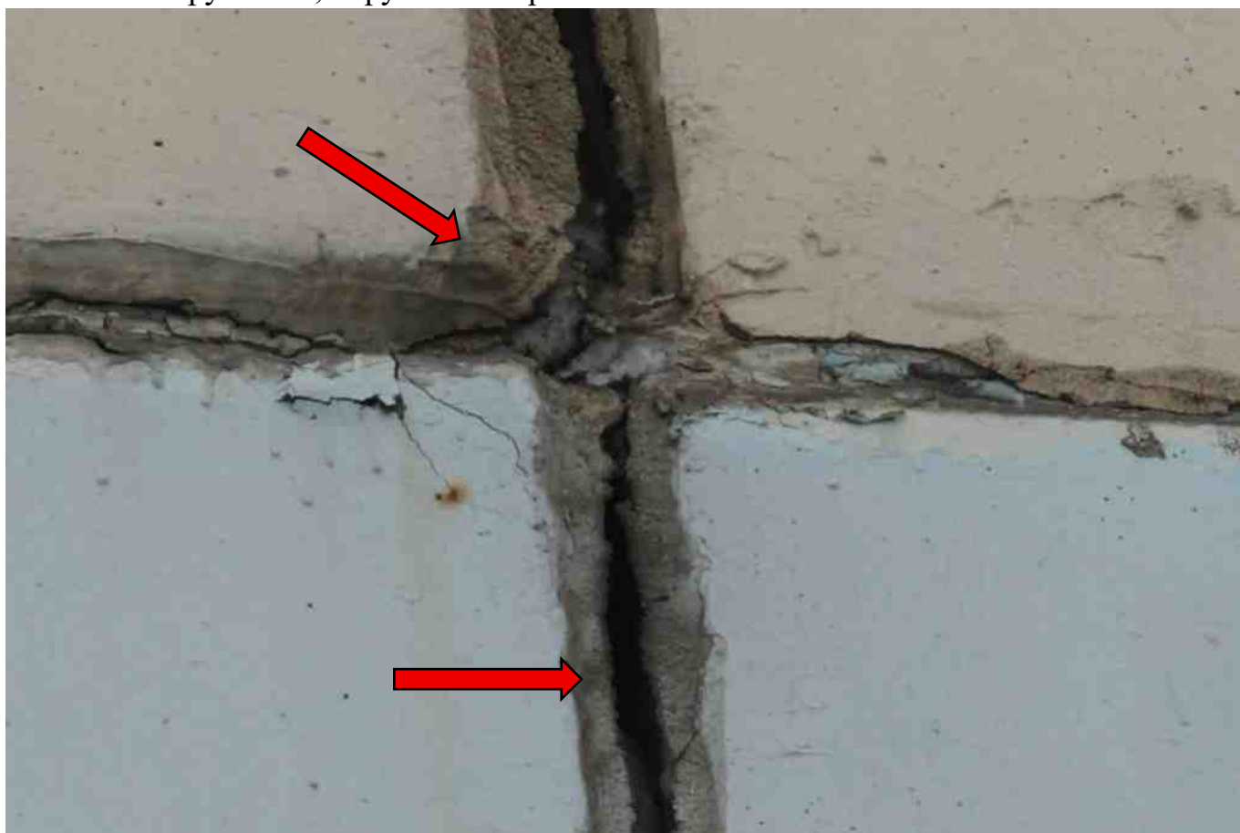
Фото 90. Разрушение, нарушение герметичности шва.
