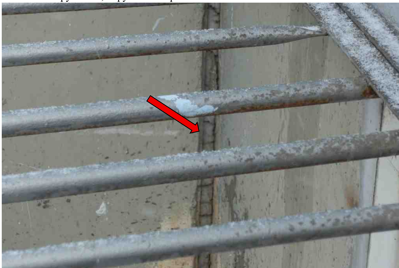
Фото 52. Разрушение, нарушение герметичности шва.
