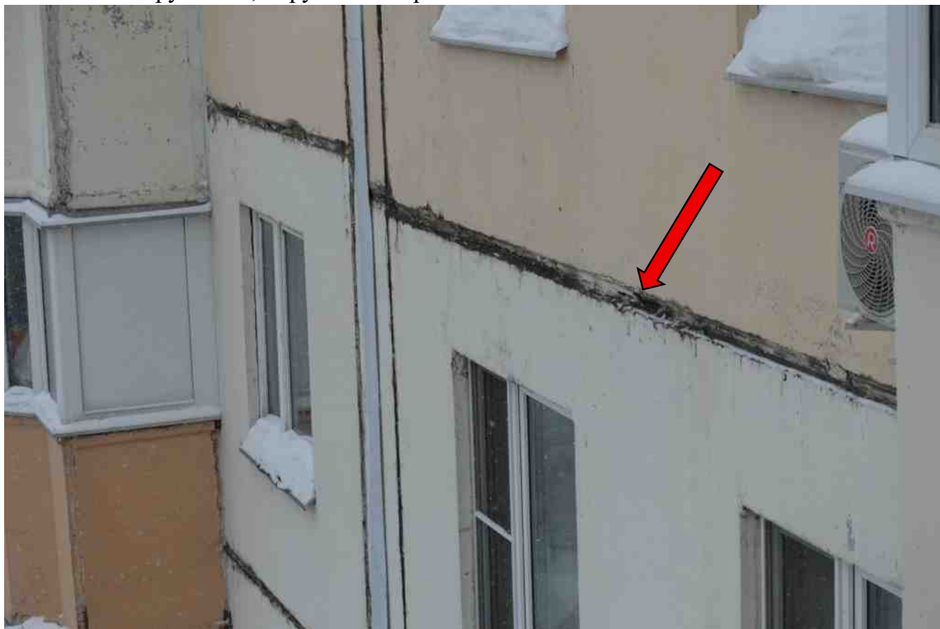
Фото 305. Разрушение, нарушение герметичности шва.
