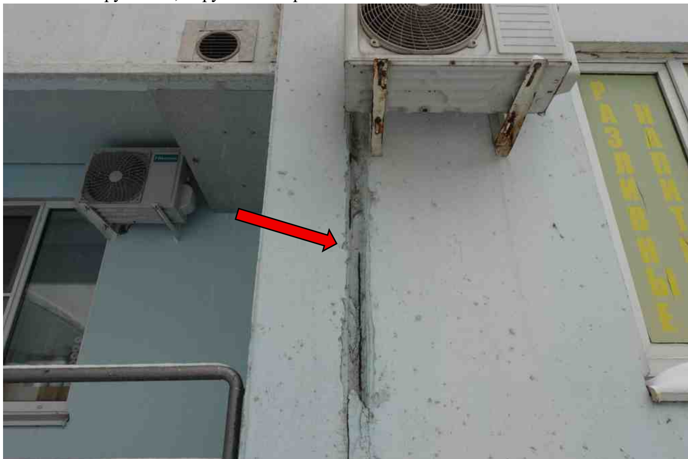
Фото 64. Разрушение, нарушение герметичности шва.
