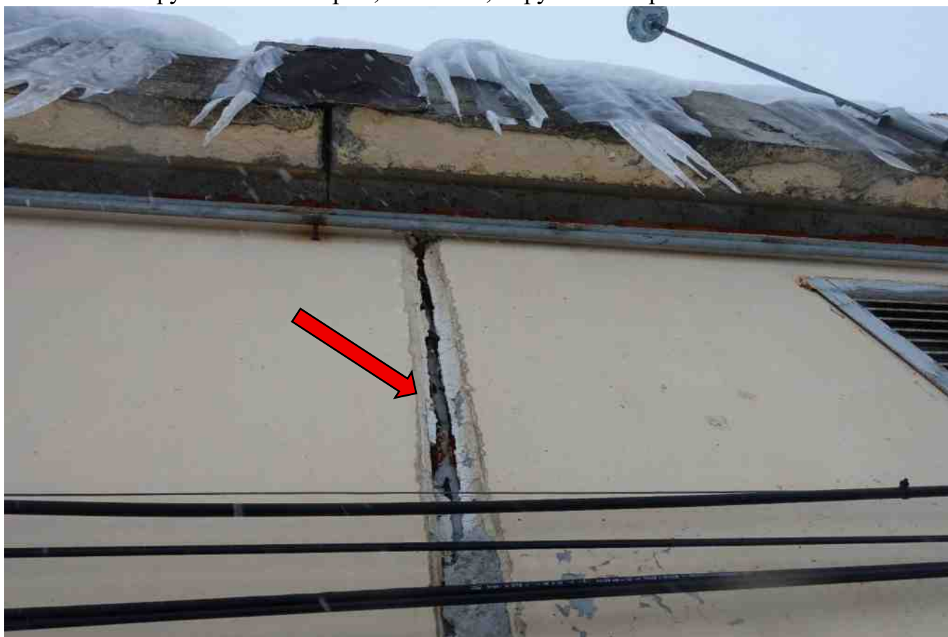
Фото 287. Разрушение вилатерма, геметика, нарушение герметичности шва.
