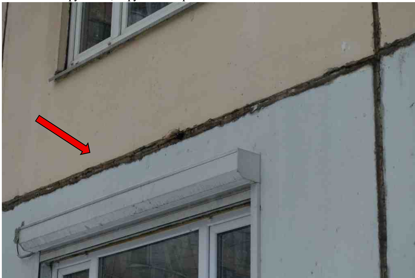
Фото 110. Разрушение, нарушение герметичности шва.
