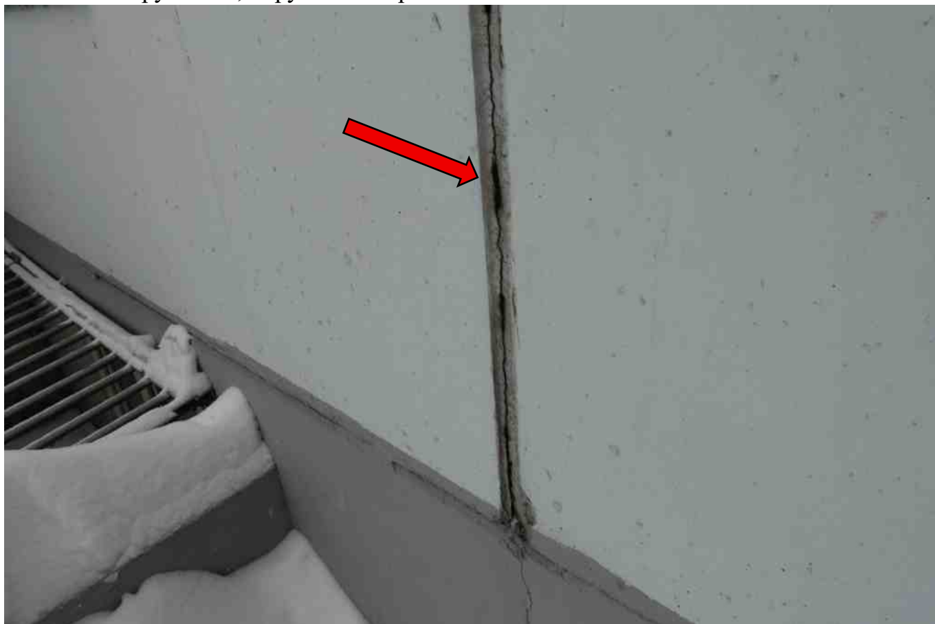
Фото 76. Разрушение, нарушение герметичности шва.
