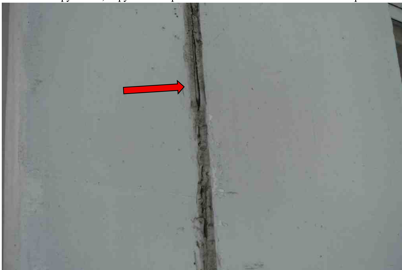
Фото 84. Разрушение, нарушение герметичности шва. Обнаженный вилатерм.
