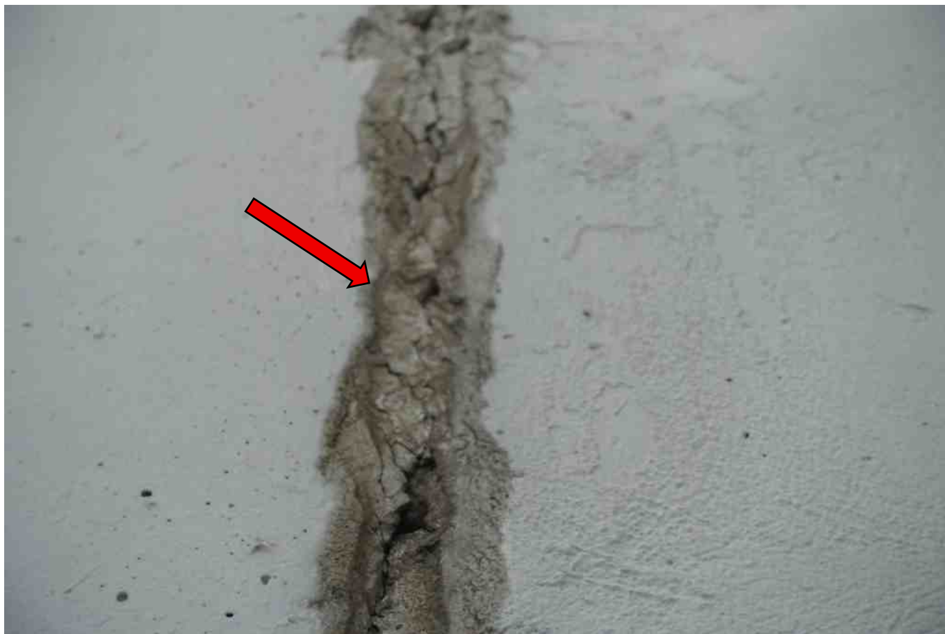
Фото 164. Разрушение вилатерма.
