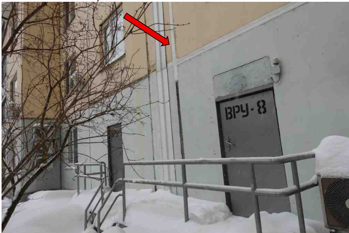
Фото 148. Разрушение, нарушение герметичности шва.
