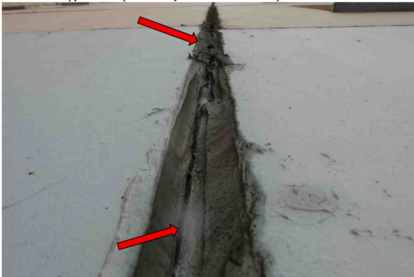
Фото 265. Разрушение, нарушение герметичности шва.
