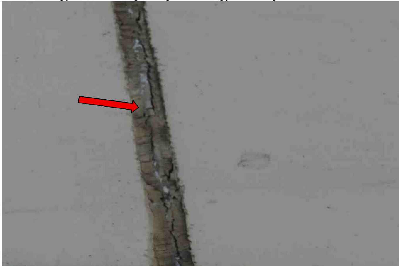
Фото 94. Разрушение, нарушение герметичности шва.
