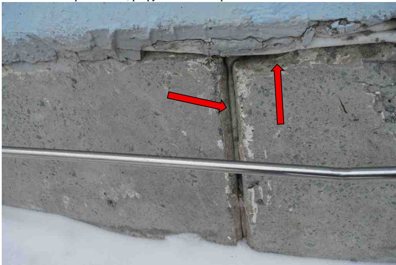
Фото 34. Пустошовка, глубина 100мм.
