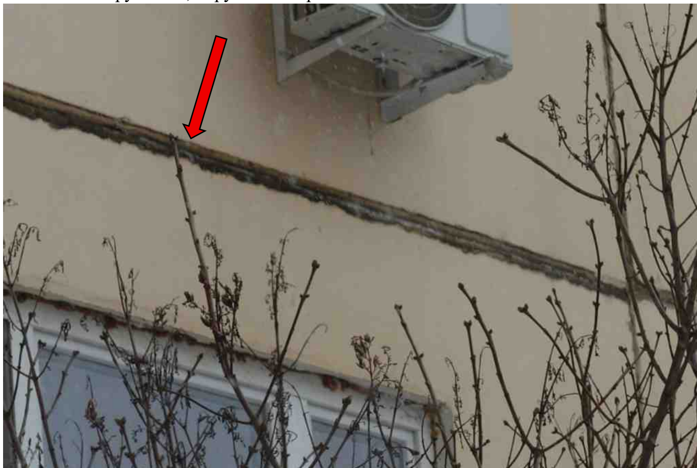
Фото 140. Разрушение, нарушение герметичности шва.
