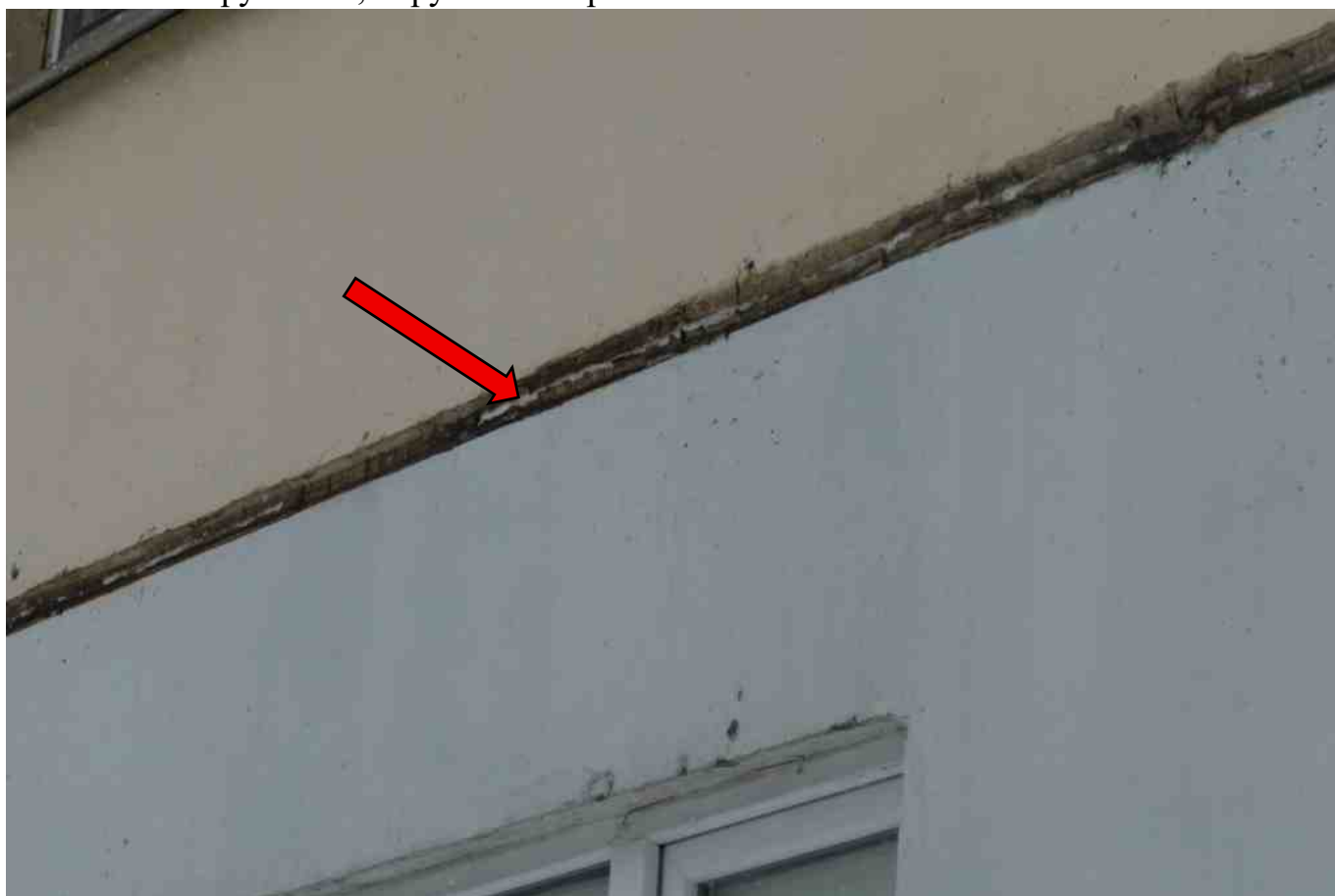
Фото 180. Разрушение, нарушение герметичности шва.
