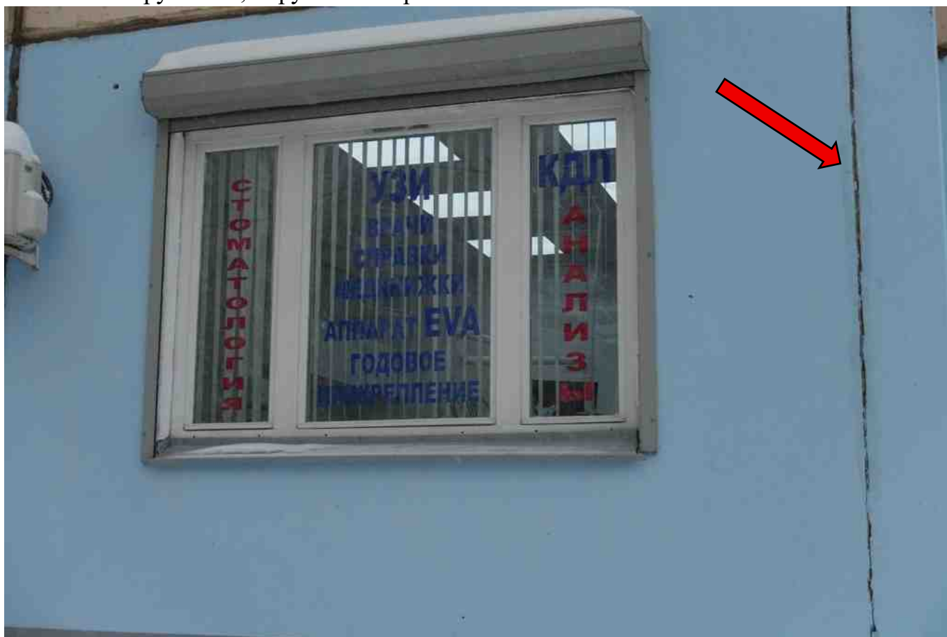
Фото 54. Разрушение, нарушение герметичности шва.
