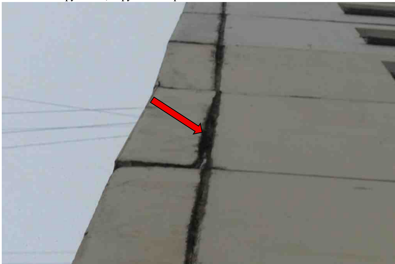
Фото 193. Разрушение, нарушение герметичности шва.
