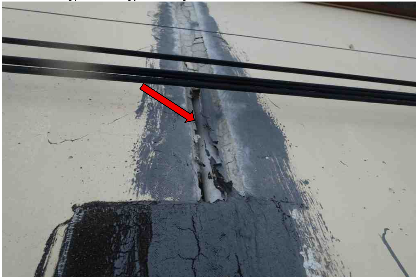
Фото 283. Разрушение, нарушение герметичности шва.
