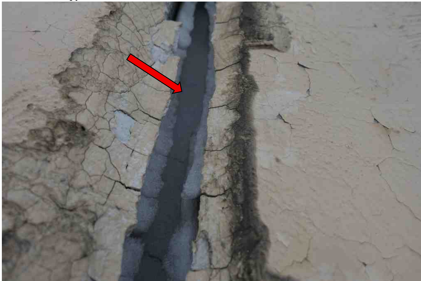
Фото 293. Разрушение монтажного межпанельного шва.
