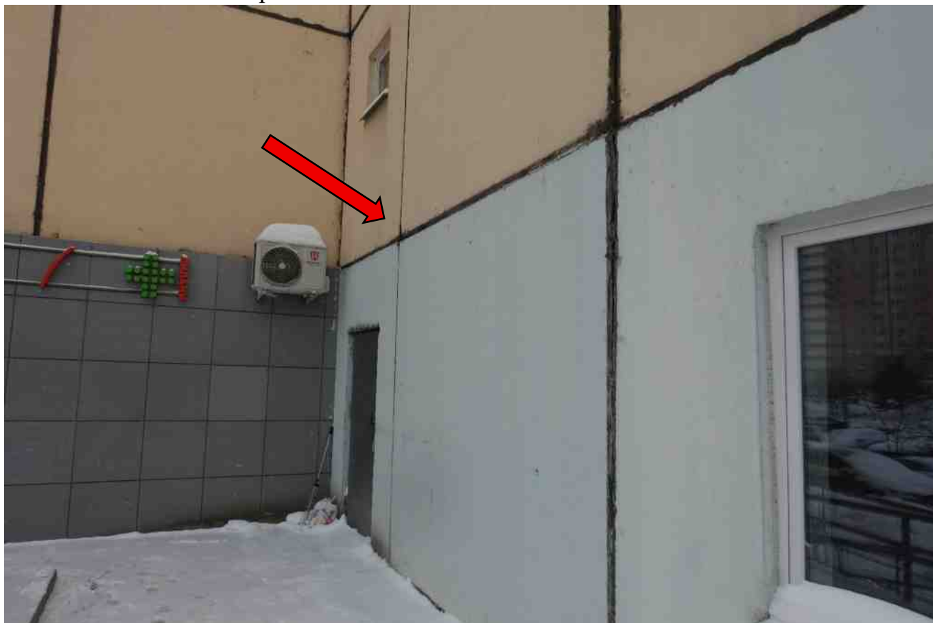
Фото 263. Разрушение, нарушение герметичности шва.
