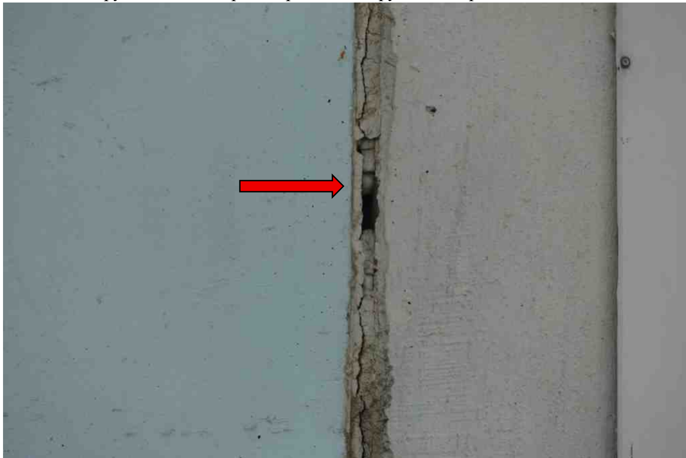
Фото 98. Разрушение, нарушение герметичности шва.
