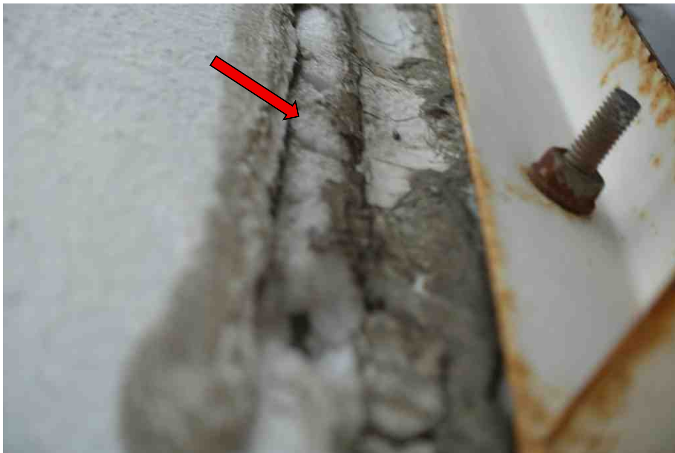
Фото 166. Разный состав заполнения межпанельных швов.
