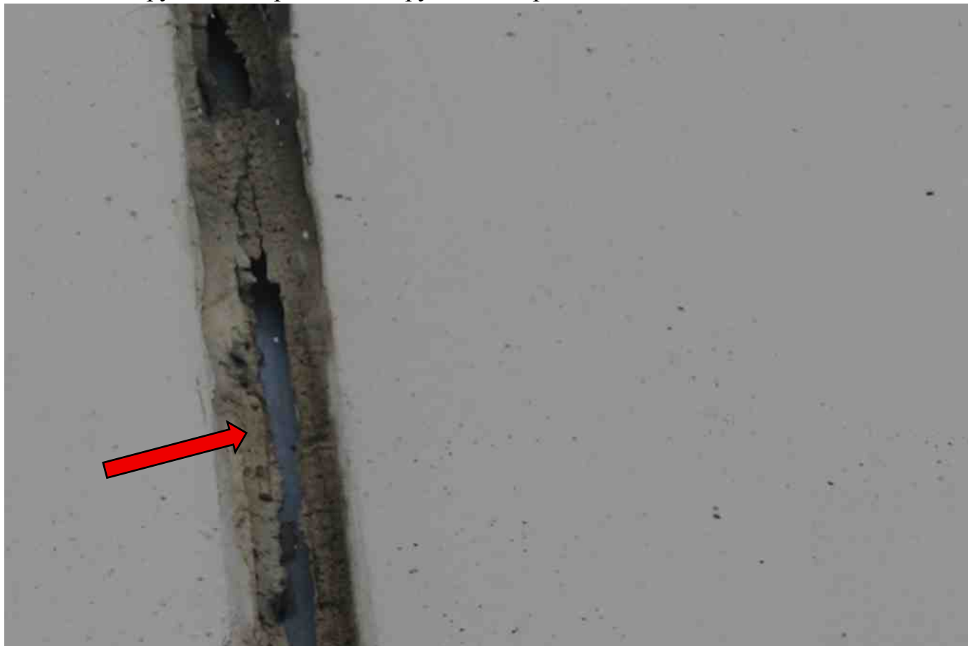
Фото 92. Разрушение, нарушение герметичности шва.
