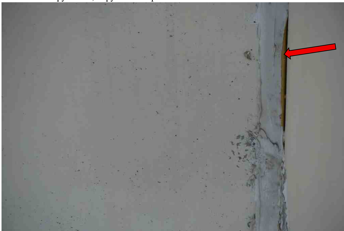
Фото 279. Разрушение, нарушение герметичности шва.
