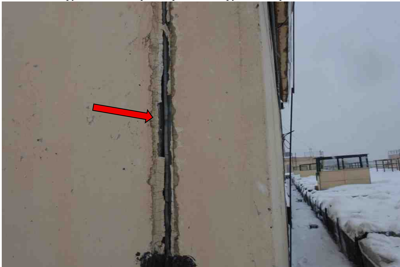
Фото 291. Недопустимое состояние вилатерма
