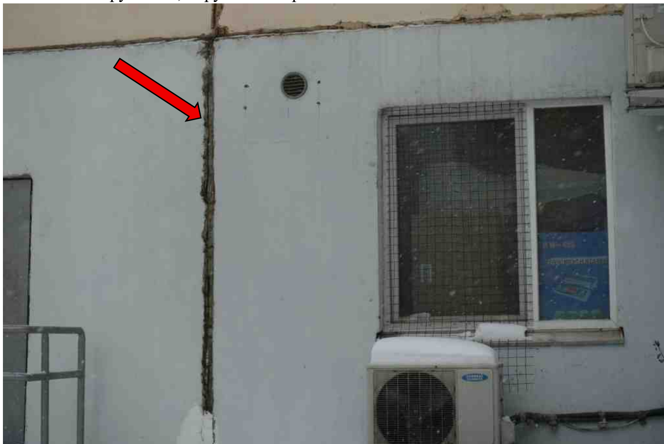
Фото 182. Разрушение, нарушение герметичности шва.
