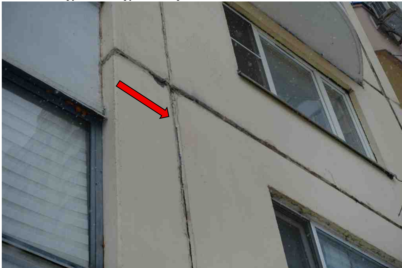
Фото 160. Разрушение, нарушение герметичности шва.
