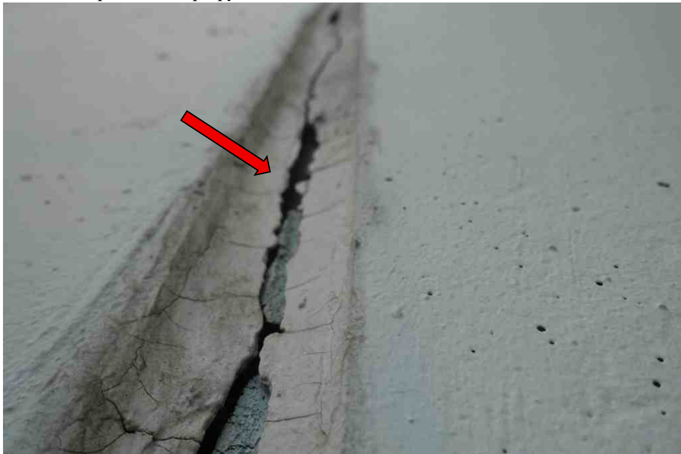
Фото 74. Фиксация разрушения шва.
