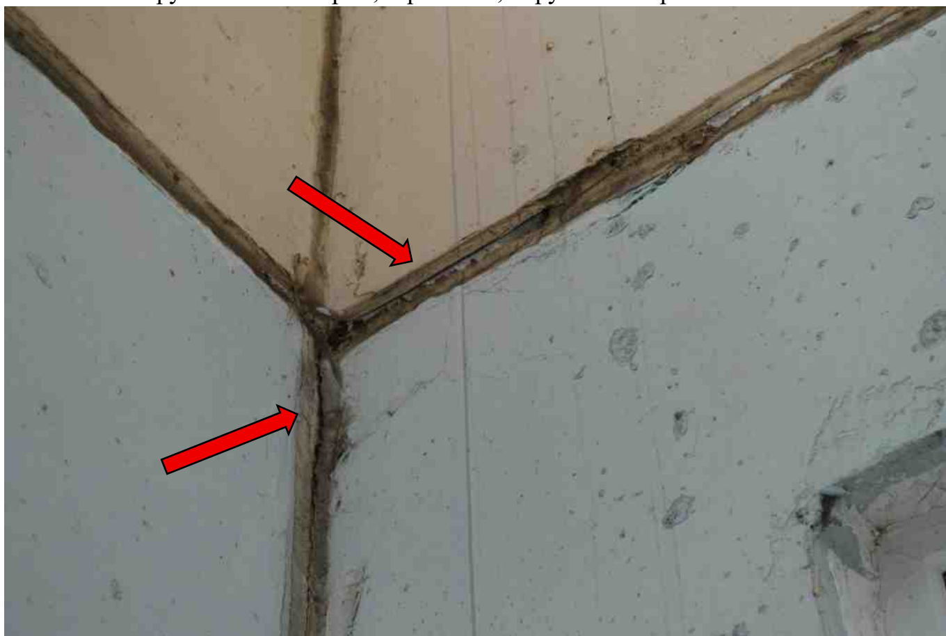
Фото 100. Разрушение вилатерма, герметика, нарушение герметичности шва.
