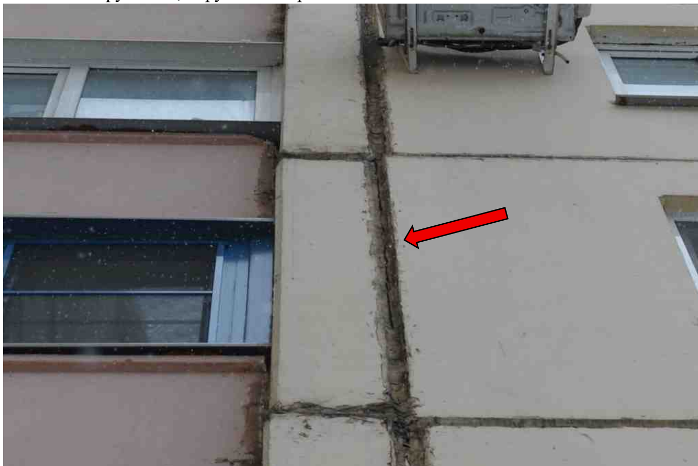
Фото 66. Разрушение, нарушение герметичности шва.
