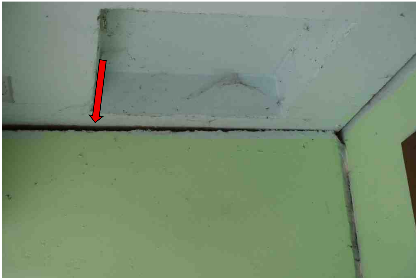
Фото 140. Разрушение, нарушение герметичности шва.
