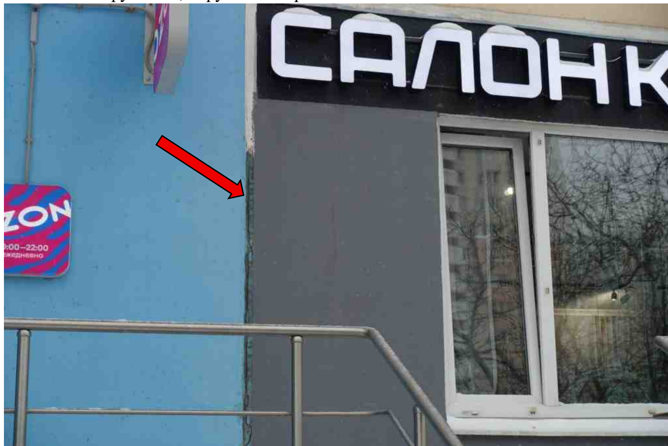
Фото 275. Разрушение, нарушение герметичности шва.
