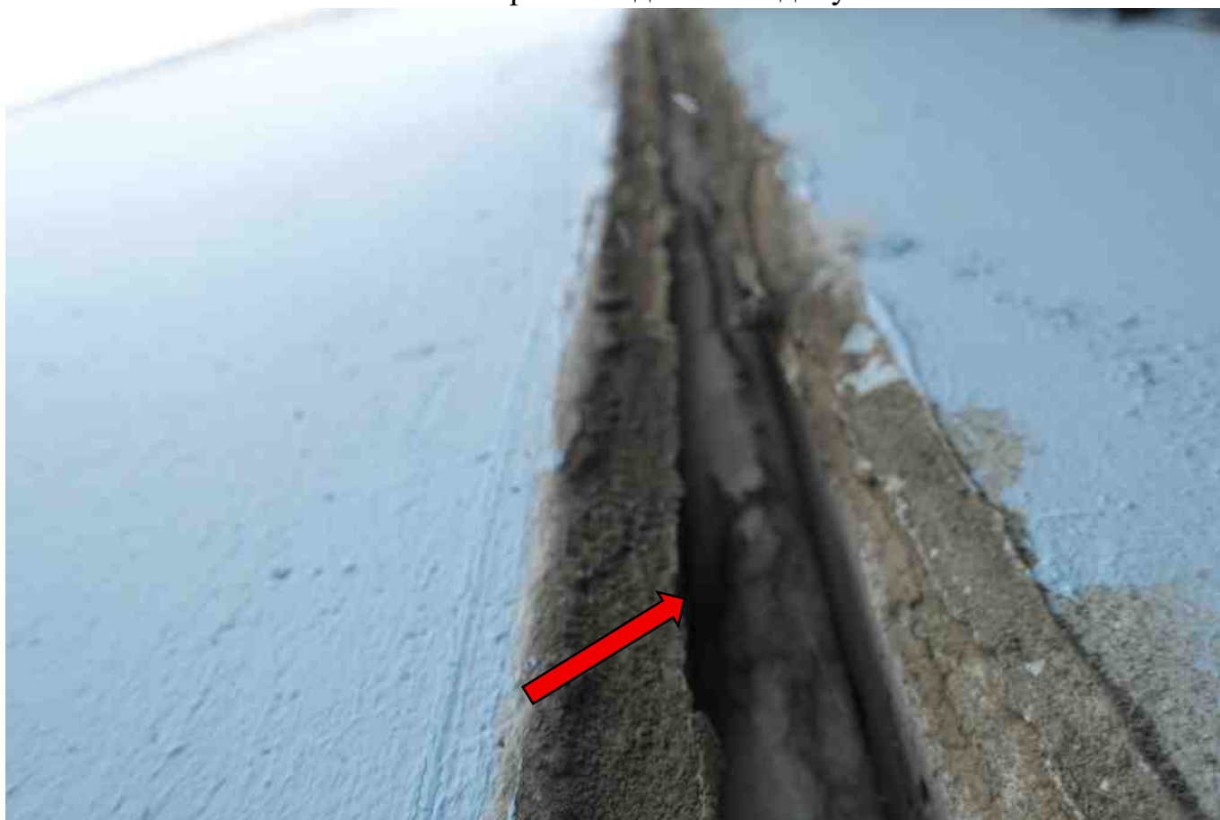
Фото 44. Заполнение шва из вилатерма находится в недопустимом состоянии.
