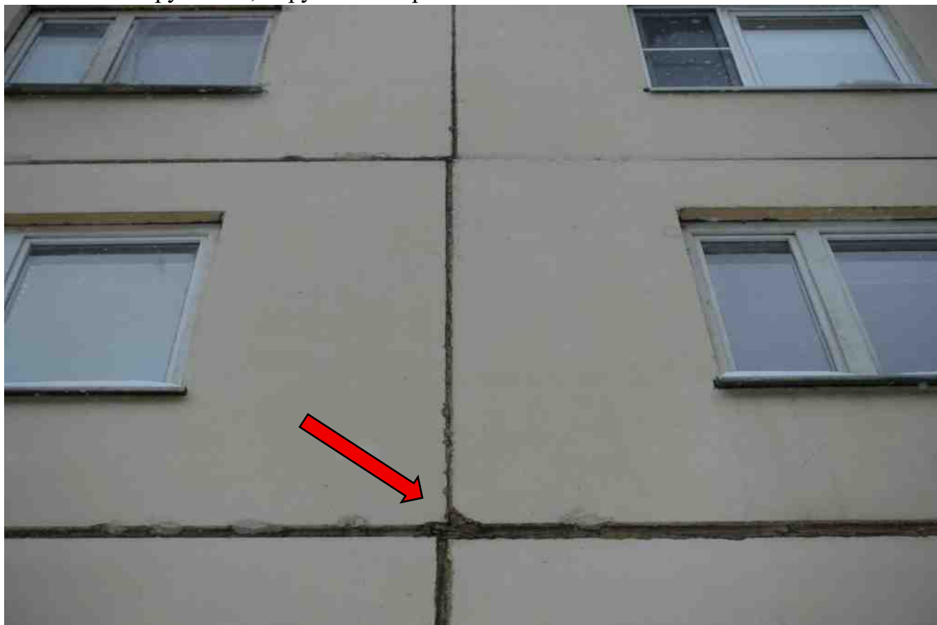
Фото 185. Разрушение, нарушение герметичности шва.
