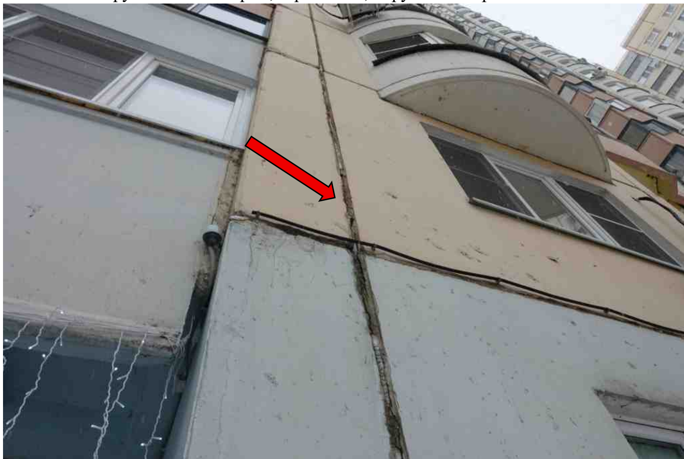
Фото 106. Разрушение вилатерма, герметика., нарушение герметичности шва.
