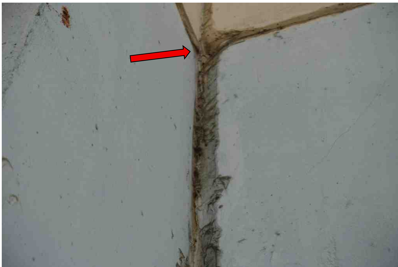
Фото 166. Разный состав заполнения межпанельных швов.
