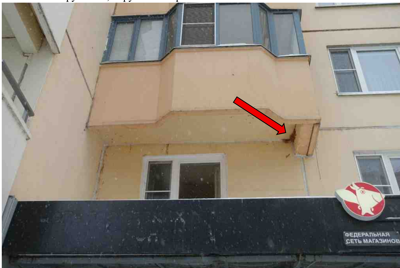
Фото 247. Разрушение, нарушение герметичности шва.
