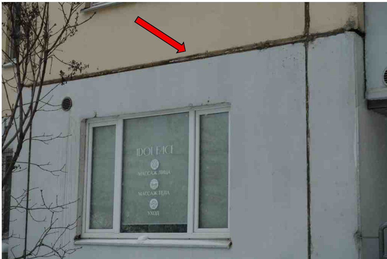
Фото 180. Разрушение, нарушение герметичности шва.
