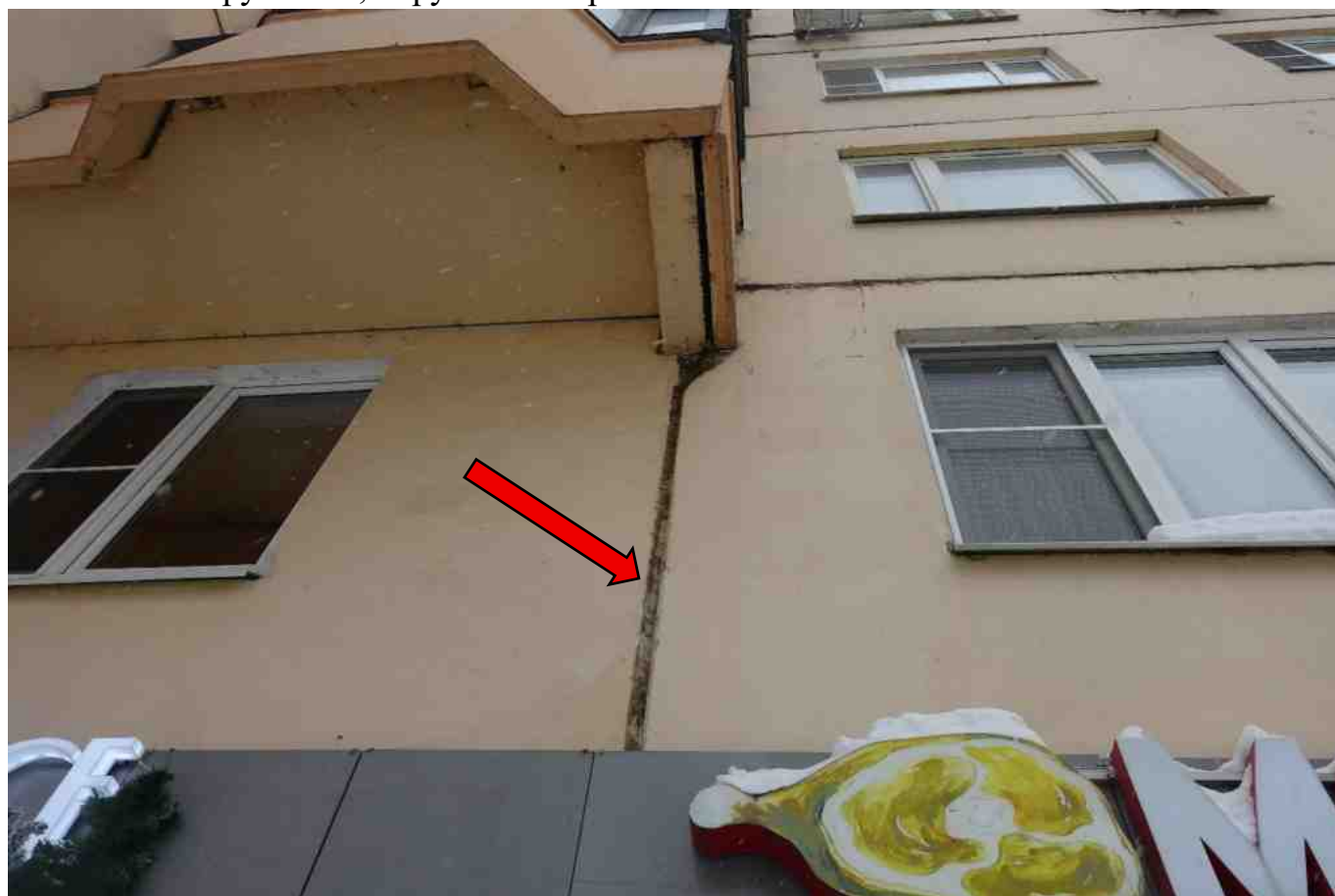
Фото 209. Разрушение, нарушение герметичности шва.
