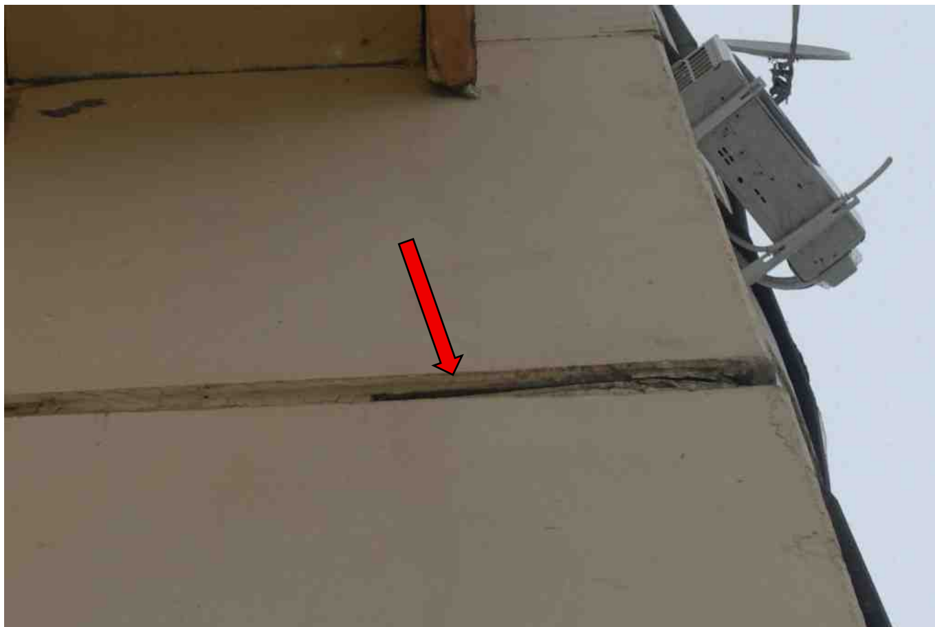
Фото 170. Разрушение, нарушение герметичности шва.
