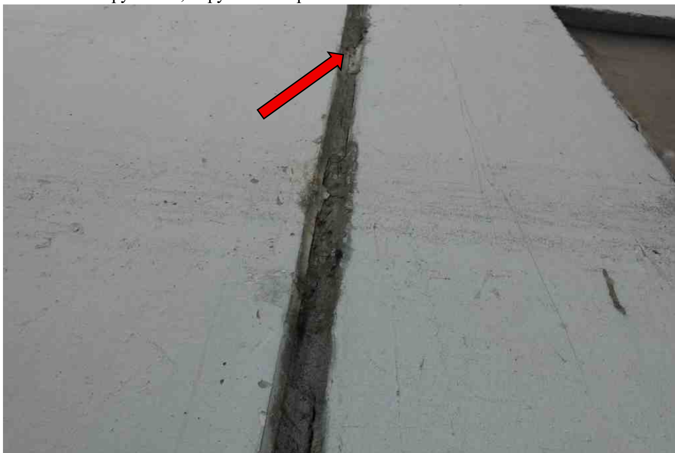
Фото 237. Разрушение, нарушение герметичности шва.
