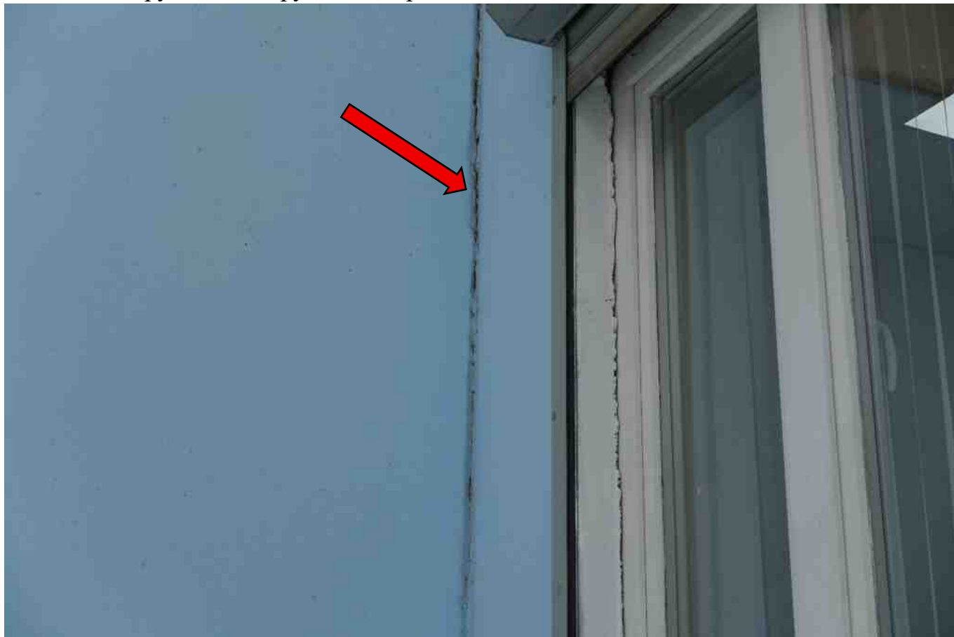
Фото 54. Разрушение, нарушение герметичности шва.
