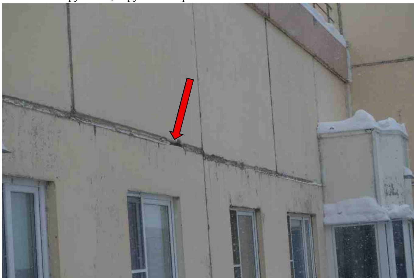
Фото 303. Разрушение, нарушение герметичности шва.
